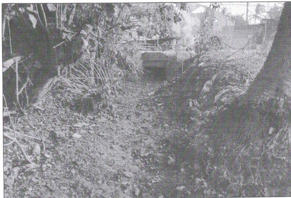
Ingreso de canal en alcantarilla en mal estado.
