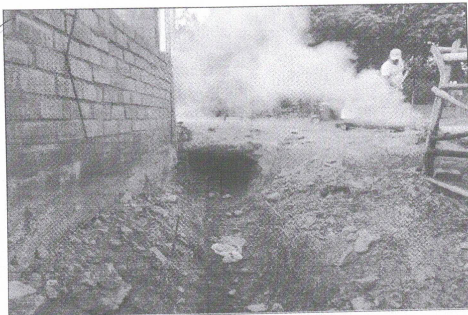
Salida de canal en alcantarilla en mal estado.
