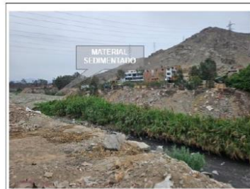
FIGURA N° 02: MATERIAL COLMATADO EN EL CAUCE DEL RÍO RIMAC, CON UNA PROFUNDIDAD APROX. 20CM. ESTO PROVOCA QUE DESBORDAMIENTO DE LA QUEBRADA SEA MAS INMINENTE EN AMBAS MARGENES.
