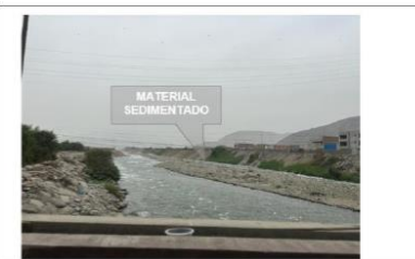
FIGURA N° 01: MATERIAL COLMATADO EN EL CAUCE DEL RÍO RIMAC CON UNA PROFUNDIDAD APROX. 1.50M. ESTO PROVOCA QUE DESBORDAMIENTO EN LOS MARGENES SEA MAS INMINENTE.
