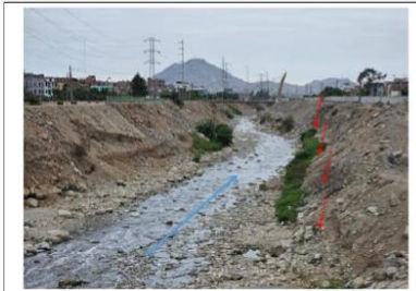
FIGURA N° 01: TRAMO CRÍTICO DEL RÍO RIMAC, DONDE SE REDUCE EL CAUCE DEL RÍO RIMA Y CURVAS QUE AUMENTAN LA VELOCIDAD DEL FLUJO DEL RÍO RIMAC. SECTOR PUENTE LAS LOMAS, DISTRITO DE EL AGUSTINO - PROVINCIA DE LIMA - DEPARTAMENTO DE LIMA.
