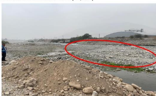
FIGURA N°01: COLMATACIÓN DE MATERIAL PROPIO EN EL CAUCE DEL RIO
