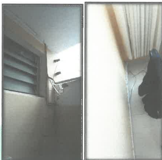
FOTOGRAFIA N°21 y 22. Cámaras mal ubicados el cual solo cubre una angulo pequeño de enfoque, también se aprecia cables sueltos tirados en el piso.
