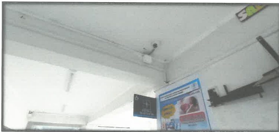
FOTOGRAFIA N°11. Pésimas condiciones del estado actual de los cables de DATA, canaletas deterioradas y cámaras de seguridad mal ubicadas.
