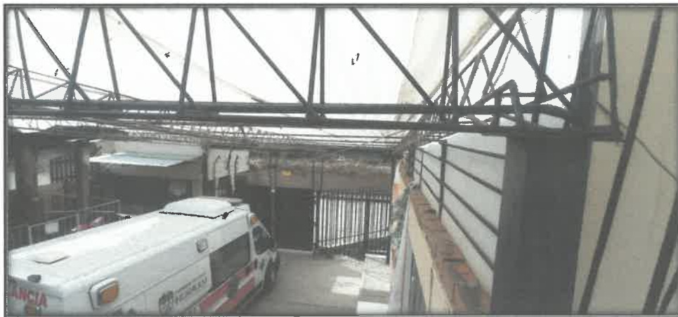
FOTOGRAFIA N°33. Cables de data que están colgados sin una canaleta ni montantes.
