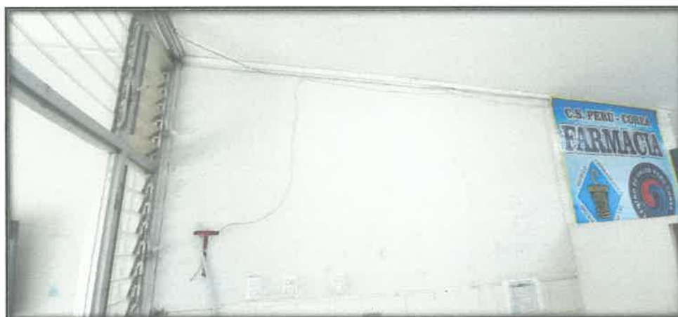
FOTOGRAFIA N°75. Cables de datos sin canalizador expuestos.
