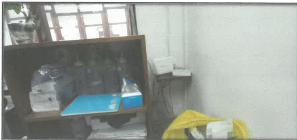
FOTOGRAFIA N°29. Modem de internet mal ubicado y se aprecia cables sueltos sin un canaletas.
