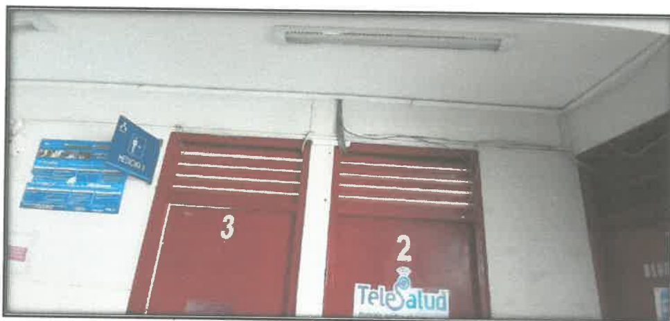
FOTOGRAFIA N°05. Cables de data se encuentran sin canalizador y expuesto a la intemperie en el consultorio 2 y 3.
