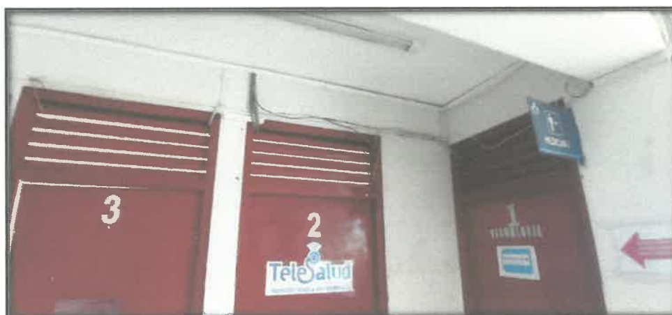
FOTOGRAFIA N°69. Cables de data sin ningún canalizador.
