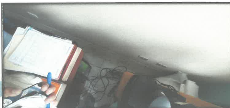
FOTOGRAFIA N°67. Cables suelto sin ningún canalizador y edificación de cada cableado.
