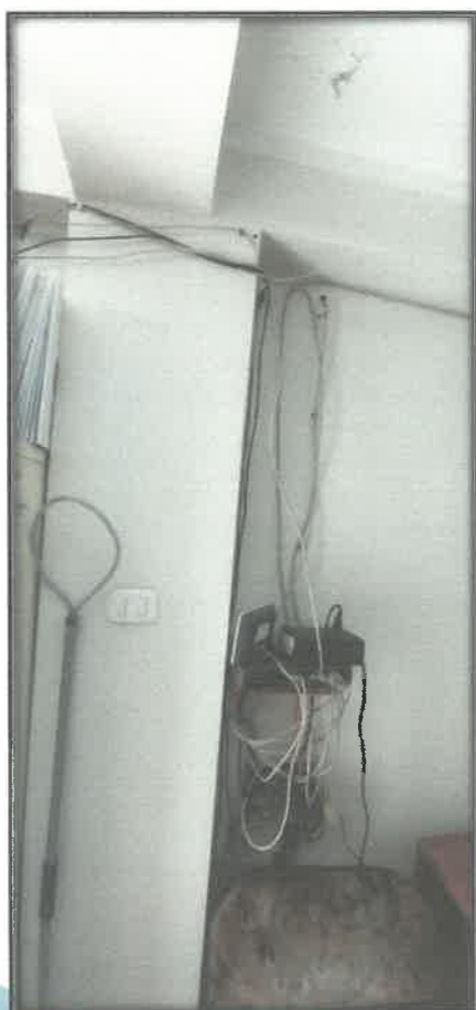
FOTOGRAFIA N°39 y 40 . Pésimas condiciones del estado actual de los cables de DATA, canaletas deterioradas y cámaras de seguridad mal ubicadas.
