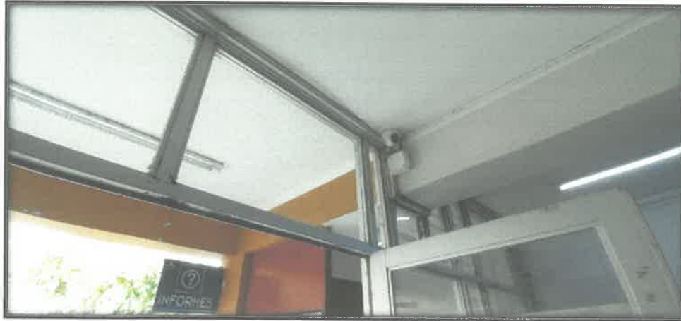
FOTOGRAFIA N°10. Cámaras de seguridad mal ubicadas el cual no hay visibilidad total de los ambientes distribuidos.
