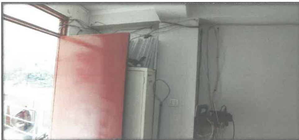
FOTOGRAFIA N°38. Pésimas condiciones del estado actual de los cables de DATA, canaletas deterioradas y cámaras de seguridad mal ubicadas.
