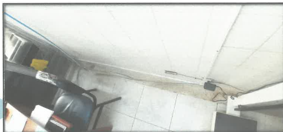
FOTOGRAFIA N°76. Pésimas condiciones del estado actual de los cables de DATA, canaletas deterioradas y cámaras de seguridad mal ubicadas.
