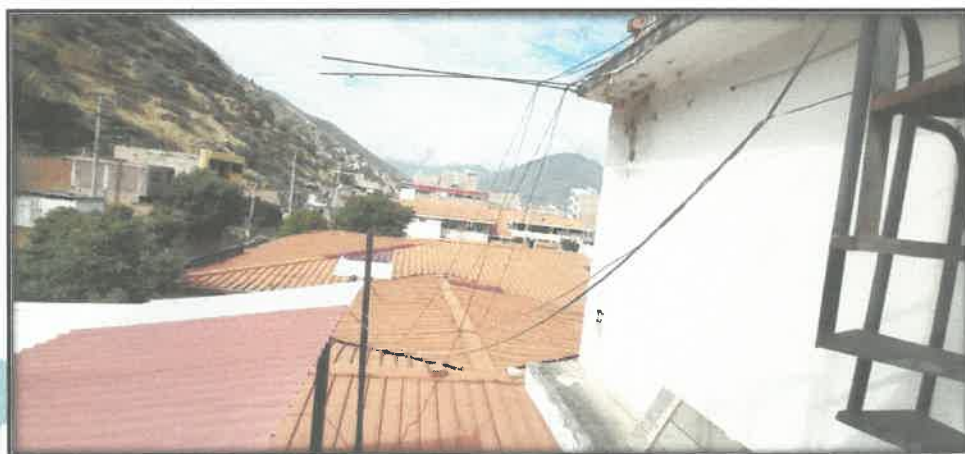
FOTOGRAFIA N°34. Cables de data que están colgados sin un canalizador ni montantes.
