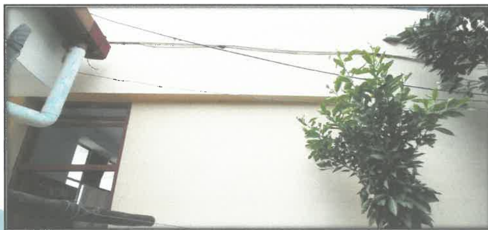
FOTOGRAFIA N°25. Cables tendidos el cual no hubo una conexión técnica para el pase de cables de diferentes módulos.
