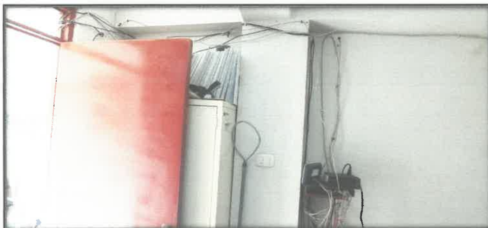
FOTOGRAFIA N°36. Cables de data y comunicaciones enredados el cual no se tiene puertos de salida y de llegada.
