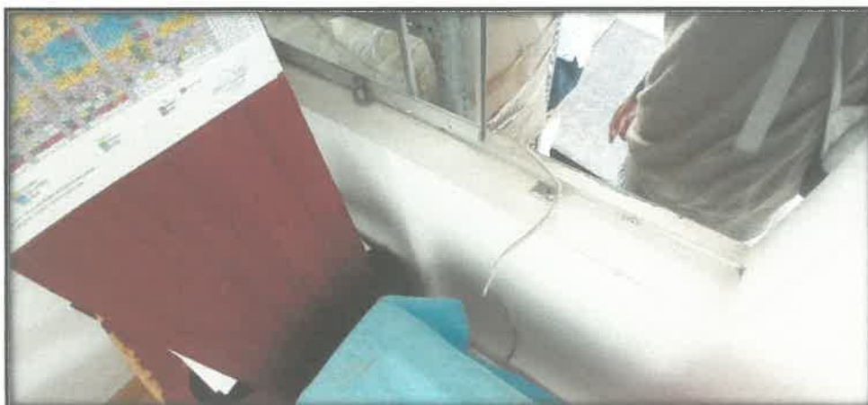
FOTOGRAFIA N°44. Cable de data que pasa por la ventana esto hace que no tenga la función de ventana corridiza.
