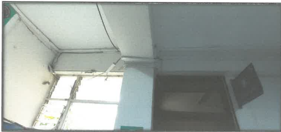
FOTOGRAFIA N°16. Cables de data y comunicaciones suspendido producto a la mala instalación de canaletas, estas se encuentran en total deterioro.
