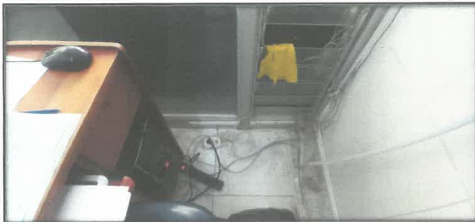
FOTOGRAFIA N°77. Cables sueltos y esto es producto de caídas del personal.
