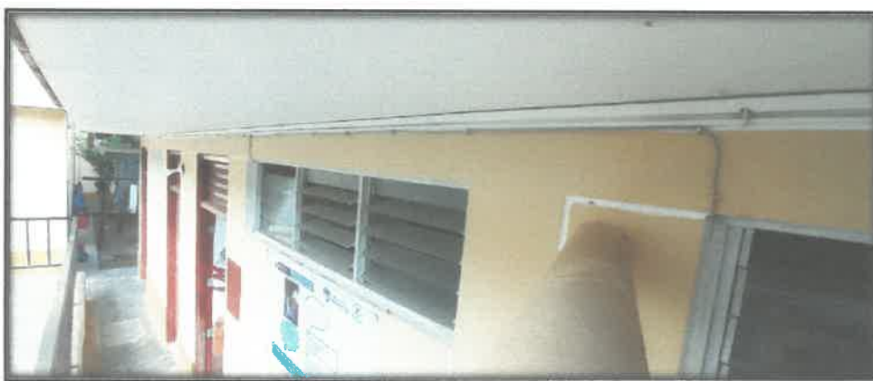
FOTOGRAFIA N°20. Cables de data que están expuestas sin ninguna canaleta de protección.
