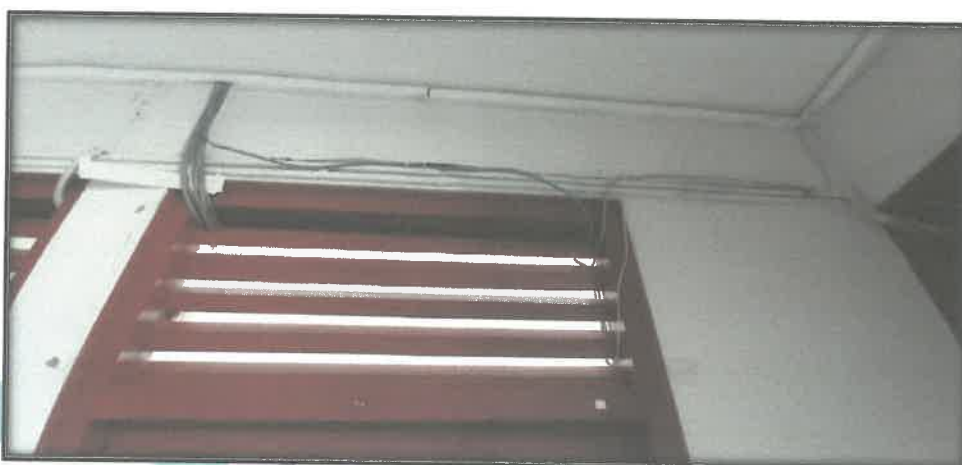
FOTOGRAFIA N°06. No cuenta con ducto para para los cables mediante canaletas.
