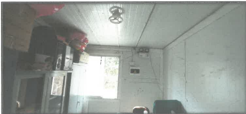
FOTOGRAFIA N°50. Cable de data suspendido en el aire el cual se encuentra expuesto.
