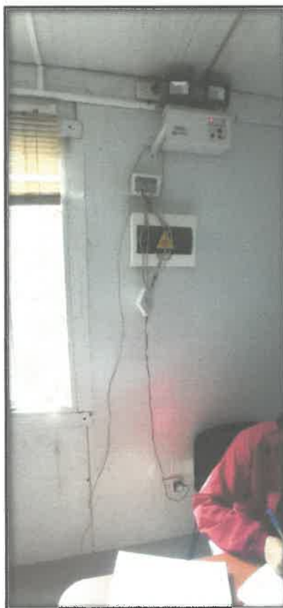
FOTOGRAFIA N°51 y 52. Puntos de salida colgantes, el cual se encuentra a un tablero de distribución siendo un peligro para el personal.
