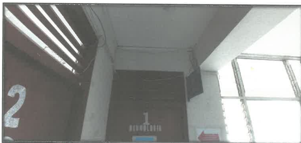
FOTOGRAFIA N°09. Pésimas condiciones del estado actual de los cables de DATA, sin canaletas en el consultorio de neumología.
