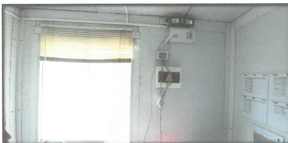
FOTOGRAFIA N°54. Pésimas condiciones de la instalación de DATA Y COMUNICACION.
