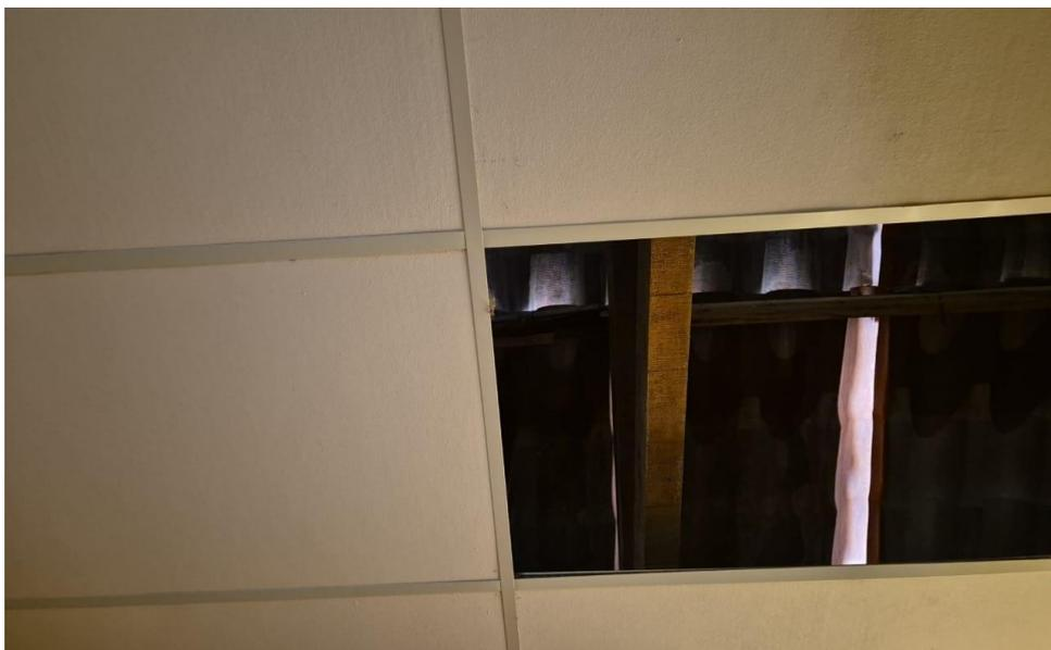
**MAGEN N° 02:** Se muestra la necesidad de reposición del cielo raso. Para su mantenimiento se reemplazarán las baldosas faltantes, se sellará con silicona para su fijación.
