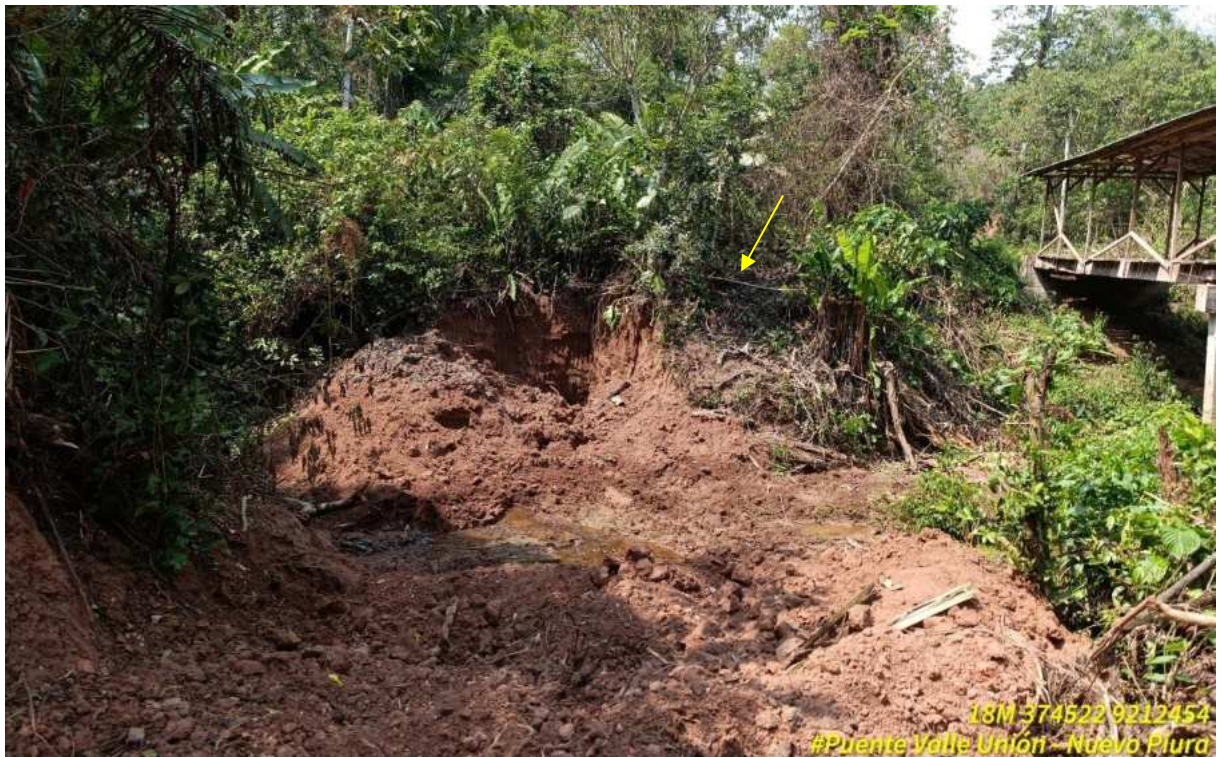
Foto 9: Depósitos aluviales conformados por arcillas y limos con arenas, en estribo derecho de puente Libano.
