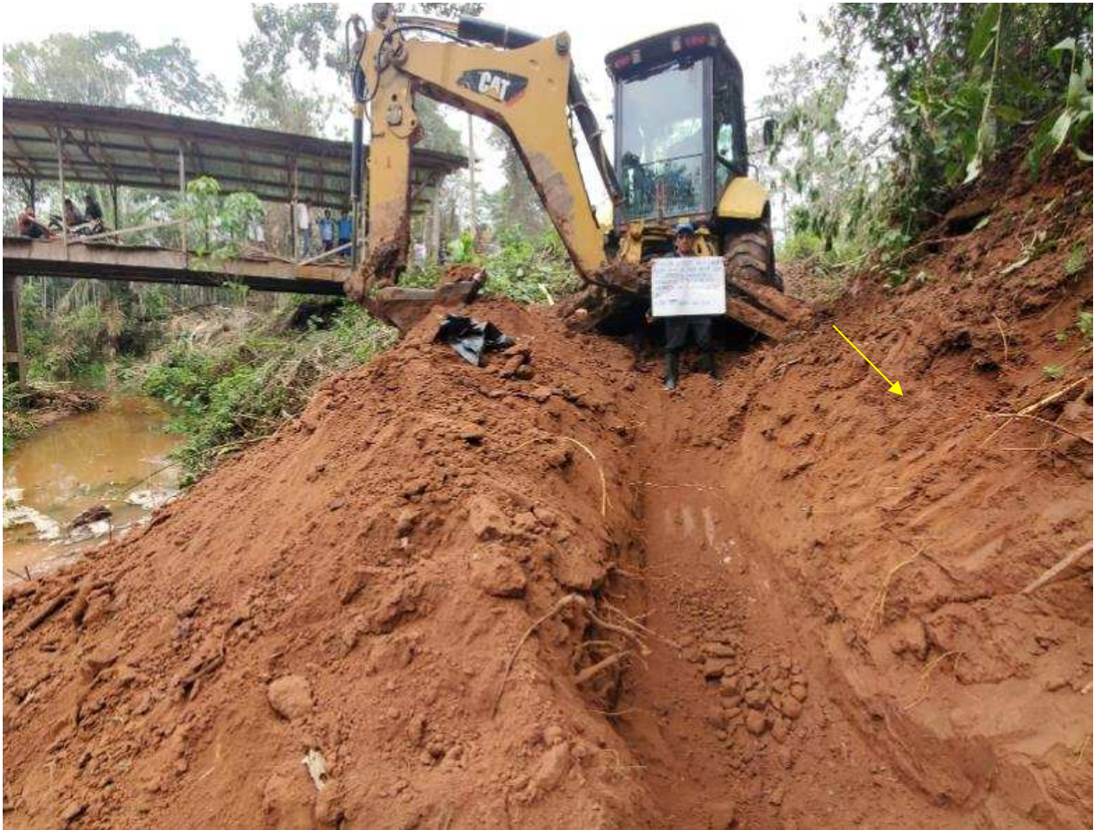
Foto 7: Depósitos deluviales conformados por arcillas con arenas y limos de color rojizo. Ubicados en estribo izquierdo.
