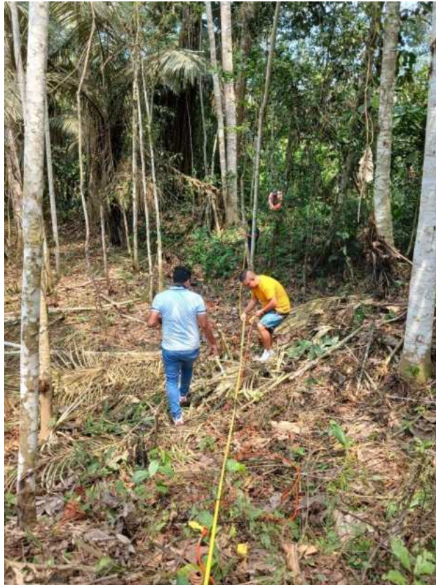
Figura 5. Instalación de cable sísmico.
