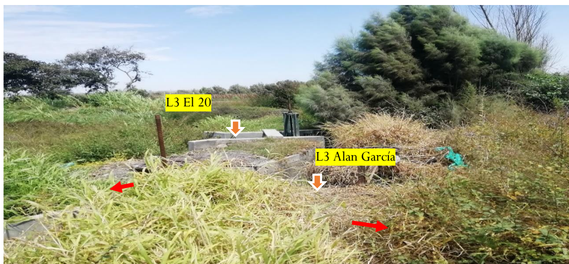
Foto N°24. Vista de la toma lateral del L3 El 20 margen derecha del canal Guayaquil, y toma lateral del L3 Alan García en la margen izquierda del canal. se aprecia en regular estado de conservación.
