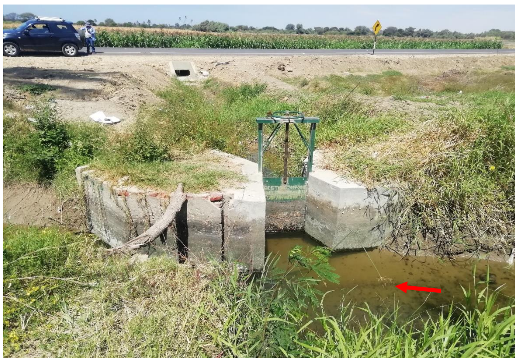
Foto N°18. Vista de la toma lateral L3 Imán (TL N° 01), margen derecha del canal Guayaquil, se puede observar que se encuentra en regular estado de conservación.
