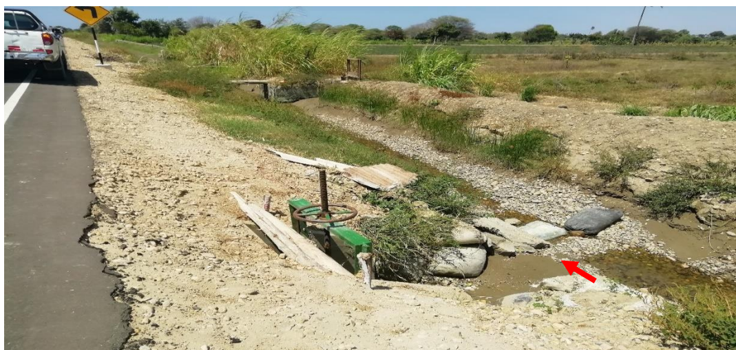
Foto N°18. Vista de la toma lateral L3 Imán (TL N° 01), margen derecha del canal Guayaquil, se puede observar que se encuentra en regular estado de conservación.
