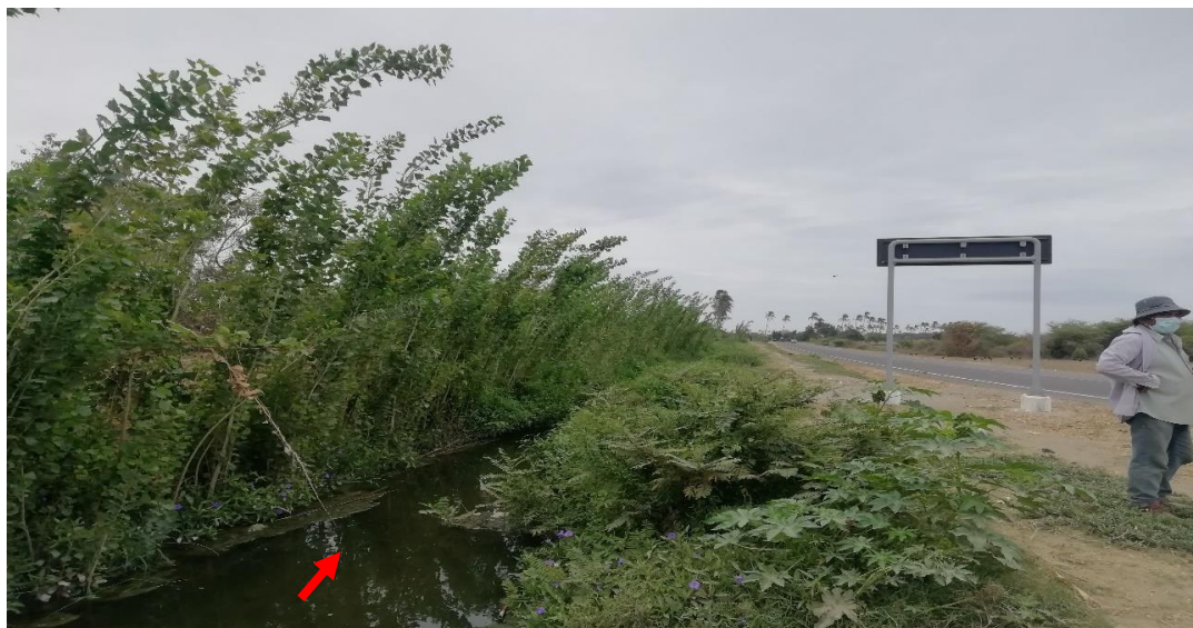
Foto N° 07. Vista del canal Guayaquil en la progresiva km 0+100, se puede apreciar vegetación en los taludes, así mismo se observa el flujo lento del agua por la pendiente suave que tiene el canal.
