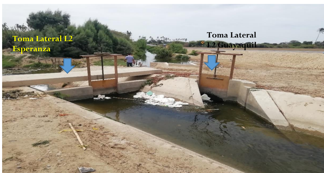
Foto N° 01. Vista de la toma lateral del canal Guayaquil, se aprecia la compuerta metálica de izaje, así mismo se aprecia el buen estado de la estructura.
