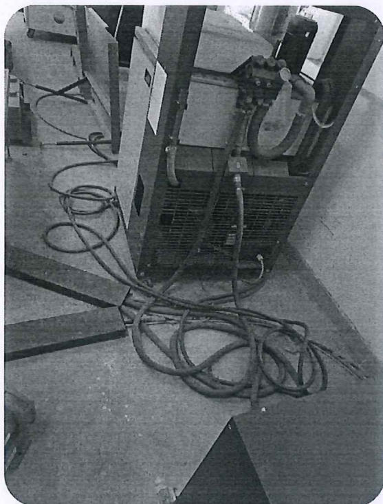
CABLES EXPUESTOS EN IMPRENTA
