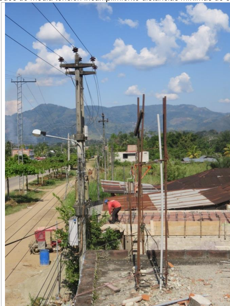
Fig. 4. Redes de media tensión incumplimiento distancias mínimas de seguridad
