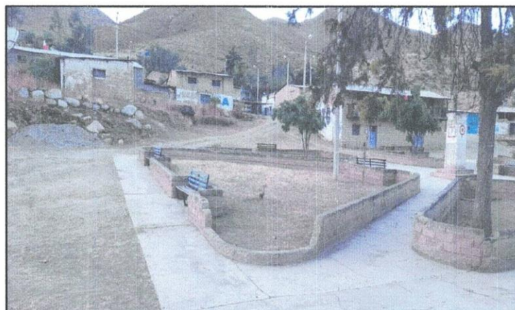
Imagen N° 8. Sardineles de albañilería en estado decadente. Inexistencia de áreas verdes.
