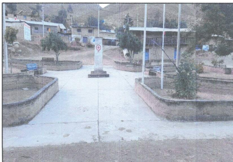
Imagen N° 6. Plazuela con pisos agrietados e inexistencia de Zona Cívica.
