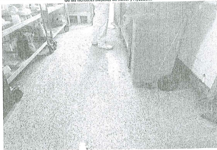
IMAGEN 05: Se muestra el piso de terrazo presenta deterioro, agujeros, terrazo desprendido.
