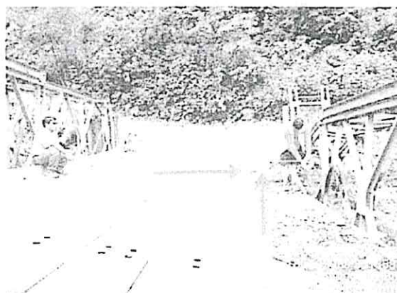
Desnivel en la superficie de rodadura del puente
