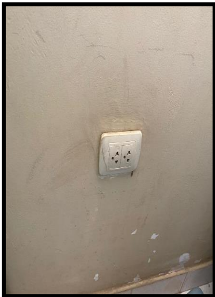
IMAGEN 09 - 10: En las fotos se muestran los tomacorrientes que requieren cambio.
