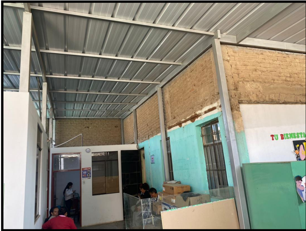
IMAGEN 25: En la imagen se evidencia la ausencia de tarrajeo en la parte superior de la pared, lo que expone la superficie a deterioro y requiere su ejecución para garantizar protección.
