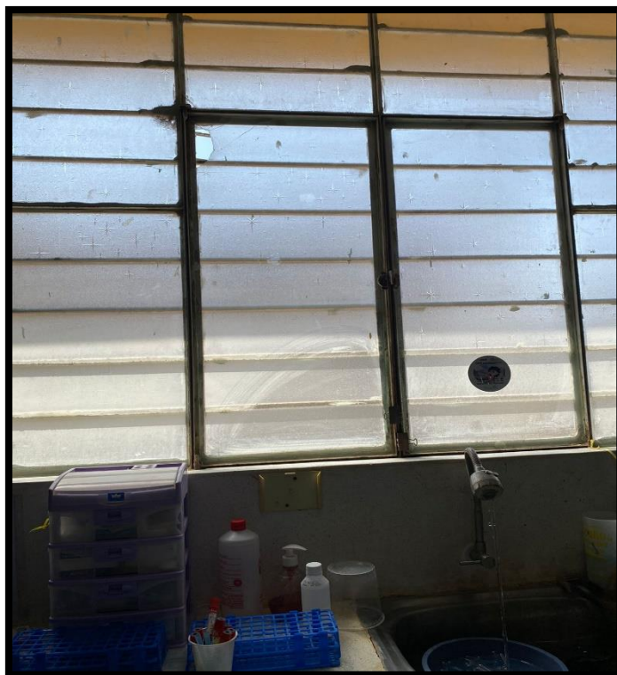
IMAGEN 20: Se evidencia la rotura del vidrio de la luna, por lo que se requiere su reemplazo para prevenir riesgos de accidentes y garantizar la seguridad del ambiente.
