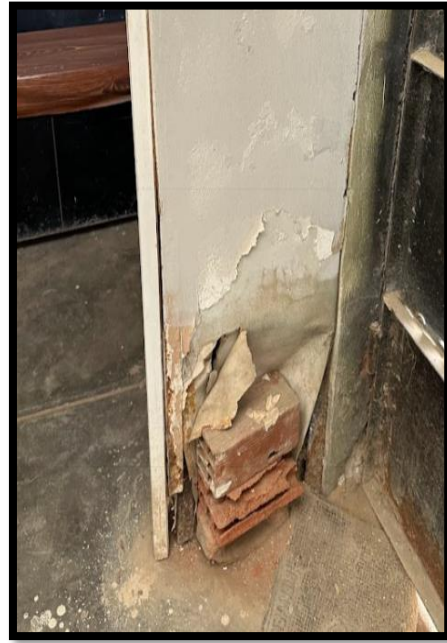
IMAGEN 03- 04: En las imágenes se muestra el muro prefabricado con deficiencias, donde requiere cambio urgente y está ubicado en el área de TBC.
