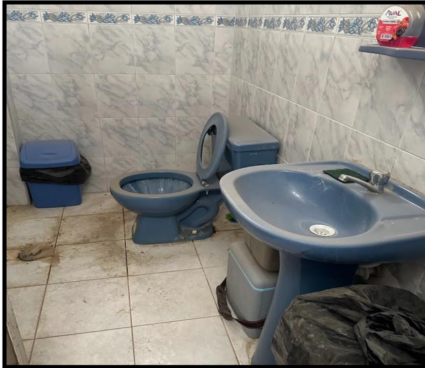
IMAGEN 27: Se observan los baños del segundo nivel, los cuales se encuentran fuera de uso debido al mal funcionamiento de la red de desagüe, requiriendo una intervención para su rehabilitación y correcto funcionamiento.
