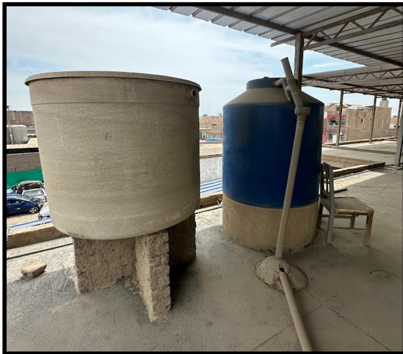
IMAGEN 15: En la imagen se observan dos tanques de almacenamiento de agua, de los cuales uno se encuentra fuera de servicio. Por ello, se recomienda su desmontaje y retiro.
