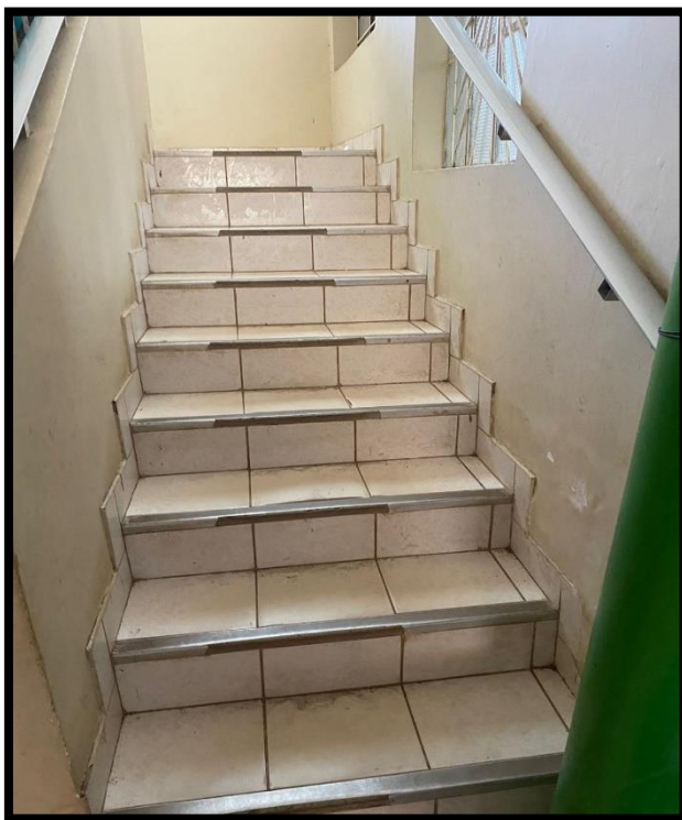
IMAGEN 19: Se observa la condición actual de la escalera en el primer nivel, evidenciando el desgaste de las cantoneras, por lo que se recomienda su reemplazo para garantizar la seguridad y durabilidad de la estructura.
