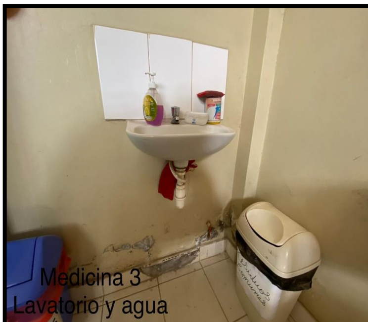
IMAGEN 12- 13: En la imagen se evidencia el deterioro de las instalaciones de desagüe, lo que provoca filtraciones y escurrimientos de agua, afectando el correcto funcionamiento.
