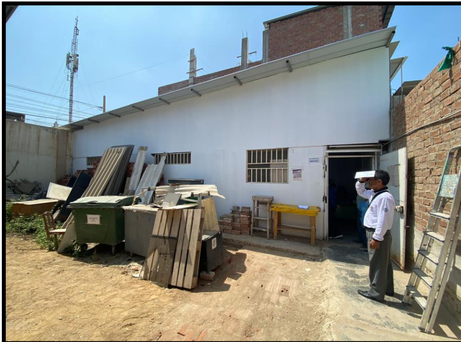
IMAGEN 22: Se observa el área de archivo, la cual no cuenta con columnas ni una estructura adecuada para garantizar su estabilidad. Por lo tanto, se recomienda su demolición para evitar riesgos estructurales.
