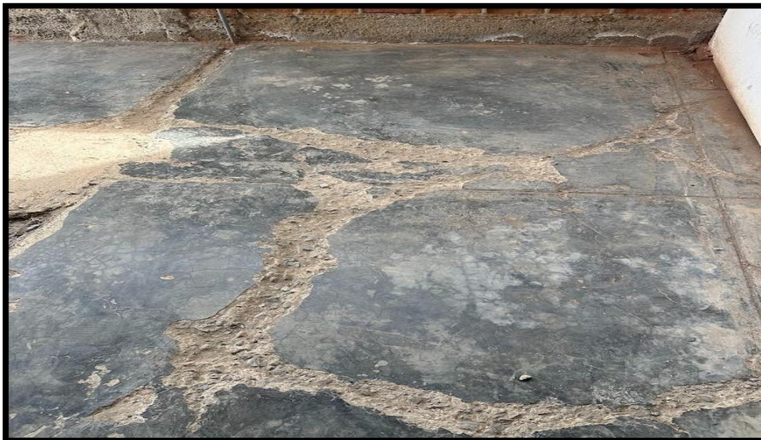
IMAGEN 24: Se observa la zona de vereda en mal estado, presentando deterioro que afecta su funcionalidad y seguridad. Por ello, se recomienda su demolición y posterior rehabilitación.
