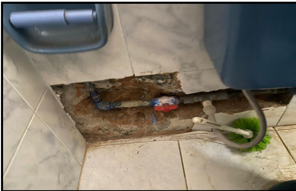
IMAGEN 23: En la figura se evidencia el deterioro de la caja de válvulas.
