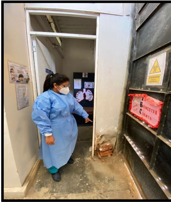
IMAGEN 03- 04: En las imágenes se muestra el muro prefabricado con deficiencias, donde requiere cambio urgente y está ubicado en el área de TBC.
