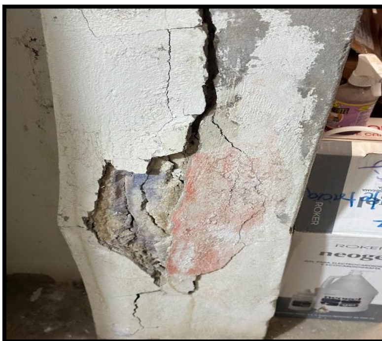
IMAGEN 30: Se observa una falsa columna en el área de farmacia, la cual presenta un daño estructural significativo.
