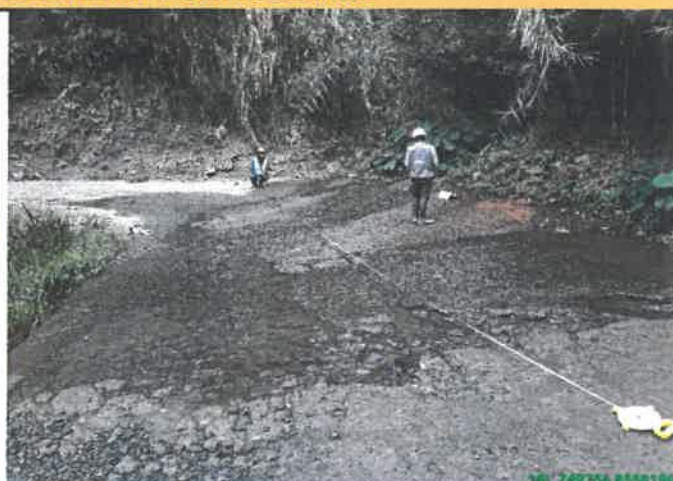
Foto N° 314 PROGRESIVA 0+880 DESCRIPCION malo BADEN Existente
