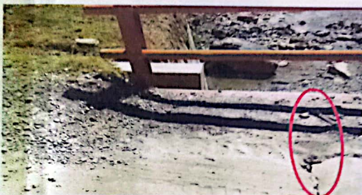
Foto 01. Se puede observar la fisura de la plataforma del puente Bramadero.
