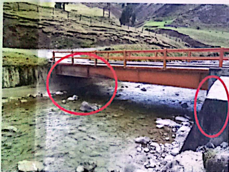
Foto 04. Se puede observar que el tablero de rodadura es de tabores de madera, se soporta en Troncos y la altura es inadecuada.
