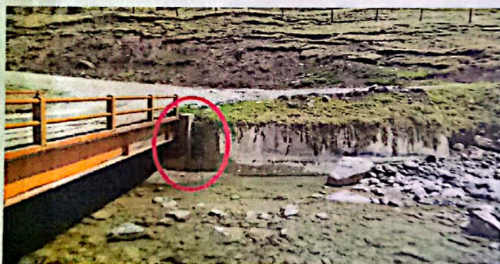
Foto 02. Se puede observar que deterioro por fisura de los estribos.
