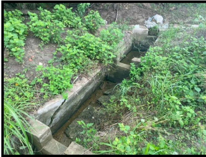
Imagen N°3: Canal para alimentación de reservorio de riego en mal estado - Anexo Hualtaco
