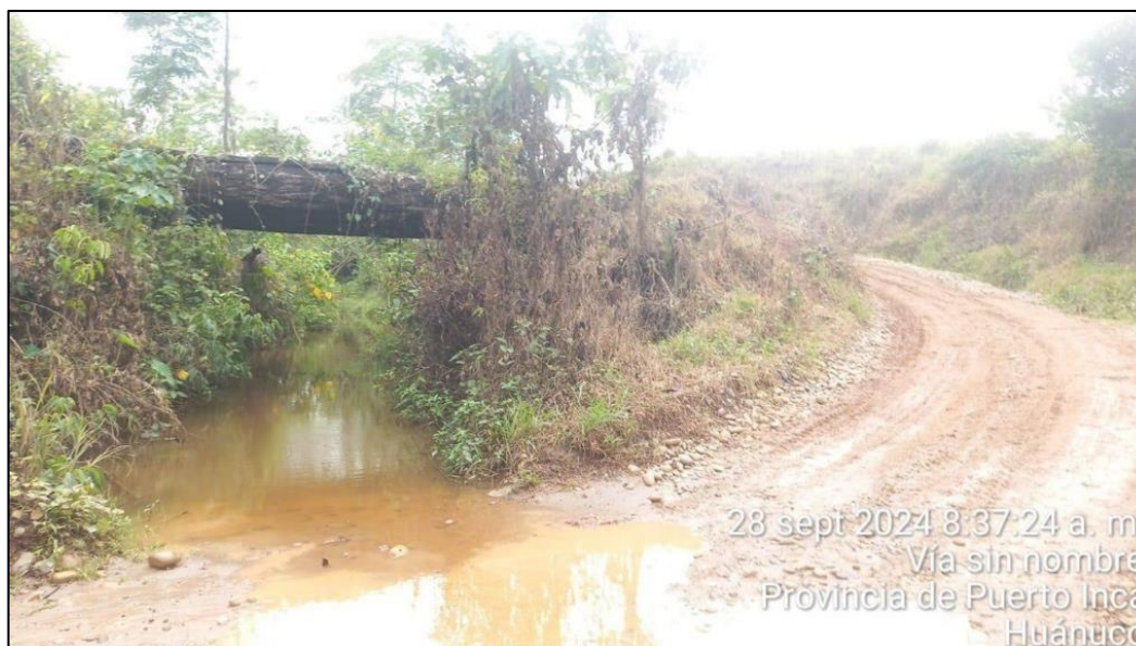
Figura N°8. Vista de cauce y fondo de viga de puente de madera en malas condiciones
