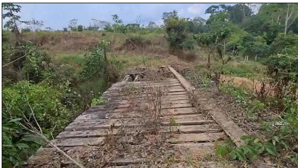
Figura N°7. Puente 28 de Julio existente de estructura de madera en malas condiciones
