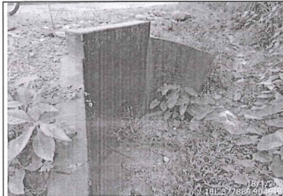
Foto 114: Alcantarilla TMC en buen estado y funcionamiento, Ubicado en la progresiva 16+161.
