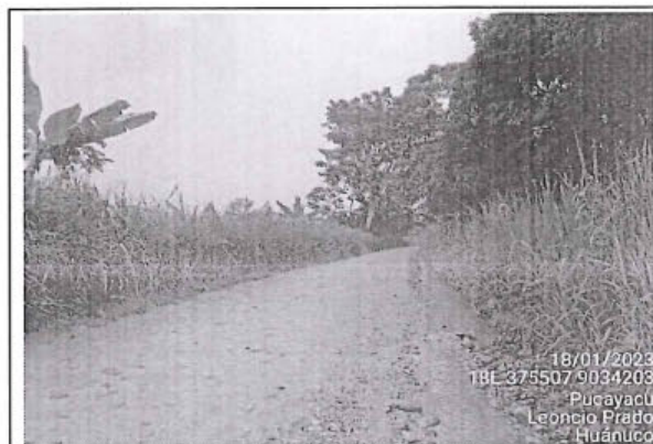
Foto 11: Se observa el camino vecinal en buen estado ubicado en la progresiva del km 1+080 al km 1+500, con superficie de rodadura con afirmado y estado de transitabilidad bueno.
