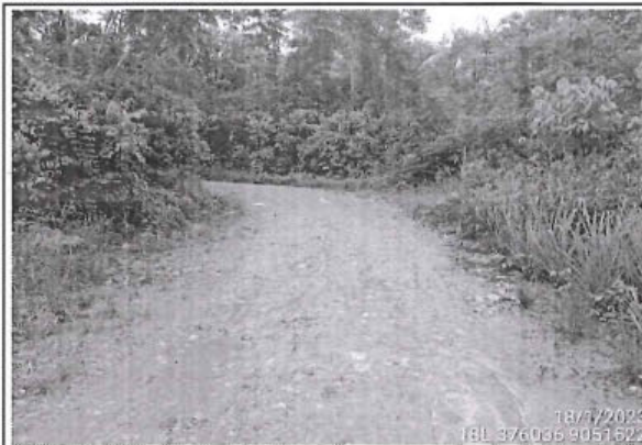
Foto 170: Vista de camino vecinal con superficie de rodadura con afirmado y estado de transitabilidad regular entre las progresivas 22+112 al 22+500.
