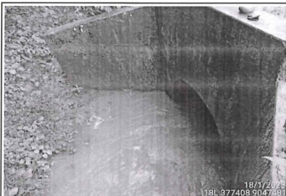
Foto 127: Alcantarilla TMC, en buen estado y buen funcionamiento ubicado en la progresiva 17+800.
