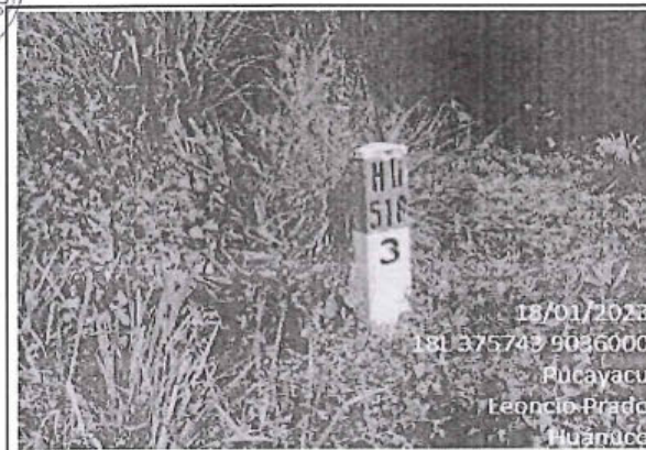
Foto 17: Hito Kilometrico 3, en buen estado con superficie de rodadura con afirmado y estado de transitabilidad bueno ubicado en la progresiva 3+000.
