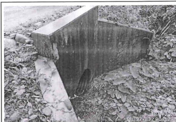
Foto 115: Alcantarilla TMC en buen estado y funcionamiento, Ubicado en la progresiva 16+345.
