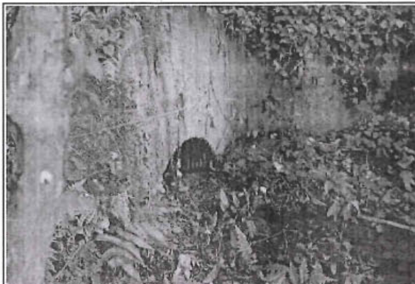
Foto 248: Alcantarilla TMC en buen estado y funcionamiento, ubicado en la progresiva 2+868
