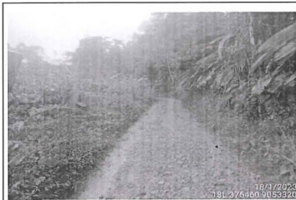
Foto 205: Camino vecinal con superficie de rodadura con afirmado y estado de transitabilidad bueno entre las progresivas 25+770 al 06+000.
