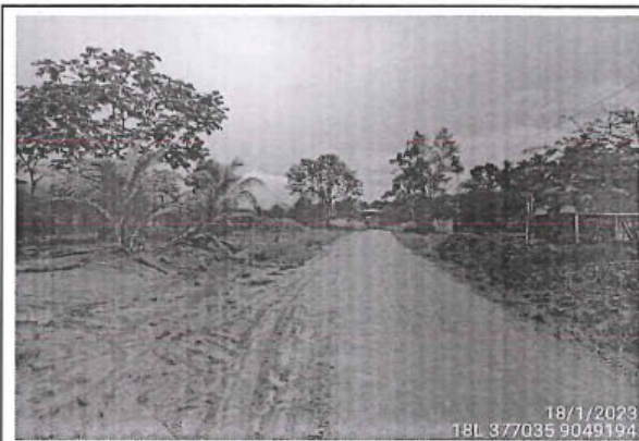
Foto 148: Vista del camino vecinal con superficie de rodadura con afirmado y estado de transitabilidad regular entre las progresivas 19+970 al 20+000.
