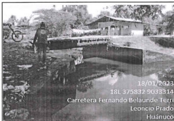
Foto 07: Ponton de madera ubicado en la progresiva km 0+120 de la carretera vecinal con superficie de rodadura con de madera y estado de transitabilidad bueno, en la foto se muestra la evaluacion del personal tecnico.
