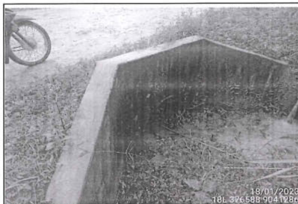
Foto 61: Alcantarilla TMC en buen estado en funcionamiento regular debido a falta de limpieza, ubicado en la progresiva 9+594.
