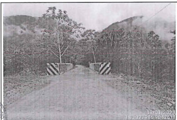
Foto 81: Ponton de fierro galvanizado en estado bueno ubicado en la progresiva 12+015, la foto muestra entrada al ponton.
