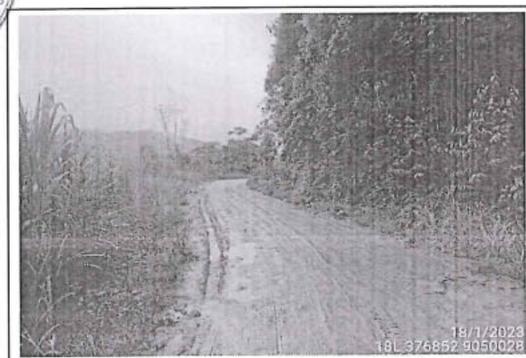
Foto 161: Se observa camino vecinal con superficie de rodadura con afirmado y estado de transitabilidad regular, entre las progresivas 21+287 al 21+500.
