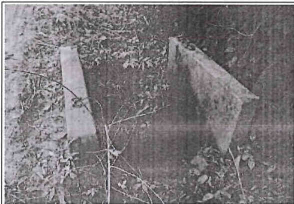
Foto 180: Alcantarilla TMC en estado bueno y funcionamiento, ubicado en la progresiva 23+237.
