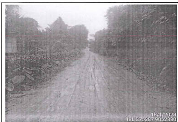
Foto 201: Vista del camino vecinal con superficie de rodadura con afirmado y estado de transitabilidad bueno entre las progresivas 25+390 al 25+500.
