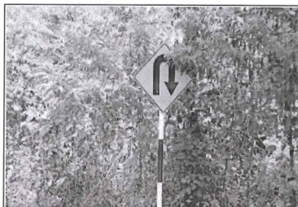
Foto 134: Señal preventiva en buen estado con superficie de rodadura con afirmado y estado de transitabilidad regular, ubicado en la progresiva 18+536.
