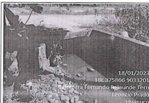
Foto 04: Alcantarilla ubicada en la progresiva del Km 0+006 del camino vecinal con superficie de rodadura de concreto armado y estado de transitabilidad regular.
