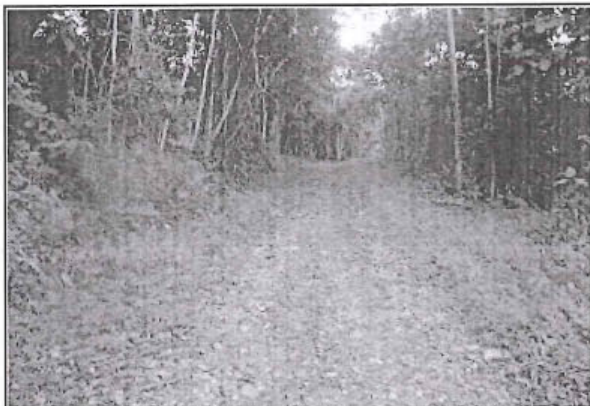
Foto 251: Se observa el camino vecinal con superficie de rodadura con afirmado y estado de transitabilidad regular ubicado en la progresiva del 2+955 al 3+000.
