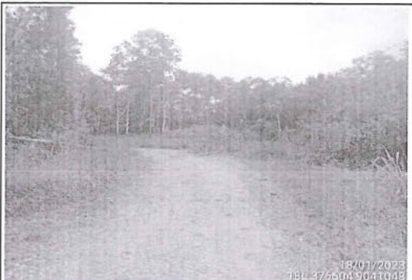
Foto 60: se observa camino vecinal en buen estado con superficie de roadadura con afirmado y estado de transitabilidad bueno entre las progresivas 9+291 al 9+500.
