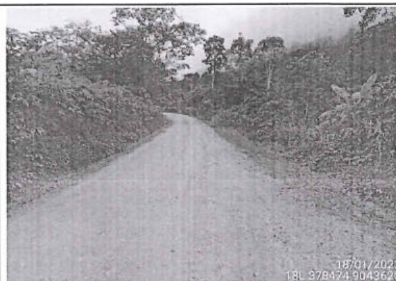
Foto 96: Se observa el camino vecinal con superficie de rodadura con afirmado y estado de transitabilidad bueno ubicado en la progresiva 13+500 al 14+000.
