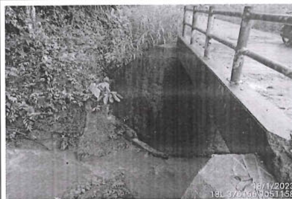
Foto 164: ponton de concreto en buen estado y buen funcionamiento, ubicado en la progresiva 21+814, foto muestra aguas abajo del ponton.
