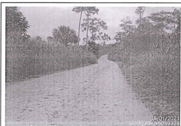
Foto 45: Se observa el camino vecinal en buen estado ubicado con superficie de rodadura con afirmado y estado de transitabilidad bueno entre las progresivas 7+360 al 7+500.
