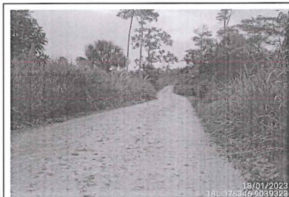
Foto 45: Se observa el camino vecinal en buen estado ubicado con superficie de rodadura con afirmado y estado de transitabilidad bueno entre las progresivas 7+360 al 7+500.
