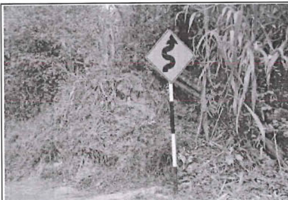
Foto 166: Señal preventiva en buen estado con superficie de rodadura con afirmado y estado de transitabilidad bueno, ubicado en la progresiva 21+982.
