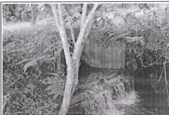
Foto 247: Alcantarilla de concreto en buen estado y funcionamiento ubicado en la progresiva 6+626
