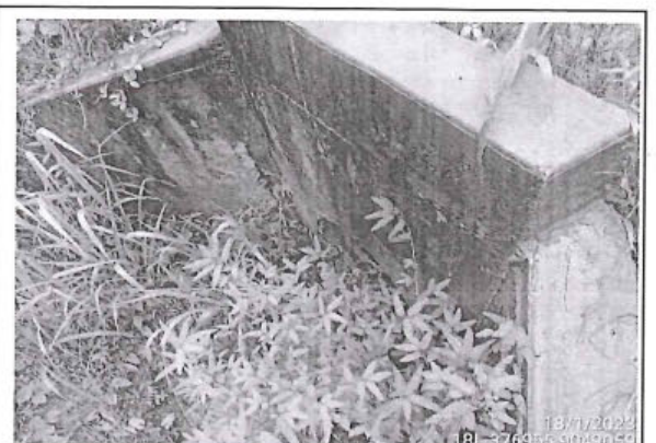
Foto 150: Alcantarilla TMC en buen estado y funcionamiento regular debido a falta de limpieza, se encuentra ubicada en la progresiva 20+230.
