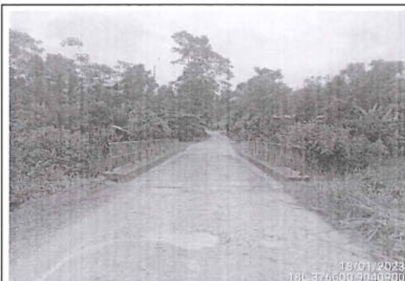
Foto 54: Ponton de concreto en buen estado y buen funcionamiento, ubicado en la progresiva 9+160, la foto muestra la entrada al ponton.
