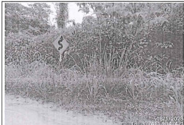
Foto 126: Señal preventiva en buen estado con superficie de rodadura con afirmado y estado de transitabilidad regular, ubicado en la progresiva 17+790.
