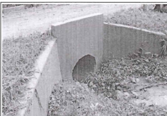
Foto 174: Alcantarilla TMC en buen estado y buen funcionamiento, ubicado en la progresiva 22+683.
