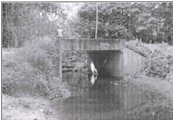
Foto 211: Ponton de concreto en condiciones buenas y funcionamiento, ubicado en la progresivas 0+165, la foto muestra aguas abajo del ponton.
