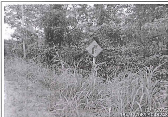
Foto 139: Señal preventiva en buen estado con superficie de rodadura con afirmado y estado de transitabilidad regular, ubicado en la progresiva 19+080.
