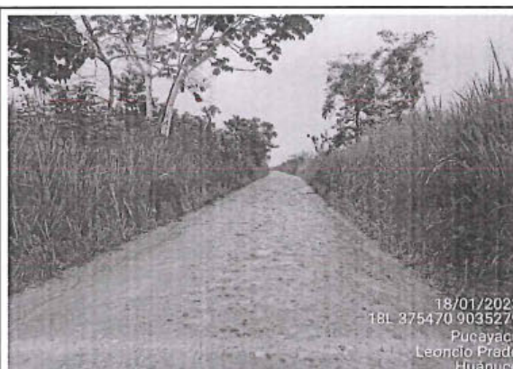
Foto 16: Se observa camino vecinal con superficie de rodadura con afirmado y estado de transitabilidad bueno entre las progresivas 2+000 al 2+500.
