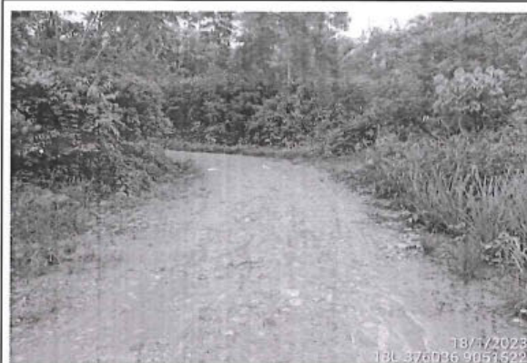
Foto 182: Se observa el camino vecinal con superficie de rodadura con afirmado y estado de transitabilidad bueno ubicado en la progresiva del 23+315 al 23+500.
