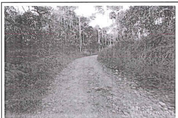
Foto 219: Se observa el camino vecinal con superficie de rodadura con afirmado y estado de transitabilidad bueno ubicado en la progresiva del 1+969 al 2+000.
