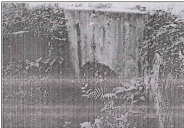
Foto 222: Alcantarilla TMC en buen estado y funcionamiento ubicado en la progresiva 2+507.
