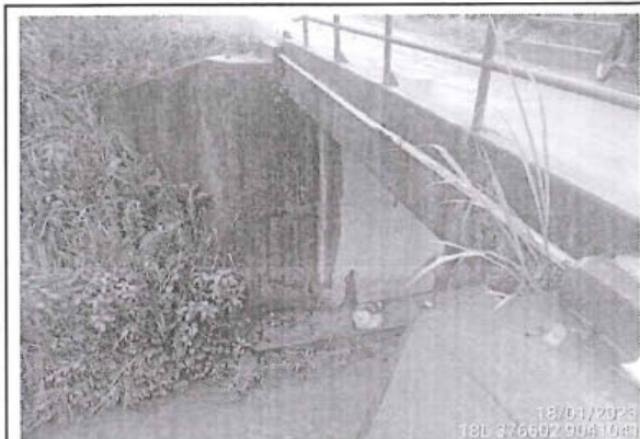
Foto 59: ponton de concreto en buen estado y buen funcionamiento, ubicado en la progresiva 9+291, la foto muestra la aguas abajo del ponton.
