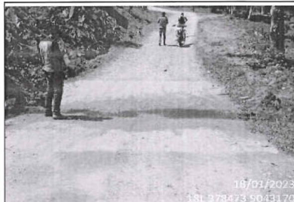
Foto 86: Baden en buen estado y buen funcionamiento ubicado en la progresiva 12+410.
