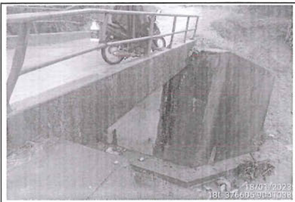
Foto 58: ponton de concreto en buen estado y buen funcionamiento, ubicado en la progresiva 9+291, la foto muestra la entrada al ponton.
