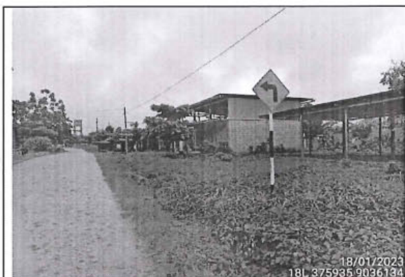
Foto 19: Señal preventiva en buen estado con superficie de rodadura con afirmado y estado de transitabilidad bueno, ubicado en la progresiva 3+340
