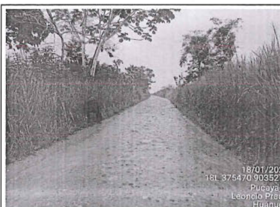
Foto 16: Se observa camino vecinal con superficie de rodadura con afirmado y estado de transitabilidad bueno entre las progresivas 2+000 al 2+500.
