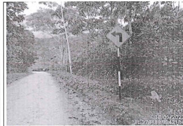
Foto 90: Señal preventiva en buen estado con superficie de rodadura con afirmado y estado de transitabilidad bueno, ubicado en la progresiva 12+883.
