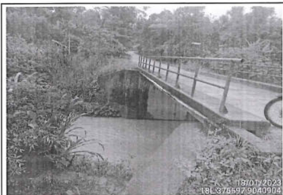
Foto 55: ponton de concreto en buen estado y buen funcionamiento, ubicado en la progresiva 9+160, la foto muestra la aguas abajo del ponton.
