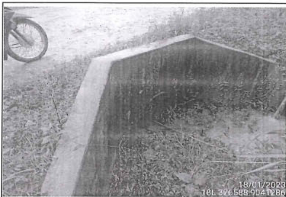
Foto 61: Alcantarilla TMC en buen estado en funcionamiento regular debido a falta de limpieza, ubicado en la progresiva 9+594.
