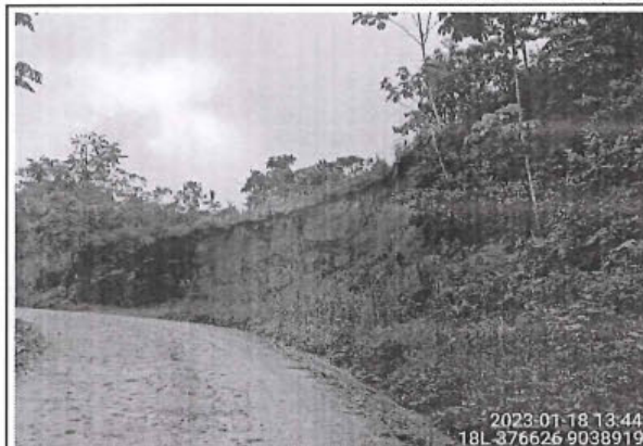
Foto 37: vista del camino vecinal con superficie de rodadura con afirmado y estado de transitabilidad bueno entre las progresivas 6+358 al 6+500
