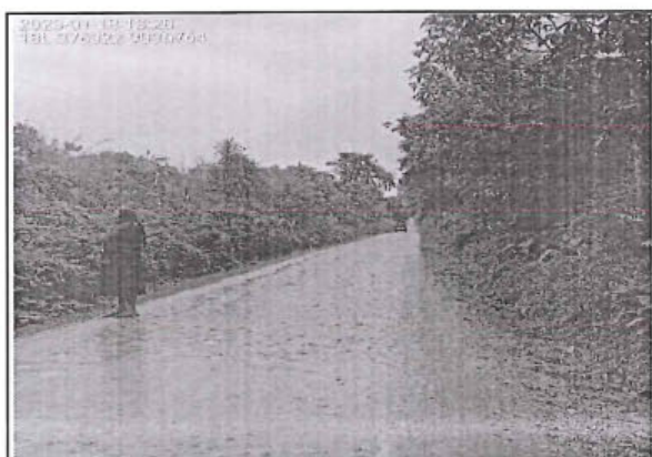
Foto 27: Vista del camino vecinal con superficie de rodadura con afirmado y estado de transitabilidad regular entre las progresivas 4+420 al 4+500.
