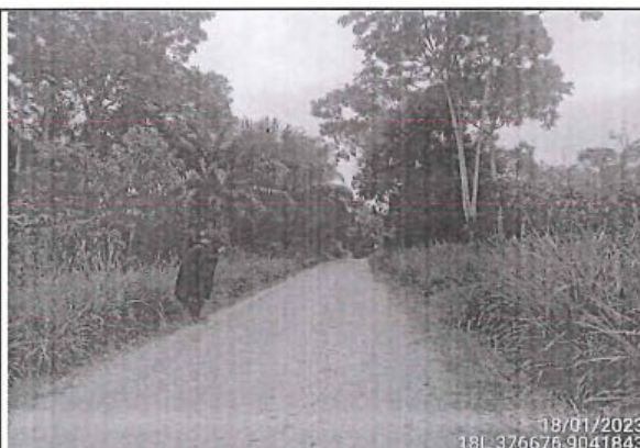
Foto 70: Se observa camino vecinal con superficie de rodadura con afirmado y estado de transitabilidad bueno entre las progresivas 10+390 al 10+500.
