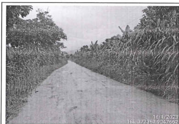
Foto 133: Vista de camino vecinal con superficie de afirmado y estado de transitabilidad regular entre las progresivas 18+450 al 18+500.
