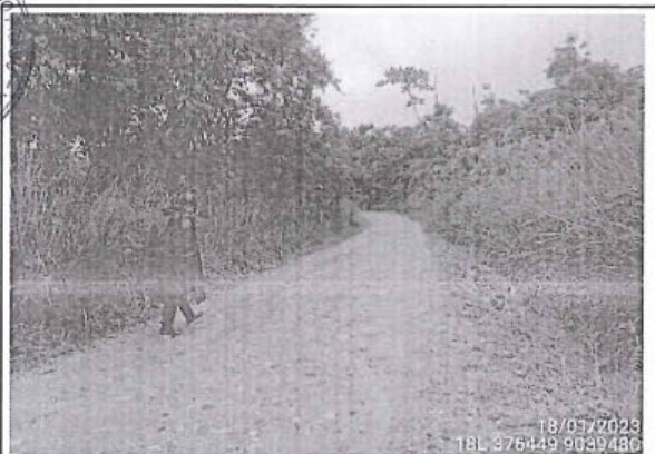
Foto 47: Se observa el camino vecinal con superficie de rodadura con afirmado y estado de transitabilidad bueno entre las progresivas 7+623 al 8+000.
