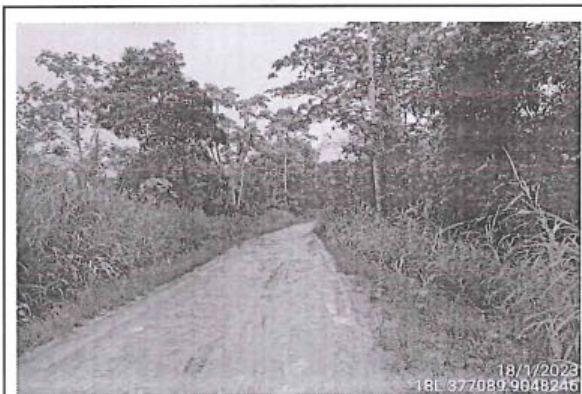
Foto 141: Se observa el camino vecinal con superficie de rodadura con afirmado y estado de transitabilidad regular ubicado en la progresiva del 19+460 al 19+500.
