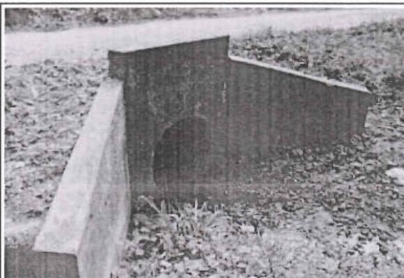
Foto 162: Alcantarilla TMC en buen estado y buen funcionamiento, ubicado en la progresiva 21+630.
