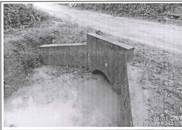
Foto 98: Alcantarilla TMC en buen estado y funcionamiento malo debido a falta de limpieza (obstruido) ubicado en la progresiva 14+228.
