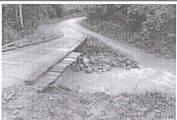
Foto 131: Ponton de madera en condiciones regulares ya que el tablero de rodadura se esta deteriorando a causa del intemperismo, esta ubicado en la progresiva 18+450, la foto muestra aguas abajo del ponton.
