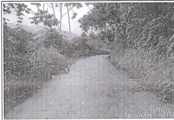
Foto 168: Vista del camino vecinal con superficie de rodadura con afirmado y estado de transitabilidad bueno entre las progresivas 21+990 al 22+000.
