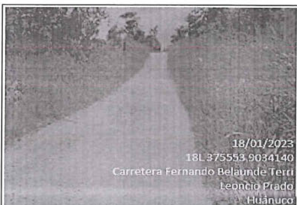
Foto 09: Se observa el camino vecinal con superficie de rodadura con afirmado y estado de transitabilidad regular, ubicado entre las progresiva del km 0+500 al km 1+000.
