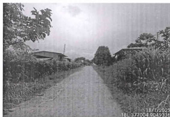
Foto 152: Camino vecinal con superficie de rodadura con afirmado y estado de transitabilidad regular , entre las progresivas 20+252 al 20+500.
