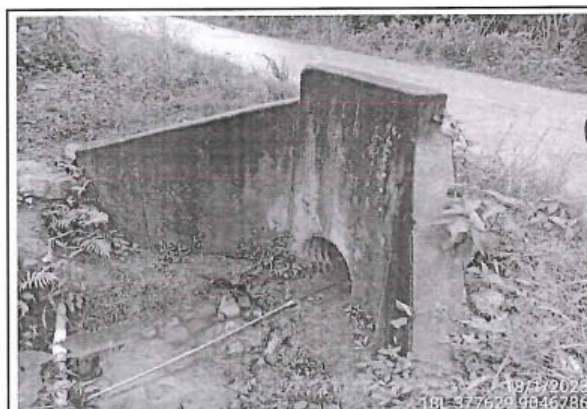
Foto 135: Alcantarilla TMC en buen estado y buen funcionamiento, ubicado en la progresiva 18+940.
