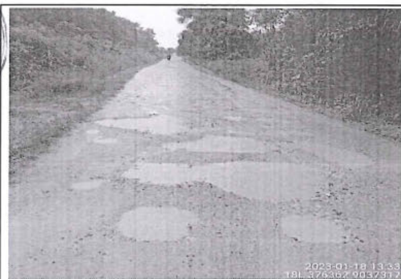
Foto 29: vista del camino vecinal con superficie de rodadura con afirmado y estado de transitabilidad regular entre las progresivas 4+994 al 5+000.
