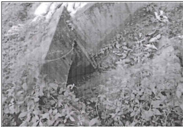
Foto 236: Alcantarilla de concreto en buen estado y funcionamiento, ubicado en la progresiva 1+481.
