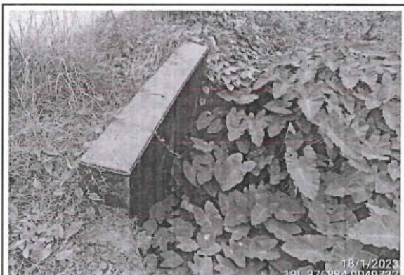
Foto 154: Alcantarilla TMC en buen estado y con falta de limpieza ubicado en la progresiva 20+669.
