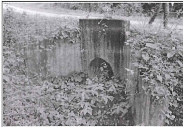
Foto 230: Alcantarilla TMC en buen estado y funcionamiento, ubicado en la progresiva 0+370.
