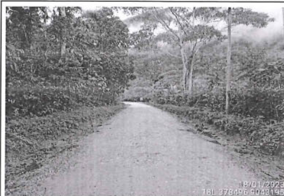
Foto 91: Se observa camino vecinal con superficie de rodadura con afirmado y estado de transitabilidad bueno entre las progresivas 12+883 al 13+000..
