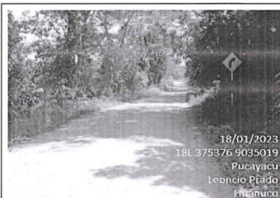
Foto 14: Señal preventiva en buen estado ubicada en la progresiva 1+951 . de la carretera vecinal, con superficie de rodadura con afirmado y estado de transitabilidad bueno.
