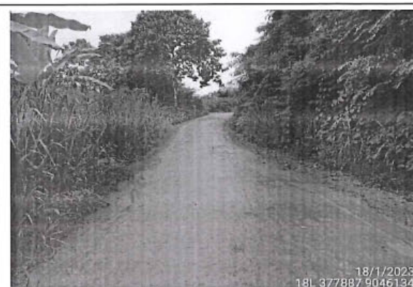
Foto 116: Se observa el camino vecinal con superficie de rodadura con afirmado y estado de transitabilidad regular ubicado en la progresiva 16+345 al 16+500.
