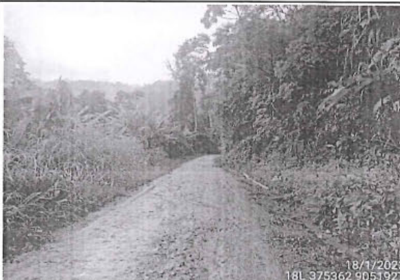
Foto 186: Se observa el camino vecinal con superficie de rodadura con afirmado y estado de transitabilidad bueno ubicado en la progresiva del 23+990 al 24+000.
