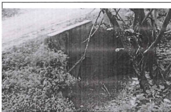
Foto 200: Alcantarilla TMC en buen estado u buen funcionamiento, ubicado en la progresiva 25+390.
