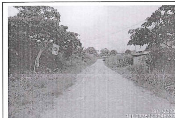
Foto 125: Camino vecinal entre las progresivas 17+241 al 17+500, con superficie de rodadura con afirmado y estado de transitabilidad bueno.
