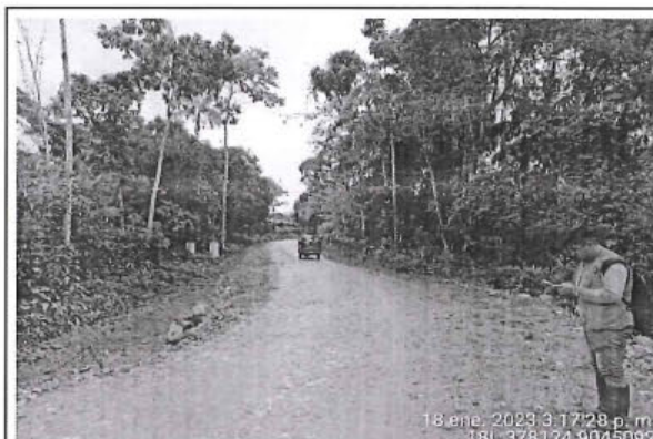
Foto 104: Vista del camino vecinal con superficie de rodadura con afirmado y estado de transitabilidad regular entre las progresivas 14+997 al 15+000.
