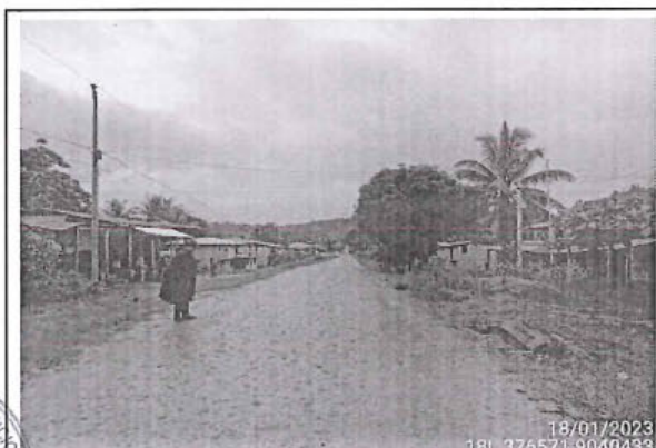
Foto 51: Se observa el C. P. Maronilla con buen estado con superficie de rodadura con afirmado y estado de transitabilidad bueno en la progresiva 8+674.
