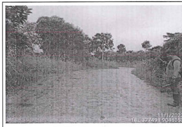
Foto 136: Se observa camino vecinal con superficie de rodadura con afirmado y estado de transitabilidad regular entre las progresivas 18+940 al 19+000..
