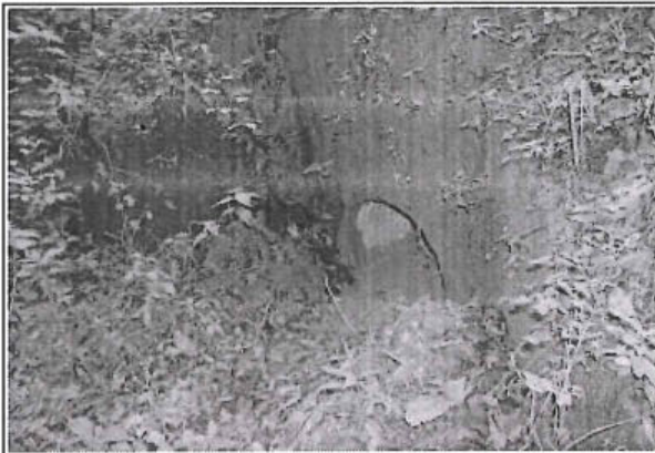
Foto 235: Alcantarilla TMC en buen estado y regular funcionamiento, ubicado en la progresiva 1+409.
