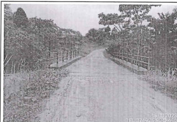
Foto 143: Ponton de concreto en buen estado y buen funcionamiento, ubicado en la progresiva 19+520, la foto muestra la entrada al ponton.
