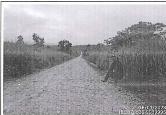
Foto 49: Se observa el camino vecinal en buen estado ubicado con superficie de rodadura con afirmado y estado de transitabilidad regular entre las progresivas 8+028 al 8+500.
