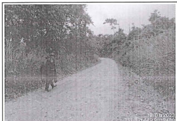
Foto 47: Se observa el camino vecinal con superficie de rodadura con afirmado y estado de transitabilidad bueno entre las progresivas 7+623 al 8+000.
