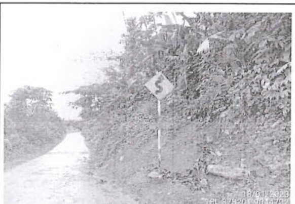
Foto 101: Señal preventiva en buen estado con superficie de rodadura con afirmado y estado de transitabilidad regular, ubicado en la progresiva 14+612.
