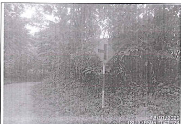
Foto 64: Señal preventiva en buen estado con superficie de rodadura con afirmado y estado de transitabilidad bueno, ubicado en la progresiva 9+834.
