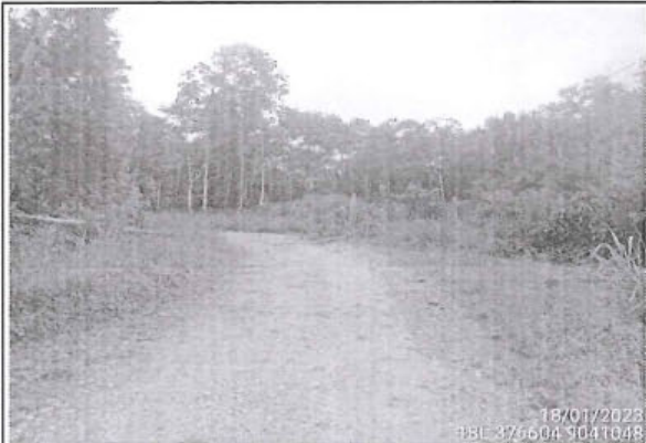
Foto 60: se observa camino vecinal en buen estado con superficie de rodadura con afirmado y estado de transitabilidad bueno entre las progresivas 9+291 al 9+500.
