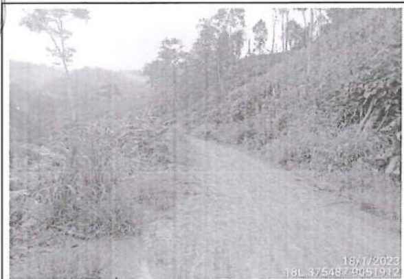
Foto 179: Vista de camino vecinal con superficie de rodadura con afirmado y estado de transitabilidad bueno, entre las progresivas 22+984 al 23+000.
