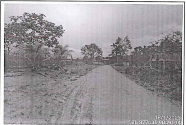
Foto 148: Vista del camino vecinal con superficie de rodadura con afirmado y estado de transitabilidad regular entre las progresivas 19+970 al 20+000.
