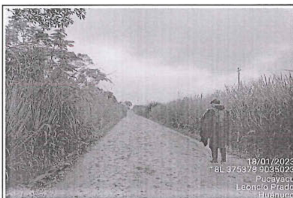
Foto 15: Se observa el camino vecinal con superficie de rodadura con afirmado y estado de transitabilidad bueno ubicado en la progresiva del km 1+951 al km 2+000.
