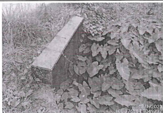
Foto 154: Alcantarilla TMC en buen estado y con falta de limpieza ubicada en la progresiva 20+669.
