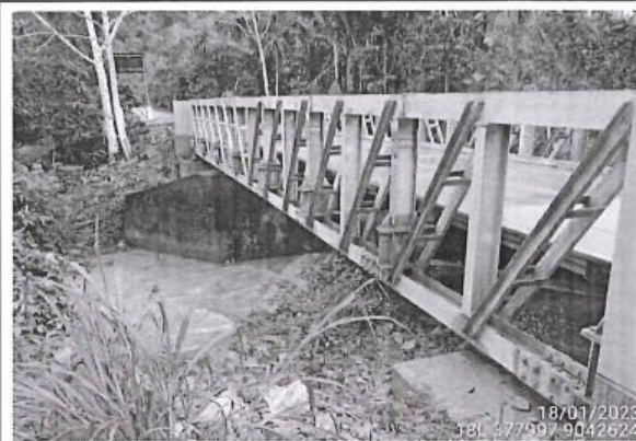
Foto 80: Ponton de fierro galvanizado estado bueno ubicado en la progresiva 12+015, la foto muestra aguas abajo del ponton.
