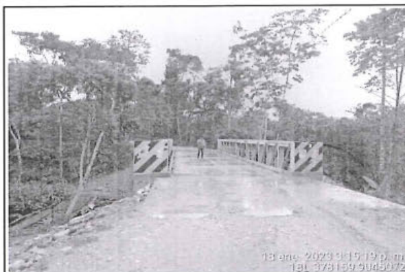
Foto 103: Ponton de fierro galvanizado en buen estado y funcionamiento, ubicado en la progresiva 14+977, la foto muestra entrada al tablero de rodadura del ponton.
