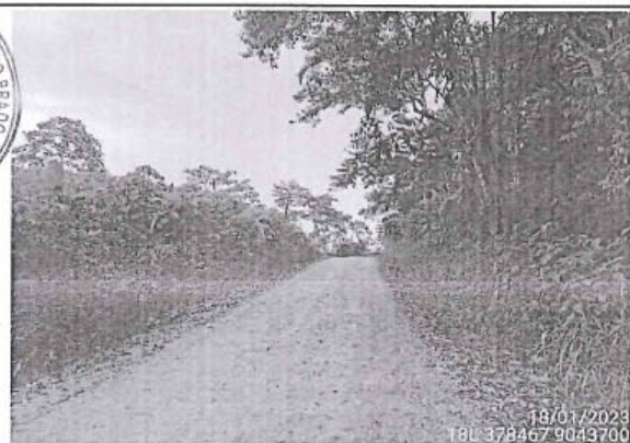
Foto 95: Camino vecinal con superficie de rodadura con afirmado y estado de transitabilidad bueno entre las progresivas 13+451 al 13+500.
