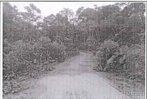
Foto 190: Puente de acero con estado bueno, ubicado en la progresiva 24+095, la foto muestra en tablero de rodadura del puente.
