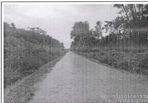
Foto 31: vista del camino vecinal con superficie de rodadura con afirmado y estado de transitabilidad bueno entre las progresivas 5+010 al 5+500.
