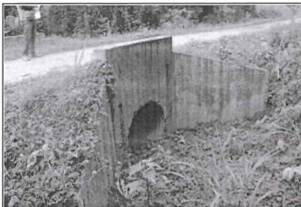
Foto 229: Alcantarilla TMC en buen estado y funcionamiento, ubicado en la progresiva 0+110.
