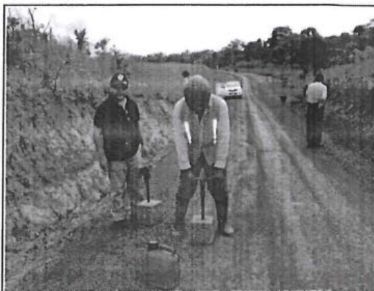
foto 02: Compactación de Baches (Bacheo), en un Mantenimiento Rutinario.
