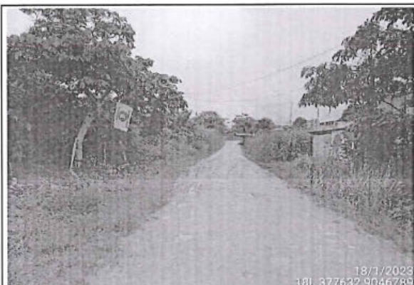
Foto 120: Se observa el camino vecinal con superficie de rodadura con afirmado y estado de transitabilidad regular ubicado en la progresiva del 16+920 al 17+000.
