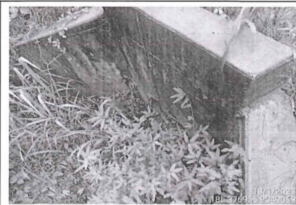
Foto 150: Alcantarilla TMC en buen estado y funcionamiento regular debido a falta de limpieza, se encuentra ubicada en la progresiva 20+230.
