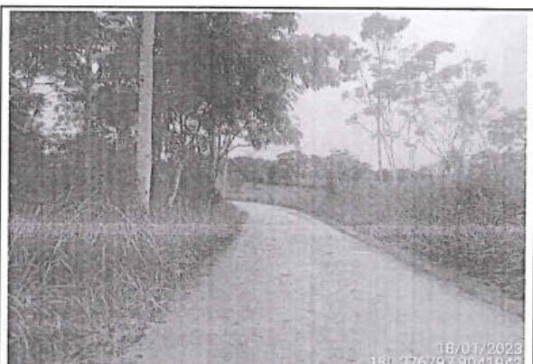
Foto 72: Se observa camino vecinal con superficie de rodadura con afirmado y estado de transitabilidad bueno, entre las progresivas 10+957 al 11+000.
