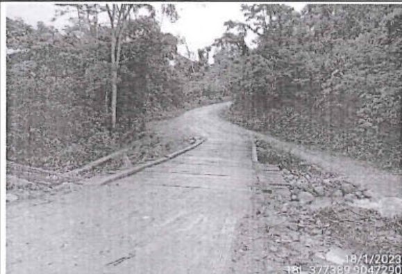
Foto 132: Ponton de madera en condiciones regulares ya que el tablero de rodadura se esta deteriorando a causa del intemperismo, esta ubicado en la progresiva 18+450, la foto muestra entrada al tablero de rodadura al ponton.
