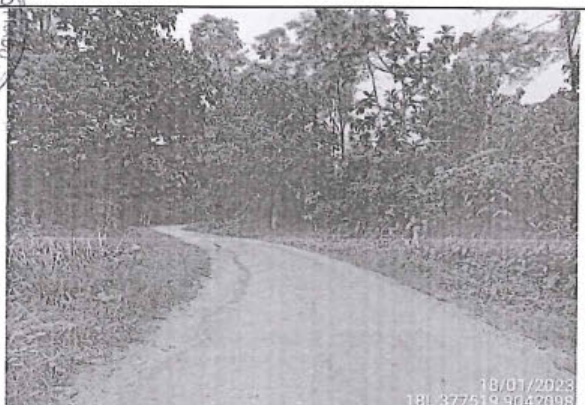
Foto 77: Se observa el camino vecinal con superficie de rodadura con afirmado y estado de transitabilidad bueno entre las progresivas 11+390 al 11+500.
