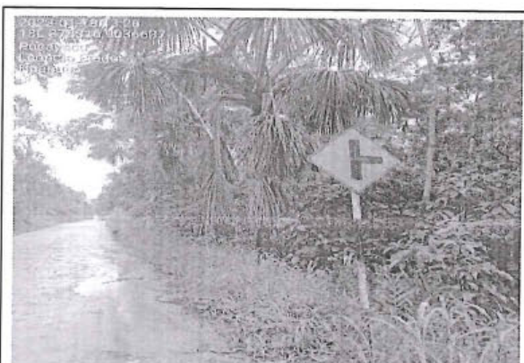
Foto 24: Señal preventiva en buen estado con superficie de rodadura con afirmado y estado de transitabilidad regular ubicado en la progresiva 4+325.
