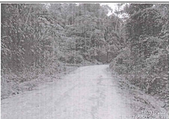
Foto 42: Vista del camino vecinal con superficie de rodadura con afirmado y estado de transitabilidad bueno entre las progresivas 6+986 al 7+000
