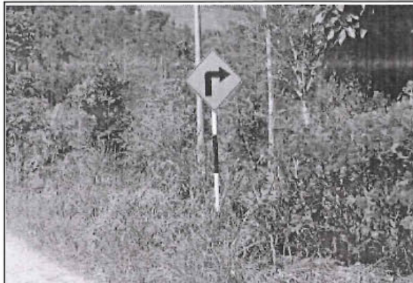
Foto 122: Señal informativa en buen estado con superficie de rodadura con afirmado y estado de transitabilidad bueno ubicado en la progresiva 17+095.
