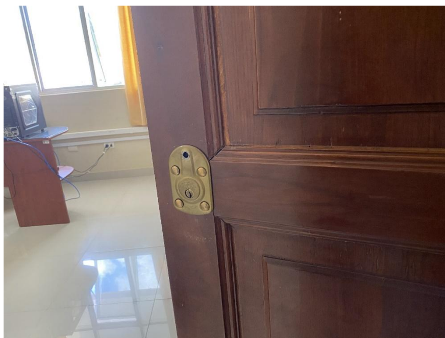
Ilustración 3: Se evidencia cerradura en mal estado de conservación.
