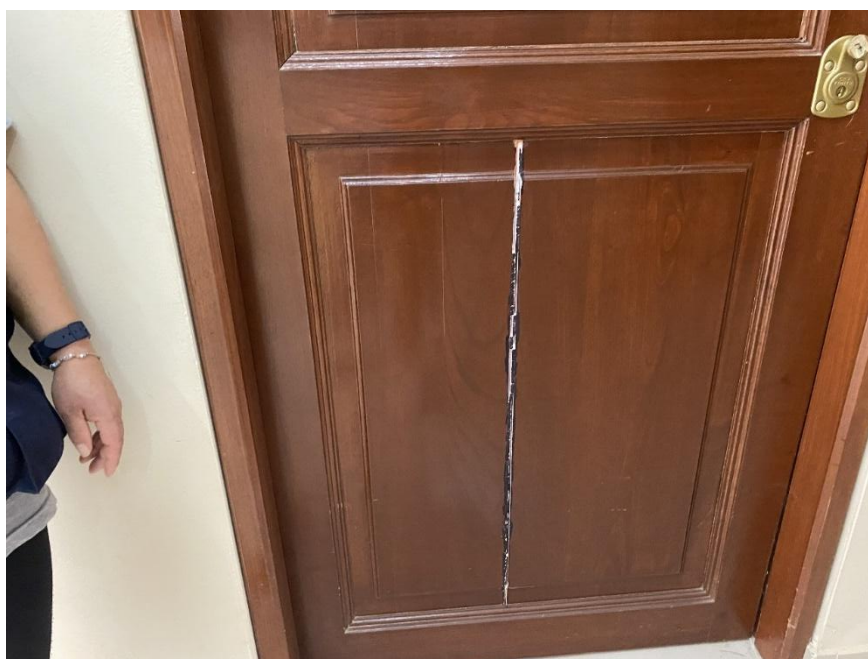
Ilustración 1: Se evidencia la puerta de madera en mal estado de conservación.
