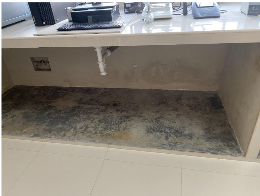
Ilustración 4: Se evidencia el deterioro de mesones en la base de concreto.
