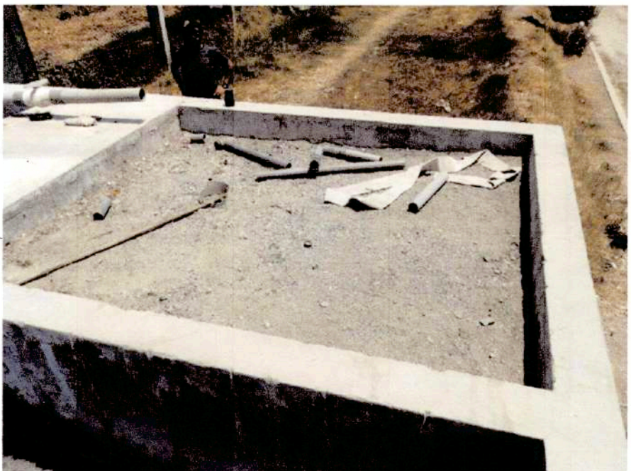
REEMPLAZO DE LOS MEDIOS FILTRANTES DE LOS LECHOS DE SECADO (Actividad 2.5.1)
