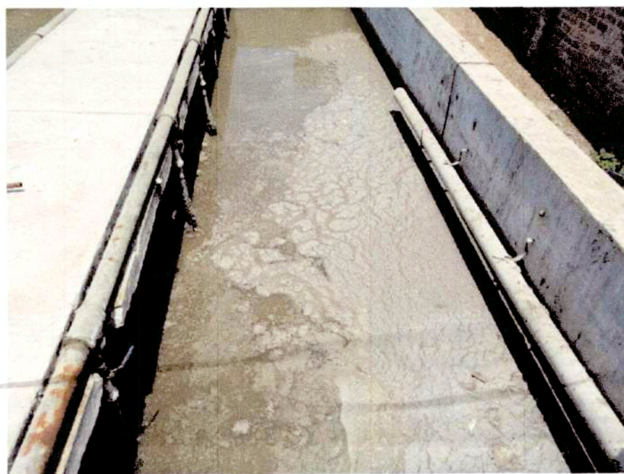
DESATORO DEL SISTEMA DE RETORNO DE LODOS (SEDIMENTADOR DE LODOS-REACTOR DE LODOS ACTIVADOS) (Actividad 1.4.1)
