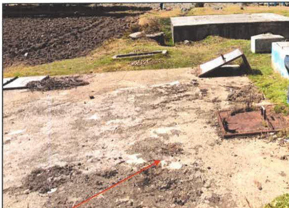
Tanque séptico con una cámara, inoperativo
