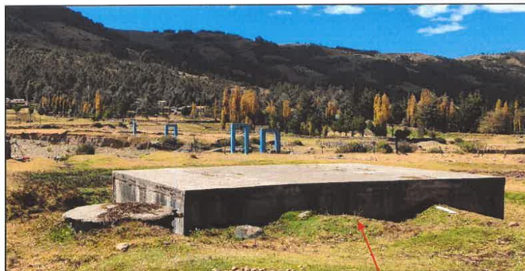
Tanque séptico con dos cámaras en paralelo
