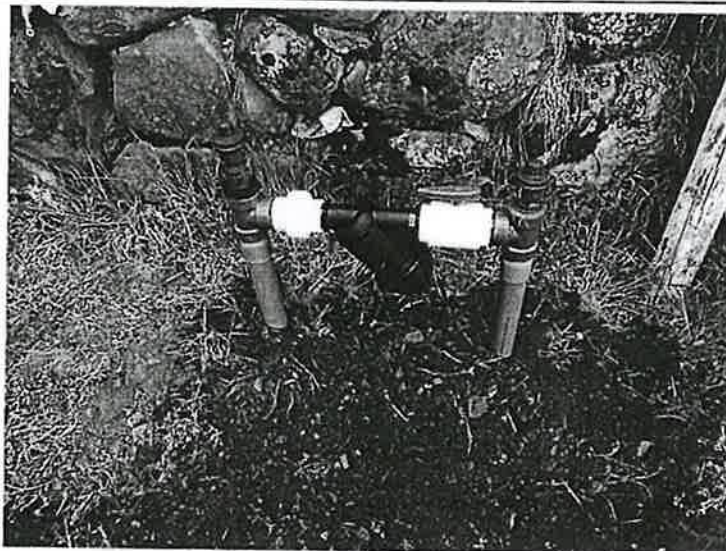
Arco de riego instalado en la EEA Andenes
