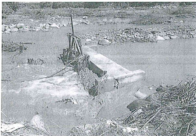
Presencia de material sólido al ingreso de la Bocatoma La Otra Banda - Río Zaña
