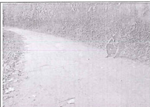
Foto 17: Erosión de nivel de gravedad 2 en el tramo desde la progresiva km 5+559 al km 5+765 con estado de transitabilidad bueno..
