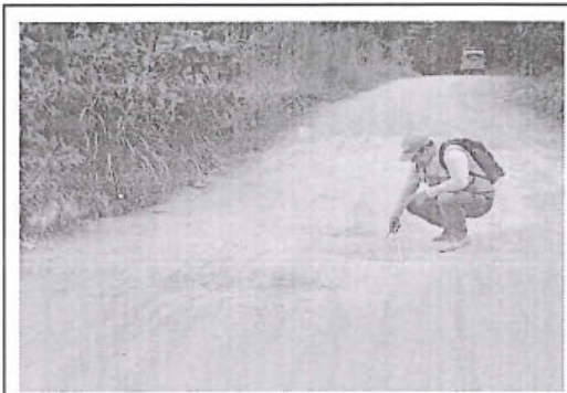
Foto 16: Baches de nivel de gravedad 2 en el tramo desde la progresiva km 5+359 al km 5+480 con estado de transitabilidad bueno.
