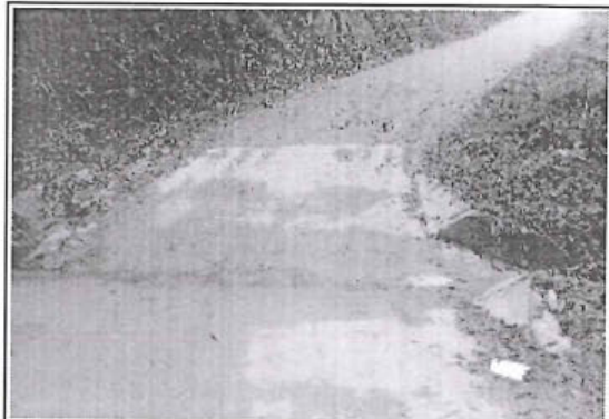
Foto 74: Baden en buen estado de transitabilidad, ubicado en la progresiva km 8+208.
