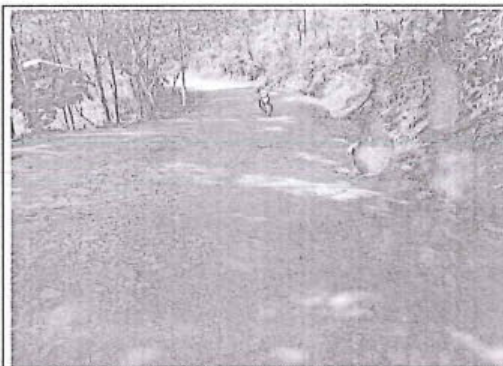
Foto 18: Erosión de nivel de gravedad 1 en el tramo desde la progresiva km 5+768 al km 6+281 con estado de transitabilidad bueno.
