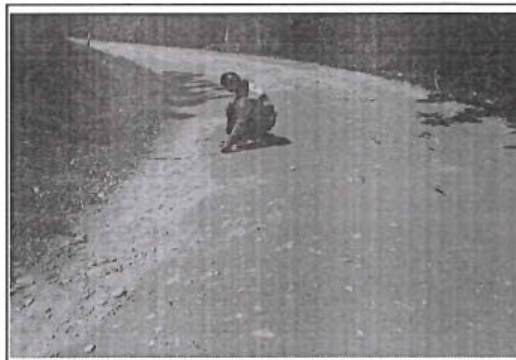
Foto 20: Erosión de nivel de gravedad 3 en el tramo desde la progresiva km 6+595 al km 6+672 con estado de transitabilidad bueno.
