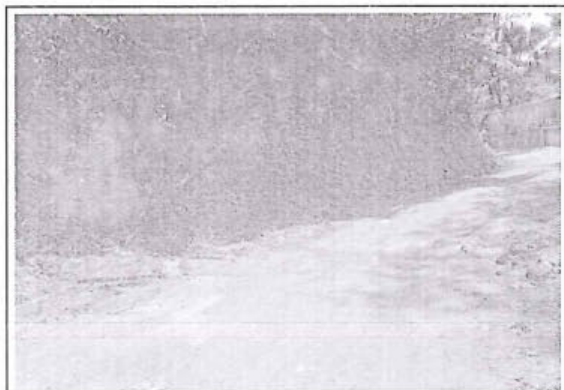
Foto 6: Baches con nivel de gravedad 2 en el tramo desde la progresiva km 0+966 al km 0+970 con estado de transitabilidad regular.
