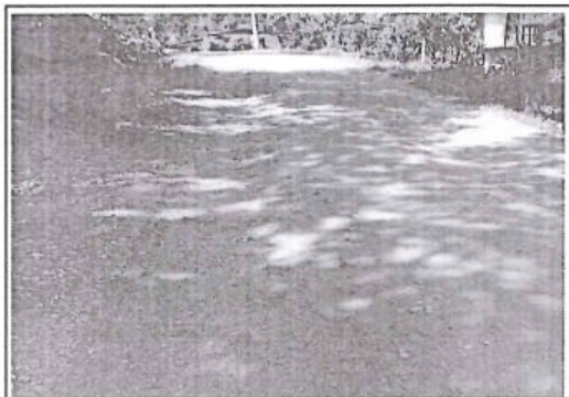
Foto 26: Erosión de nivel de gravedad 2 en el tramo desde la progresiva km 8+252 al km 8+626 con estado de transitabilidad bueno.
