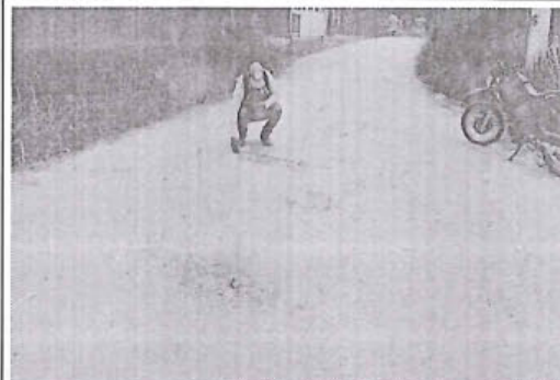
foto 02: Baches de nivel de gravedad 2 en el tramo desde la progresiva km 3+122 al km 3+245, con estado de transitabilidad bueno.
