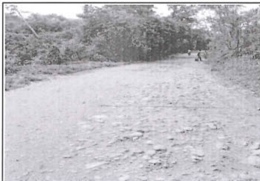
Foto 07: Deformación de nivel de gravedad 3 en el tramo desde la progresiva km 3+913 al km 4+000 con estado de transitabilidad bueno.
