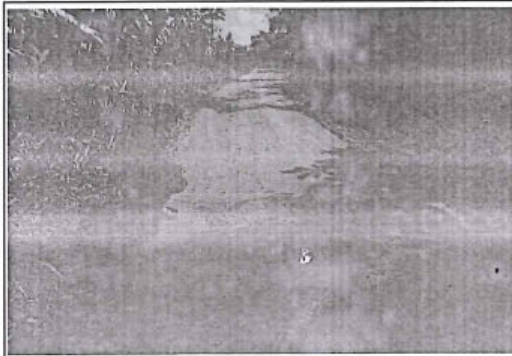
Foto 33: Erosión de nivel de gravedad 2 en el tramo desde la progresiva km 10+977 al km 11+000 con estado de transitabilidad bueno.
