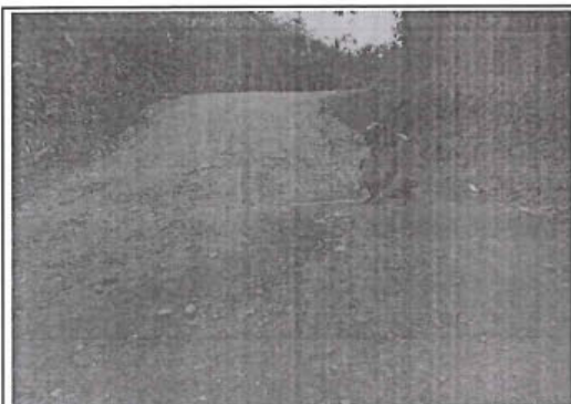
Foto 13: Erosión de nivel de gravedad 2 en el tramo desde la progresiva km 4+816 al km 5+000 con estado de transitabilidad bueno.
