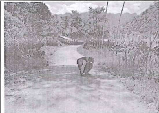
Foto 1: Baches con nivel de gravedad 1 en el tramo desde la progresiva km 0+044 al km 0+050 con estado de transitabilidad bueno.
