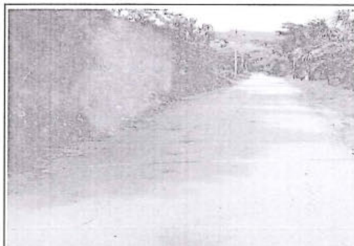
Foto 06: Baches de nivel de gravedad 3 en el tramo desde la progresiva km 3+583 al km 3+807 con estado de transitabilidad bueno.
