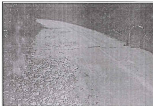
Foto 38: Baches de nivel de gravedad 1 en el tramo desde la progresiva km 11+900 al km 11+999 con estado de transitabilidad bueno.
