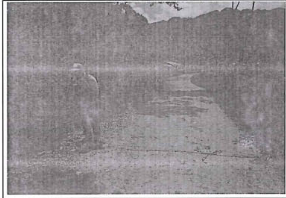
Foto 2: Deformación con nivel de gravedad 2 en el tramo desde la progresiva km 0+240 al km 0+410 con estado de transitabilidad bueno.
