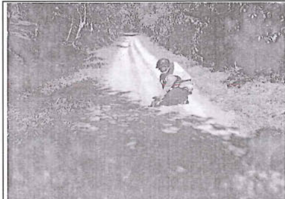
Foto 4: Deformación con nivel de gravedad 2 en el tramo desde la progresiva km 0+526 al km 0+724 con estado de transitabilidad regular.
