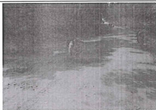
Foto 25: Erosión de nivel de gravedad 2 en el tramo desde la progresiva km 7+834 al km 8+000 con estado de transitabilidad bueno.
