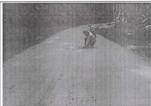
Foto 19: Erosión de nivel de gravedad 3 en el tramo desde la progresiva km 6+314 al km 6+589 con estado de transitabilidad bueno.
