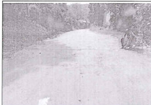
foto 04: Baches de nivel de gravedad 3 en el tramo desde la progresiva km 3+350 al km 3+398, con estado de transitabilidad bueno.
