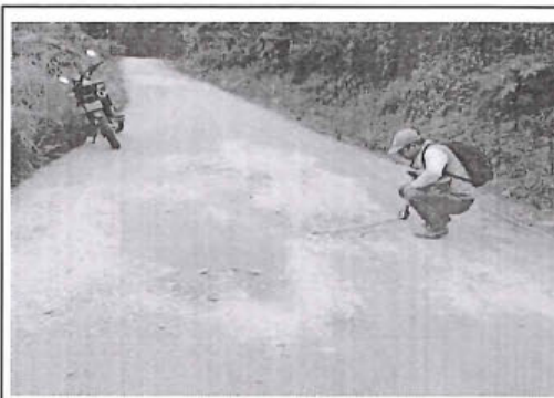
Foto 08: Baches de nivel de gravedad 3 en el tramo desde la progresiva km 4+000 al km 4+099 con estado de transitabilidad bueno.
