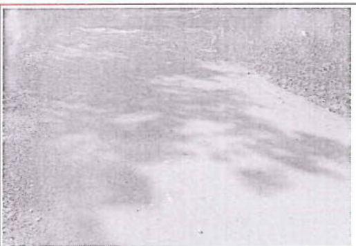
Foto 23: Erosión de nivel de gravedad 1 en el tramo desde la progresiva km 7+318 al km 7+551 con estado de transitabilidad bueno.
