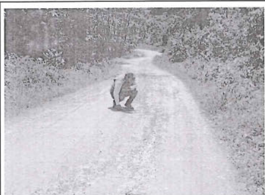
Foto 13: Erosión con nivel de gravedad 3 en el tramo desde la progresiva km 2+570 al km 2+620 con estado de transitabilidad bueno.
