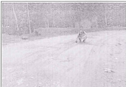
foto 24: Erosión de nivel de gravedad 2 en el tramo desde la progresiva km 7+563 al km 7+821 con estado de transitabilidad bueno.
