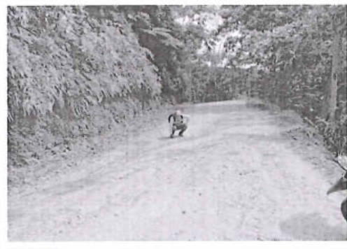
Foto 32: Erosión de nivel de gravedad 2 en el tramo desde la progresiva km 10+500 al km 10+960 con estado de transitabilidad bueno.
