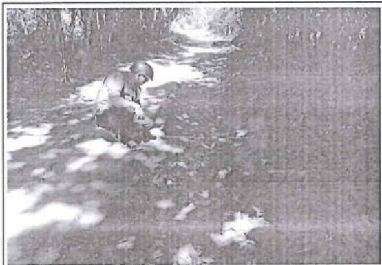
Foto 7: Erosión con nivel de gravedad 3 en el tramo desde la progresiva km 1+086 al km 1+169 con estado de transitabilidad bueno.
