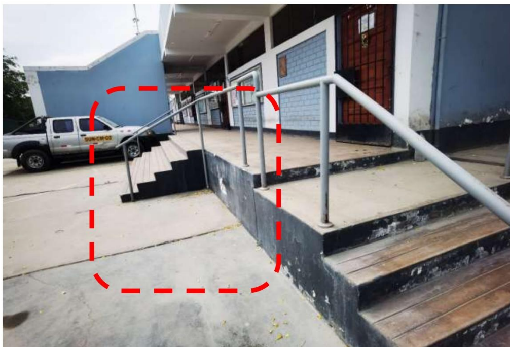
Fotografía N° 03.- Vista de Rampa N°03 ya que no existe ingreso para movilidad reducida se plantea una rampa lineal hacia esa plataforma.
