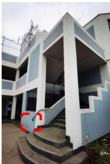
Fotografía N° 08.- El pabellón está elevado 15cm, así que se propone la ubicación de la rampa para la llegada de los usuarios con movilidad reducida.
