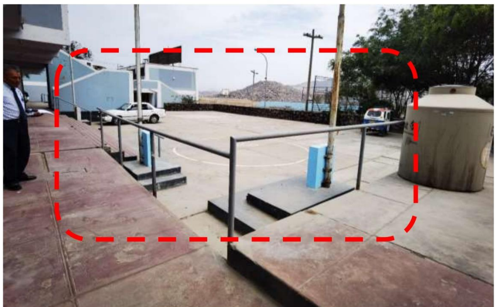
Fotografía N° 02.- Las barandas existentes entre plataformas de más de 55cm no cuentan con la medida de seguridad reglamentaria, así que se propone barandas de 1m. de altura.
