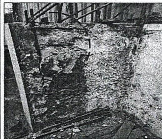
SE OBSERVA EXPOSICIÓN DE LOS ACEROS Y SALITRE
