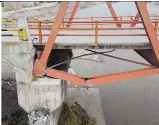
Vista 6. Vigueta transversal dañada del puente reticulado
