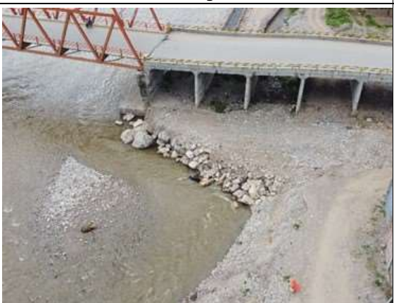
Vista 5. Vista aérea de la alcantarilla tipo marco de concreto, colapsada (margen derecha)
