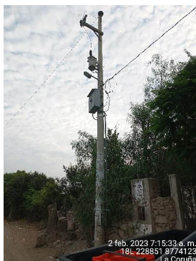
Transformador de La Coruña con presencia de fuga de aceite
