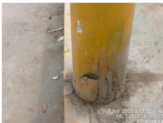
Estructuras de las redes secundarias de Vilcahuaura en mal estado, presenta grietas en su base, ésto sucede en el 80% de las estruturas de ésta Loc.
