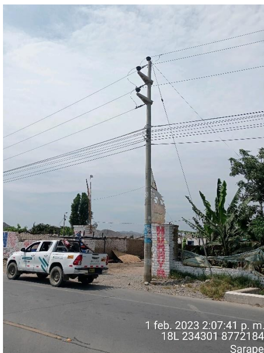
Sarape. Conductor de la media tensión, incumple DMS respecto a viviendas construidas
