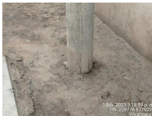
Estructuras de las redes secundarias de Vilcahuaura en mal estado, presenta grietas en su base, ésto sucede en el 80% de las estruturas de ésta Loc.
