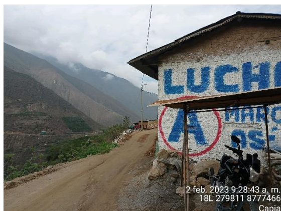
Capia, Incumplimiento de Distancias Mínimas de Seguridad de conductor autoportante y techo de vivienda
