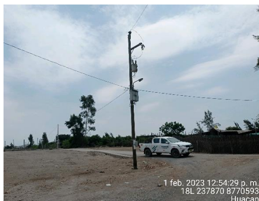
Estructura de la SE de Huacan fue cambiado por poste de madera por el mal estado del poste de concreto.
