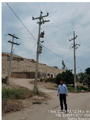
SE de Santa Rosalía, Resume aceite de Transformador, Tablero muestra oxido
