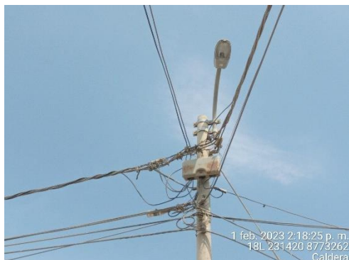
RS de la caldera con accesorios de armado con síntomas de corrosión y caja de derivación con presencia de óxido.
