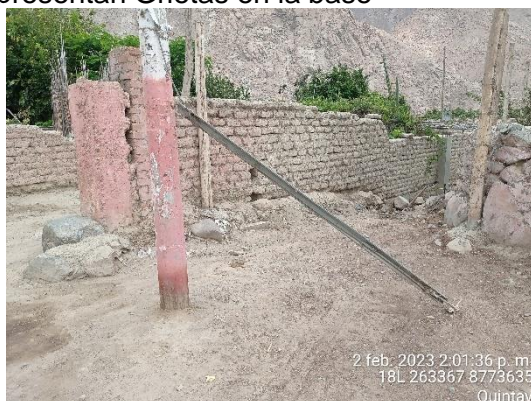
Tres Montones, Estructuras de las RS presentan Grietas en la base
