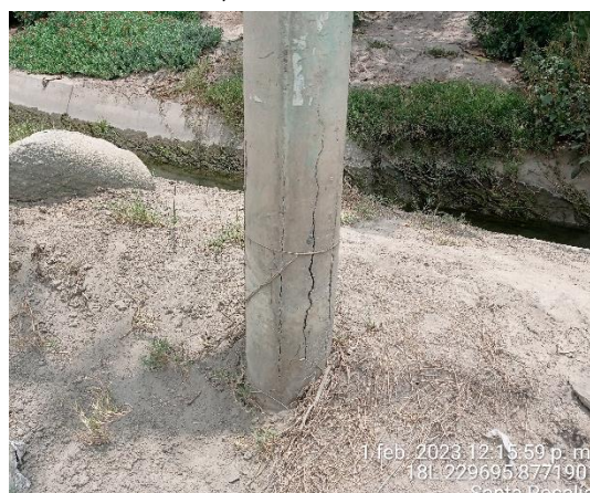
Estructuras de RS de Santa Rosalía, con presencia de grietas en su base.
