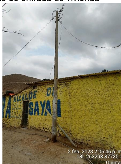
Quintay, Retenida de RS en mal estado, esto hace que el poste sufra esfuerzo e inclinación.
