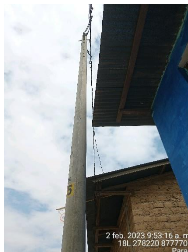
Redes secundarias de Paran que incumplen las distancias minimas respect al techo de vivienda.
