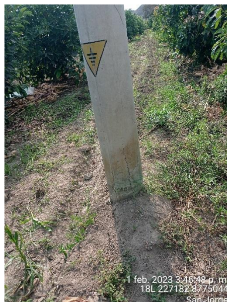
Estructuras de las redes secundarias con presencia de grietas en su base.
