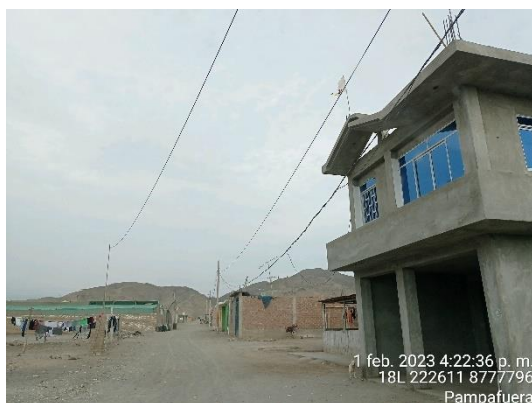
Pampafuera, DMS de conductor autoportante respecto a vivienda y al suelo
