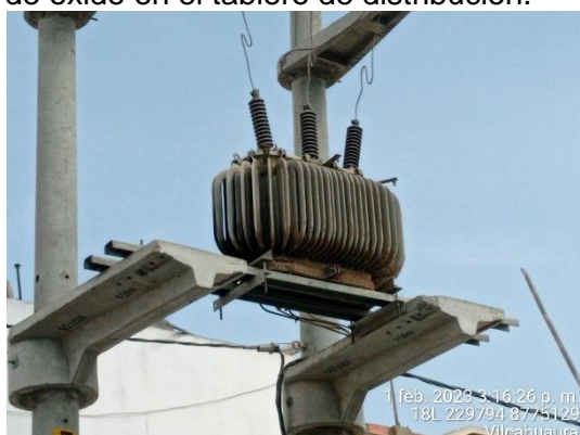
Subestacion de Vilcahuaura con presencia de oxido en el transformador
