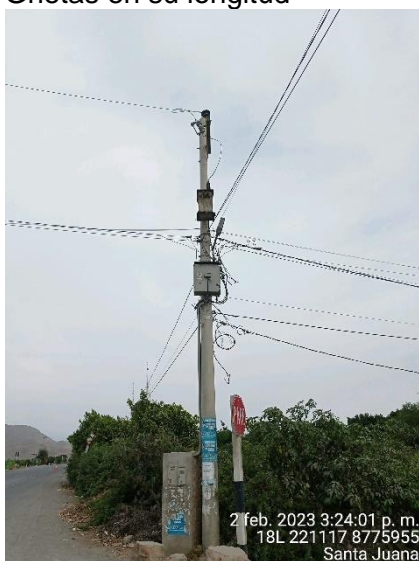
Santa Juana, Subestacion presenta fuga de aceite del transformador, tablero con presencia de oxido
