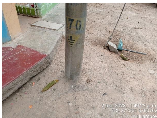
Huamboy, Estructuras con grietas en la base y retenida en mal estado..
