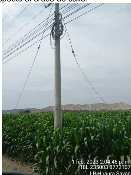
Retenidas de la Línea Primaria en mal estado.
