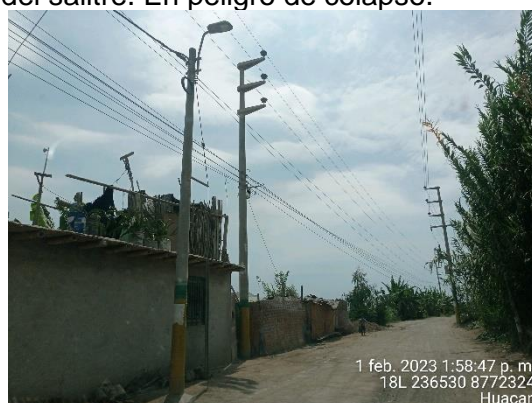
Huacan, Estructuras de la RP muy apegado a la vivienda, Conductor de media tensión incumple DMS respecto a proyección de vivienda .
