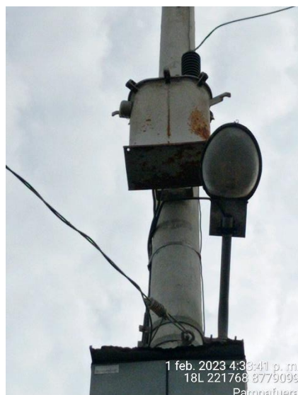
Subestacion de Pampafuera presenta oxido tanto en el transformador y en el tablero.
