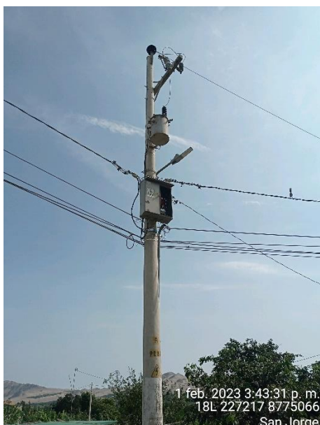
San Jorge, Subestacion con presencia de fuga de aceite del transformador, asimismo, el tablero de distribucion no cuenta con la puerta correspondiente.
