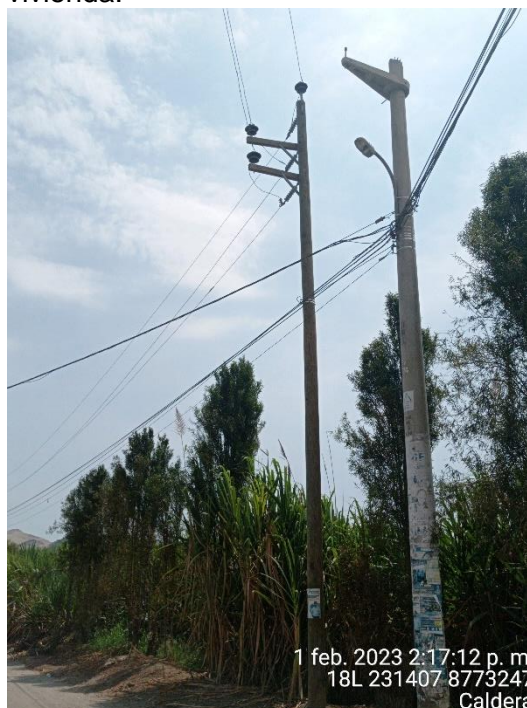
Estructuras de MT de la Caldera en mal estado que ya se venía cambiando de acuerdo a la emergencia suscitada.
