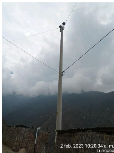
Luricaca, Redes de MT y BT pasan por encima de viviendas
