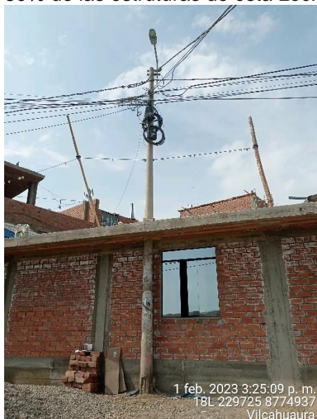
Estructura de Red Secundaria en medio de la construccion, product de la construccion de viviendas nuevas.
