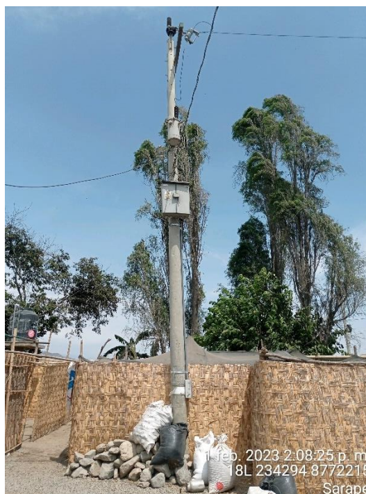
Estructura de SE en Sarape, instalado muy cerca a límite de vivienda incumpliendo DMS el transformador y conductor con línea viva respecto a vivienda.
