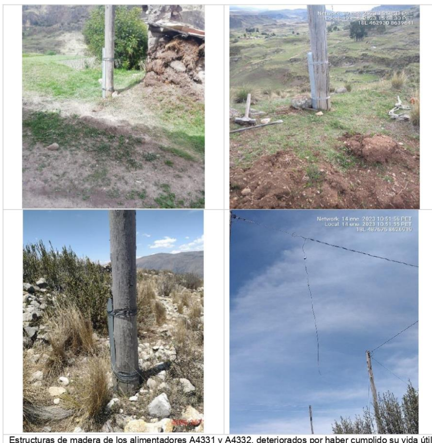
Estructuras de madera de los alimentadores A4331 y A4332, deteriorados por haber cumplido su vida útil
