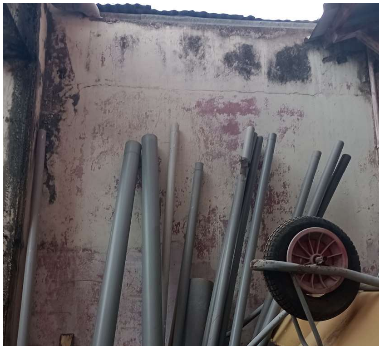
Foto 17: Fisuras en viga de muro de patio debajo de tanque elevado.
