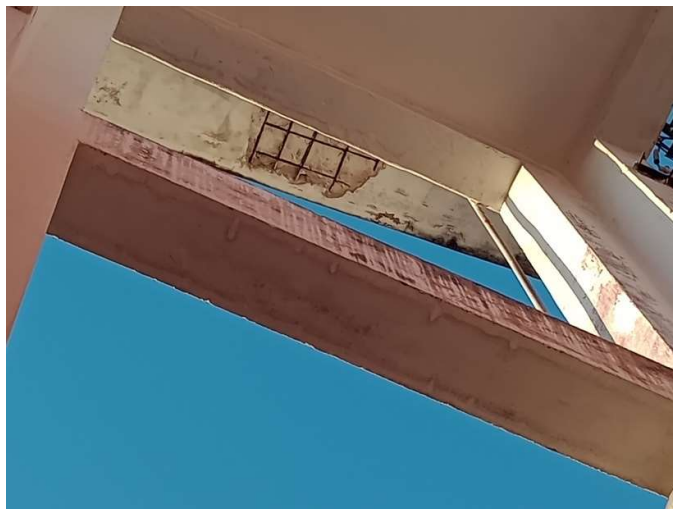
Foto 4: Desprendimiento del concreto en alero de techo de tanque cisterna (lateral).
