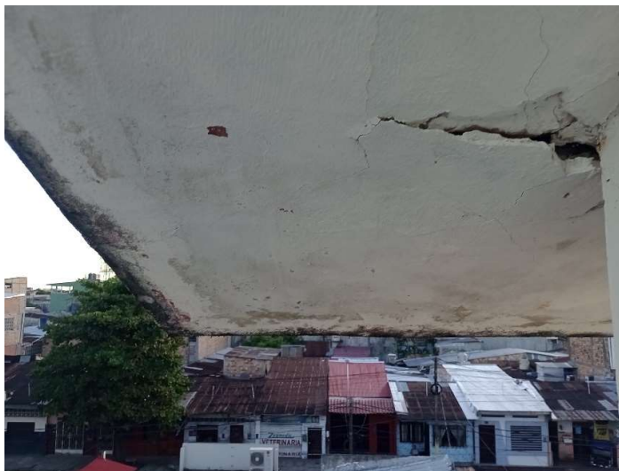
Foto 5: Desprendimiento del concreto en alero de techo de tanque cisterna (frente a calle pablo rossell).
