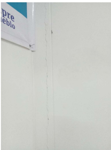
Foto 12: Fisuras en columna de auditorio.
