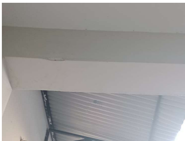
Foto 16: Fisuras en viga de pasadizo de 1er piso frente a escalera.
