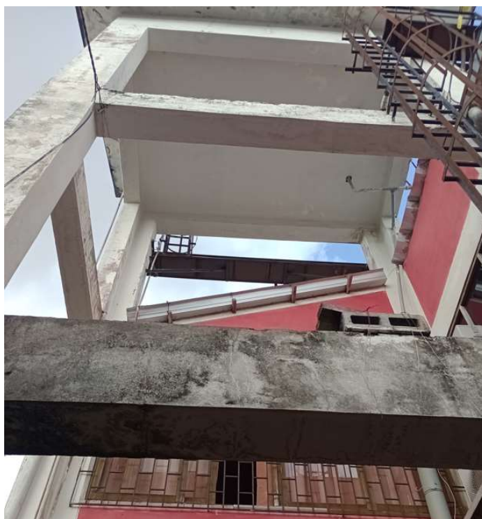
Foto 18: Fisuras en viga de tanque elevado.
