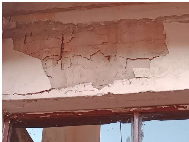
Foto 2: Desprendimiento del concreto en vigas de patio a lado de cisterna.
