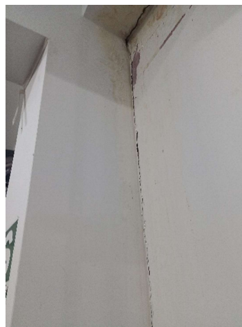
Foto 13: Fisuras en vigas y columna en almacén.
