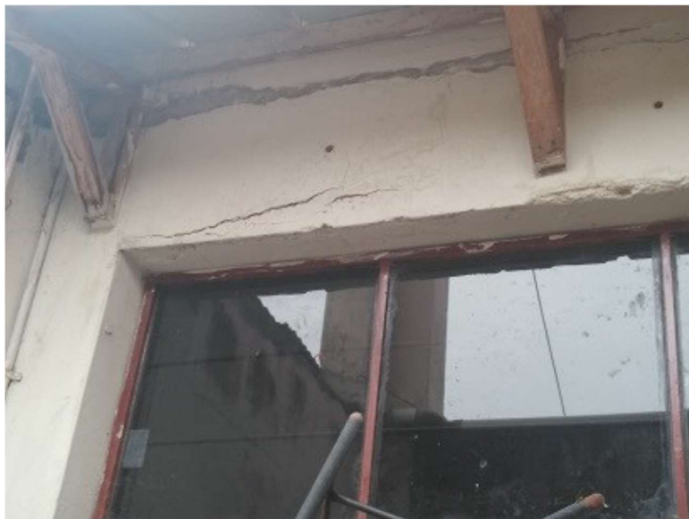
Foto 11: Fisuras en viga peraltada de taller de albañilería.
