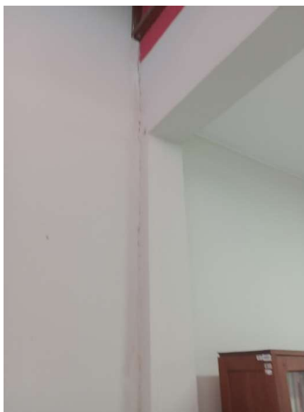
Foto 14: Fisuras en columna de pasadizo de 1er piso frente a escalera.
