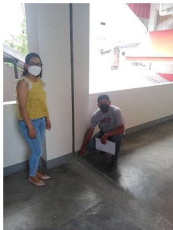
Foto 9: En pasadizo de 2do piso, se visualiza han sellado la junta de dilatación en piso con mortero, la cual requiere ser rellena con plancha de Tecnopor de 6" y sellado con elastomérico flexible y tapa junta metálico.
