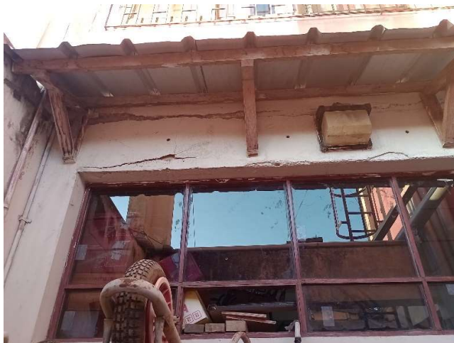
Foto 2: Desprendimiento del concreto en vigas de patio a lado de cisterna.
