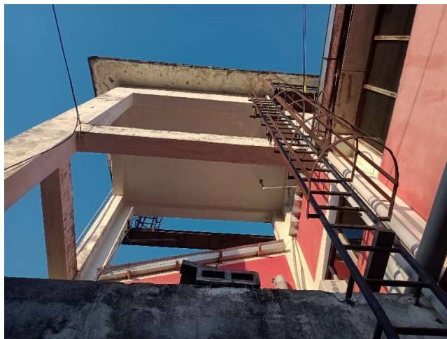
Foto 19: Fisuras en viga de tanque elevado.
