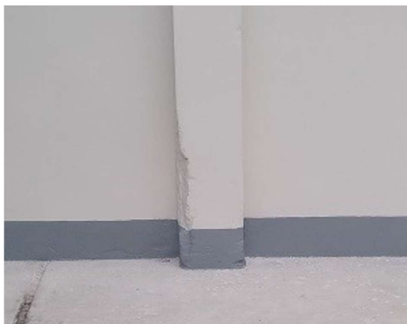
Foto 1: Desprendimiento del concreto en columna de zona de estacionamiento.
