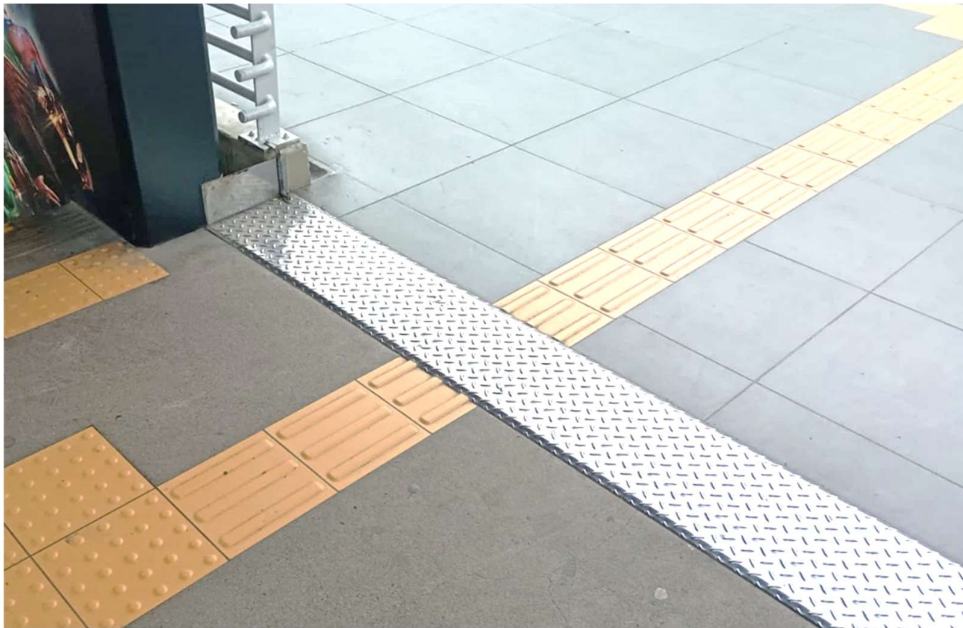
Foto 10: Detalle referencial de tapa junta metálico en piso.
