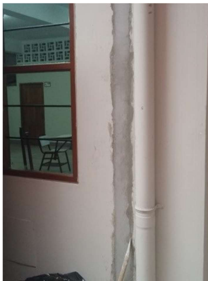
Foto 7: Entre taller de albañilería y almacén, se visualiza Junta de dilatación sellada con mortero, la cual requiere el tratamiento.
