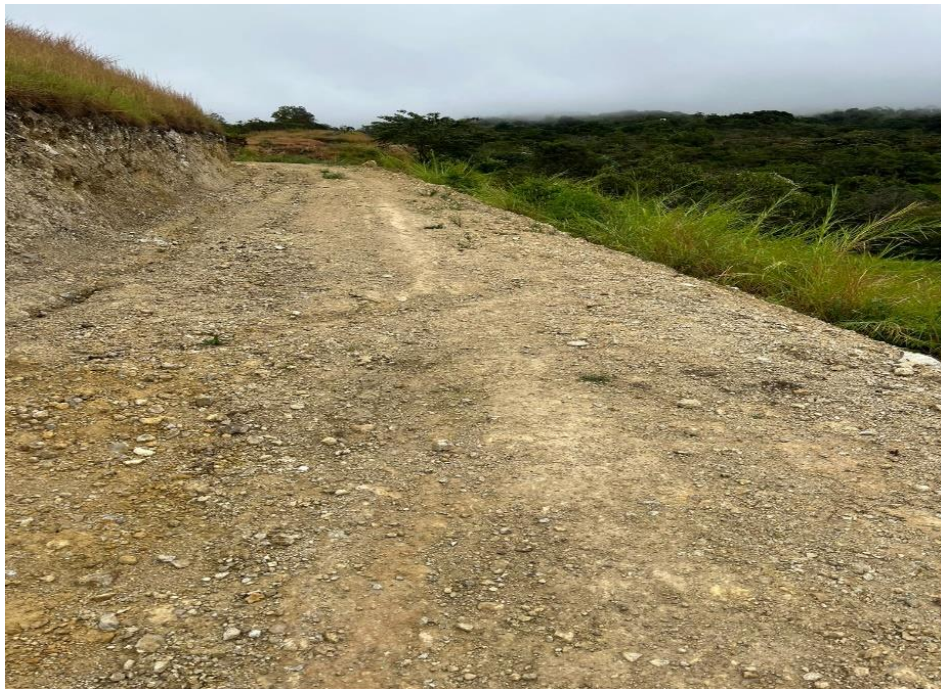
Fotografía N°05: Vista del estado actual de la vía la cual se encuentra perteneciente este tramo a una trocha carrozable, no cuenta con material afirmado, cunetas, etc.
