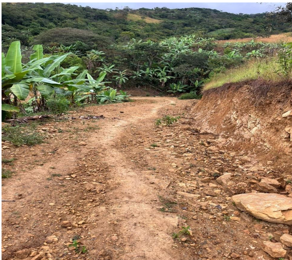
Fotografía N°10: Vista del estado actual de la vía la cual se encuentra perteneciente este tramo a una trocha carrozable, no cuenta con material afirmado, cunetas, etc.
