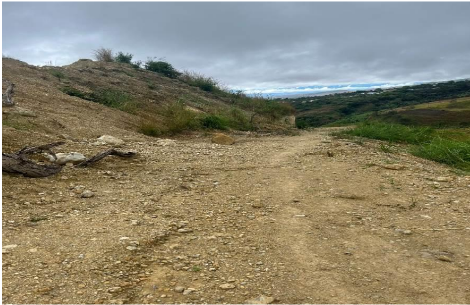
Fotografía N°03: Vista del estado actual de la vía la cual se encuentra a nivel de trocha carrozable, no cuenta con material afirmado, y siendo muy pequeña para su transitabilidad.
