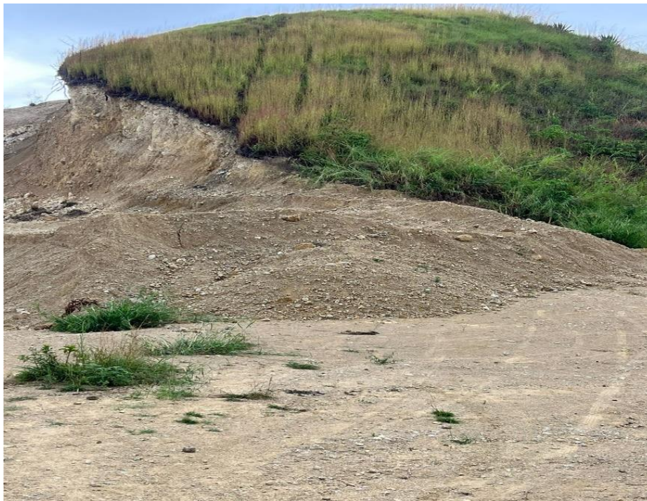
Fotografía N°04: Vista del estado actual de la vía la cual se encuentra perteneciente este tramo a una trocha carrozable, no cuenta con material afirmado, cunetas, etc.
