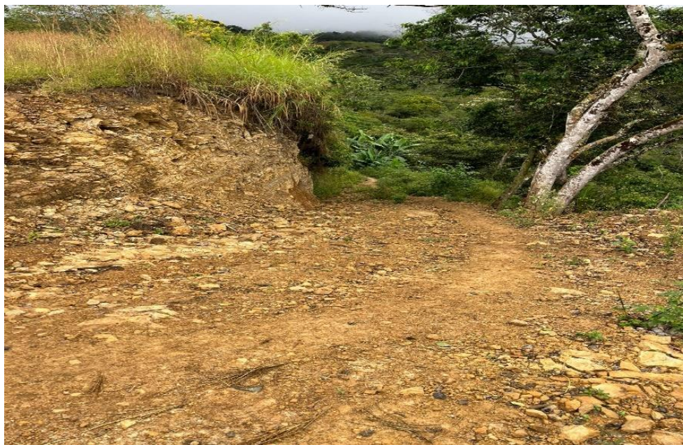
Fotografía N°07: Vista del estado actual de la vía la cual se encuentra perteneciente este tramo a una trocha carrozable, no cuenta con material afirmado, cunetas, etc.
