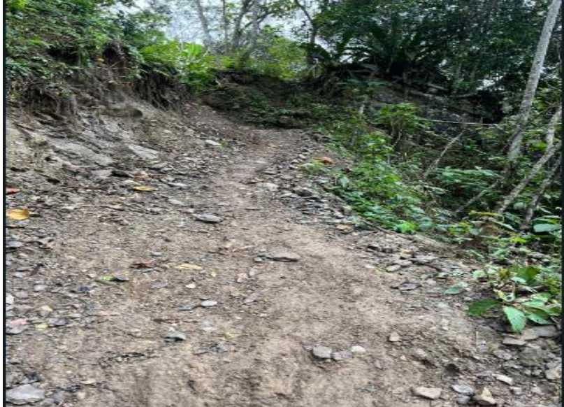
Fotografía N°01: Vista del estado actual de la vía la cual se encuentra perteneciente este tramo a una trocha carrozable, no cuenta con material afirmado, cunetas, etc.
