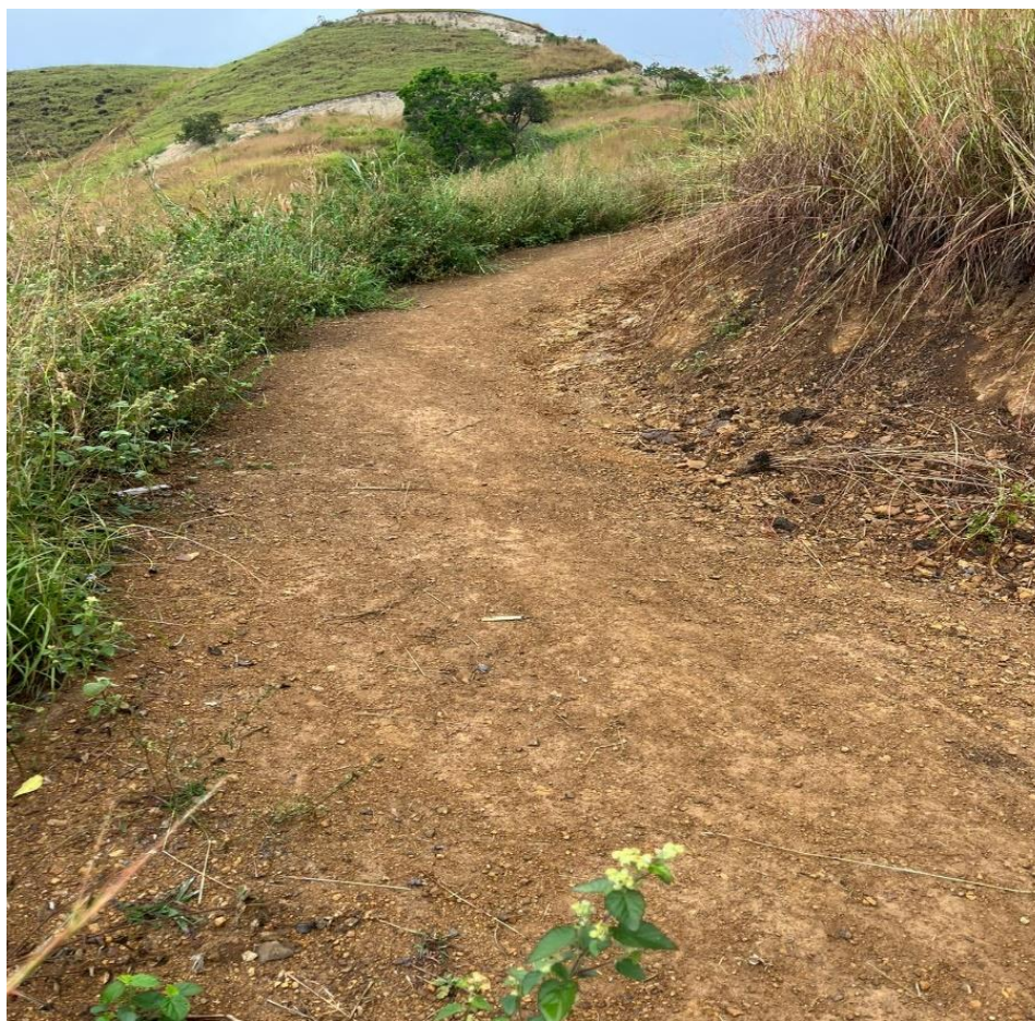
Fotografía N°08: Vista del estado actual de la vía la cual se encuentra perteneciente este tramo a una trocha carrozable, no cuenta con material afirmado, cunetas, etc.
