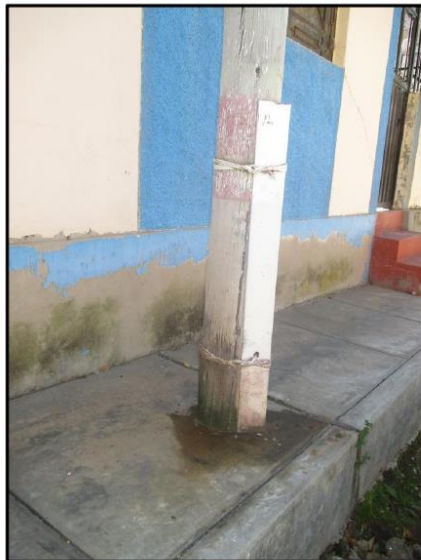
Fig. N° 07: Postes en mal estado Tallapuquio
