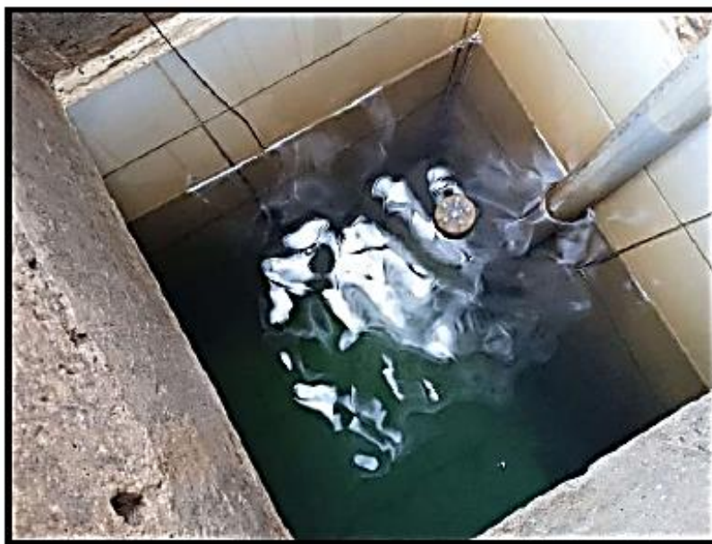
Imagen N° 10: Se observa la falta de limpieza en la cisterna, se plantea limpieza y desinfección.
