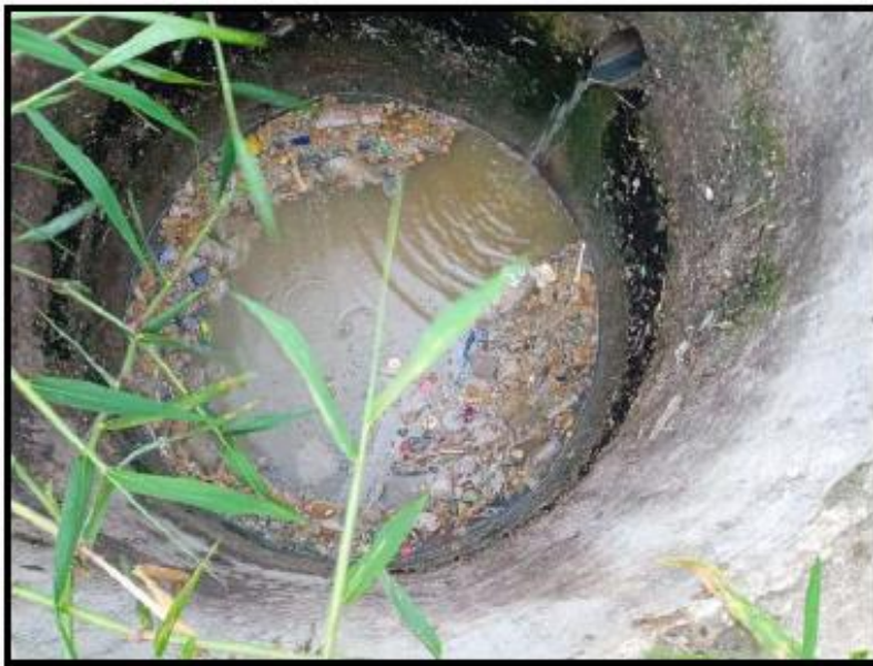
Imagen N° 7: Se observa presencia de acumulación y colmatación de aguas negras dentro del buzón, se plantea limpieza, descolmatación y desinfección.
