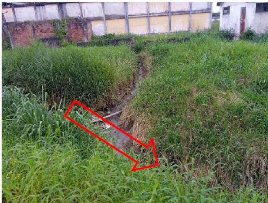
Imagen N° 13: Se observa una zana de aguas residuales a cielo abierto, se plantea instalación de tubería PVC UF 8”.
