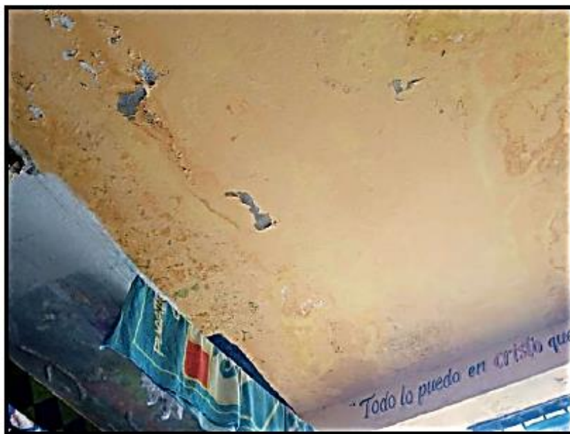
Imagen N° 11: Se observa presencia de marcas de filtración, se plantea la reparación de las tuberías ya sea de agua o desagüe.
