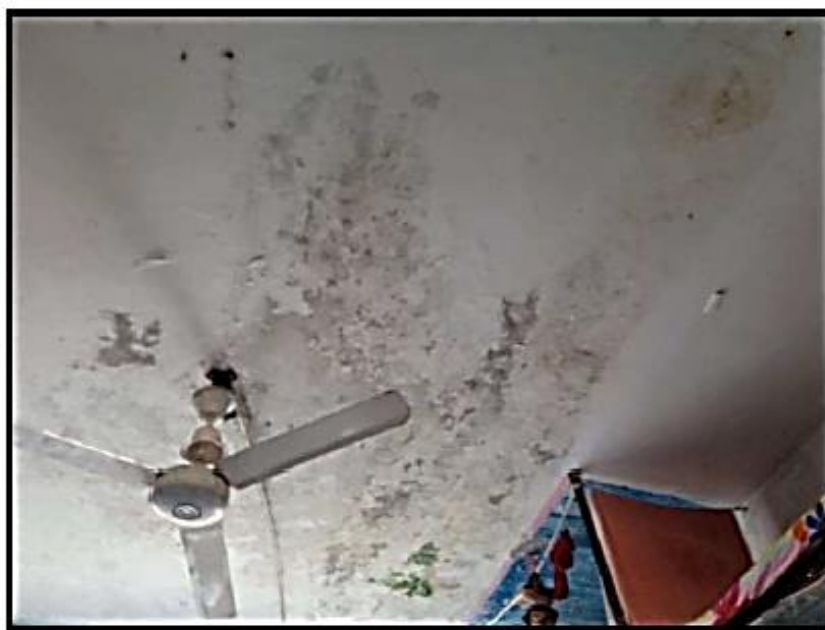
Imagen N° 12: Se observa presencia de marcas de filtración, se plantea la reparación de las tuberías ya sea de agua o desagüe.
