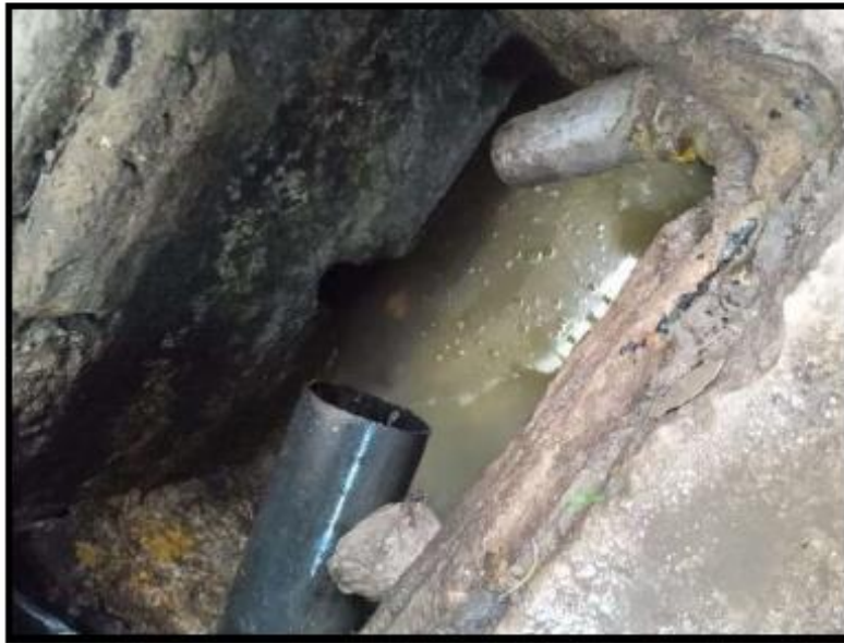
Imagen N° 3: Se observa una caja registro colmatada, se plantea descolmatar, limpiar y desinfectar.
