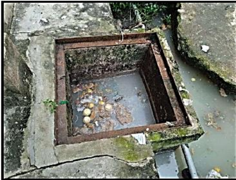
Imagen N° 9: Se observa presencia de acumulación y colmatación de aguas negras dentro del la caja registro de uno de los pabellones, se plantea limpieza, descolmatación y desinfección.
