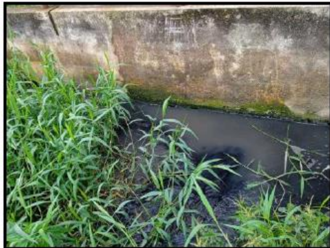
Imagen N° 6: Se observa presencia de acumulación de aguas negras, se plantea limpieza, instalación de
