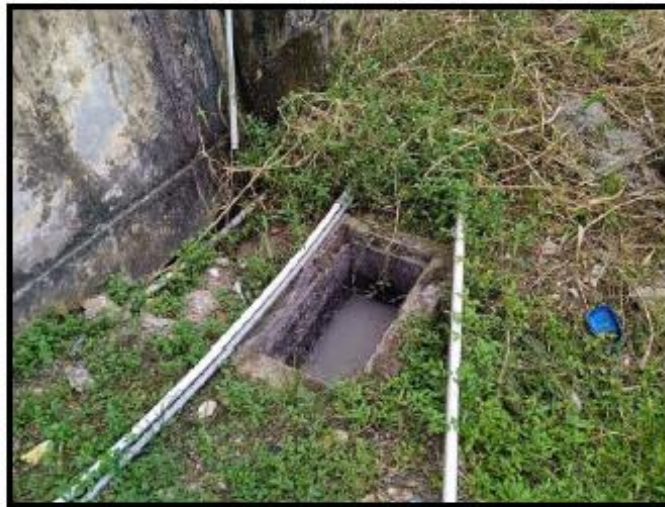
Imagen N° 4: Se observa una caja registro colmatada, se plantea descolmatar, limpiar y desinfectar.
