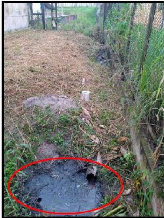
Imagen N° 5: Se observa presencia de acumulación de aguas negras, se plantea limpieza, instalación de tubería UF-S25 y caja registro.
