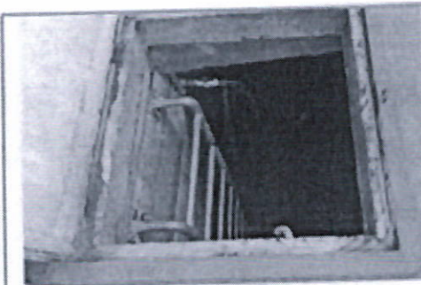
Imagen N° 01: Puerta metálica de cisterna, ubicado en patio de emergencia con corrosión y accesorios de control con desperfectos.
