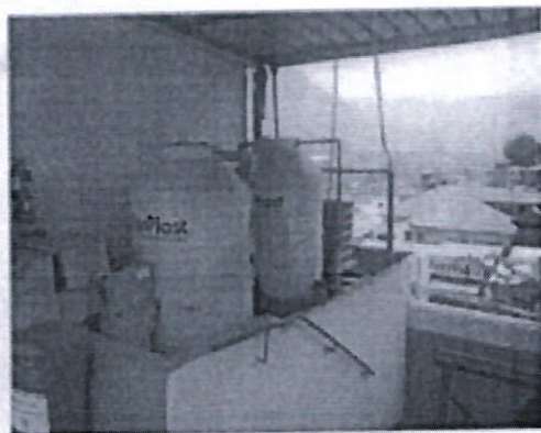
Imagen N° 08: Tanques elevados en funcionamiento, requiere cambio de accesorios en tubería de alimentación.
