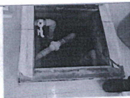
Imagen N° 02: Puerta metálica galvanizada de cisterna, ubicado en la cocina, requiere cambio de accesorios de control y mantenimiento de tapa metálica galvanizada.
