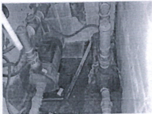
Imagen N° 09: Bomba de agua de 5 hp averiadas, requiere reposición para su óptimo funcionamiento.
