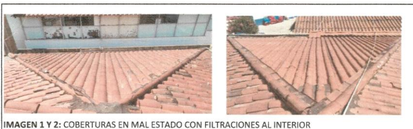
IMAGEN 1 Y 2: COBERTURAS EN MAL ESTADO CON FILTRACIONES AL INTERIOR
