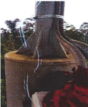
Foto N°32: Unión entre tubo de 16" y 4" soldadas.
