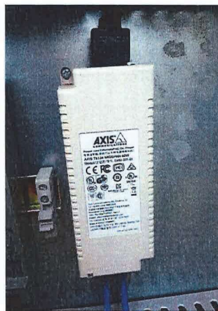
Foto N°14: Placa de POE para camara Axis Honeywell. 60 Watts
