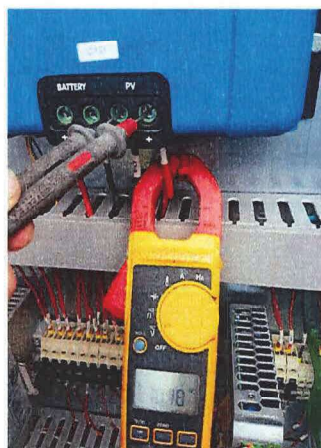
Foto N°18: Tensión de ingreso a regulador de carga-Paneles: 101.8 Vdc
