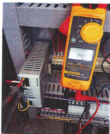
Foto N°24: Tensión de fuente 24 Vdc:
