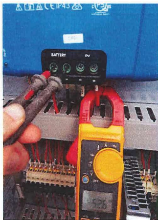
Foto N°18: Tensión de salida de regulador de carga- Baterías: 52.6 Vdc
