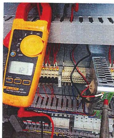
Foto N°25: Tensión de fuente de 12 Vdc: 12.1 Vdc
