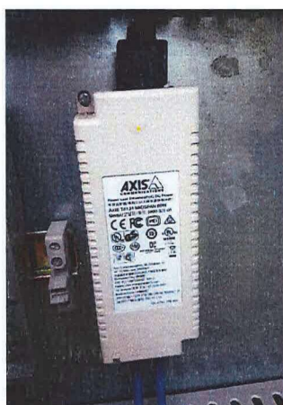
Foto N°15: Placa de POE para camara Axis Honeywell. 60 Watts
