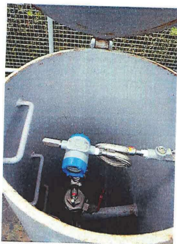
Foto N°3: Transmisor Hart 1 apagado.
