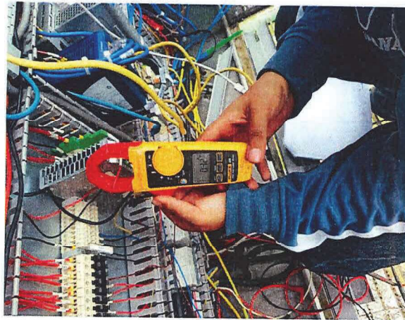
Foto N°13: Consumo salida de Fuente 12 Vdc: 420 mAdc
