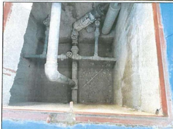
IMAGEN N° 20: CAJA DE VÁLVULAS DEL RESERVORIO EXISTENTE DE CCAPACCA
