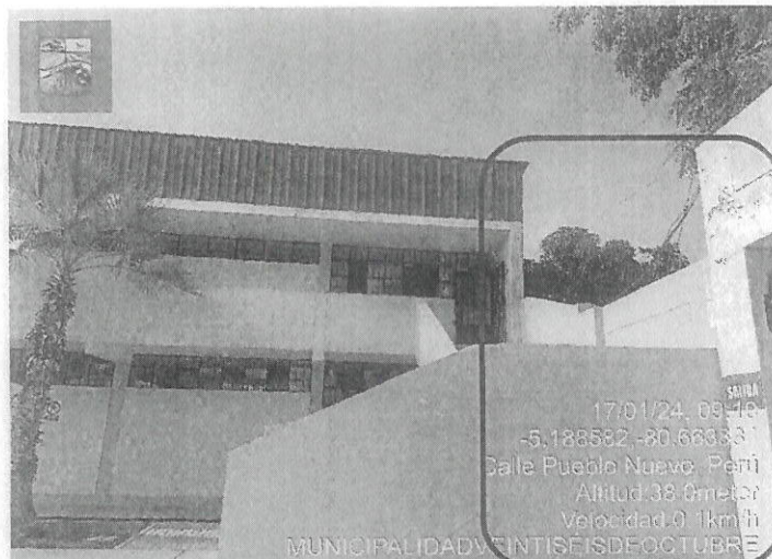
IMAGEN N°03: Pabellón de dos niveles por el lado de la Ca. Pueblo Nuevo la infraestructura funciona como cerco perimétrico, siendo inadecuado ya que la infraestructura debe estar libre con un espaciamiento mínimo según RNE .
