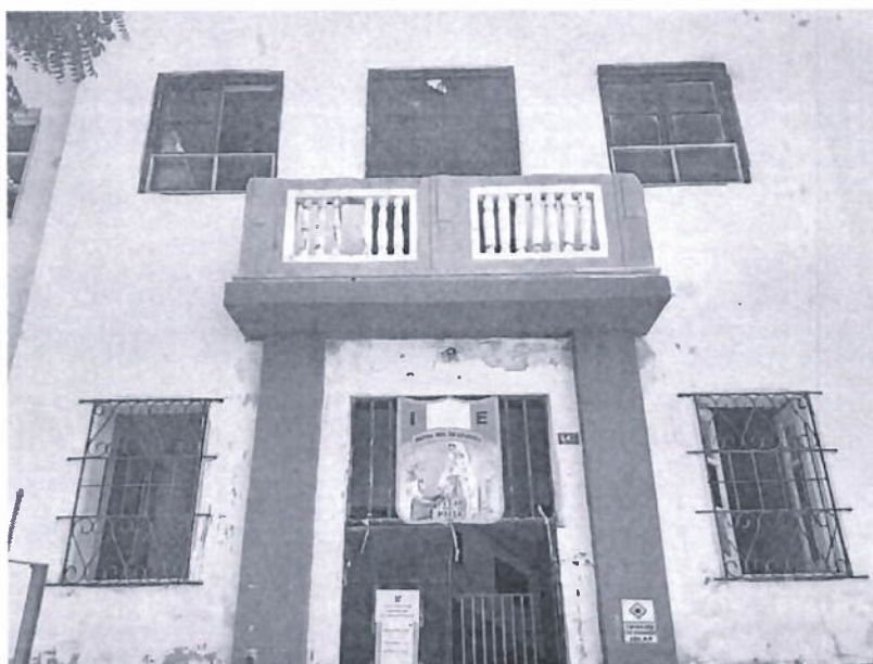
Se muestra la fachada principal de la IE. muros deteriorados por caducidad de vida útil.
