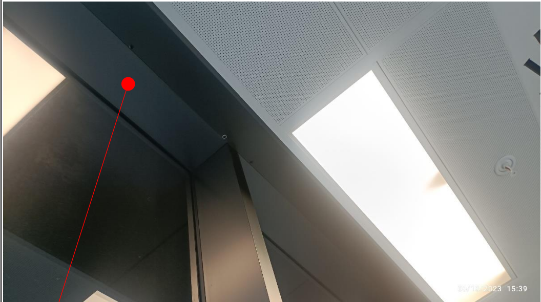
Panel de aluminio en falso cielo raso donde se instalarán las cortinas black out
