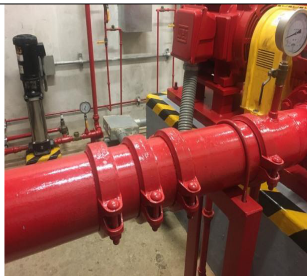
Tramos flexibles sistema contra incendio
