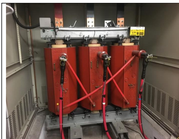
Transformadores secos en S.E.
