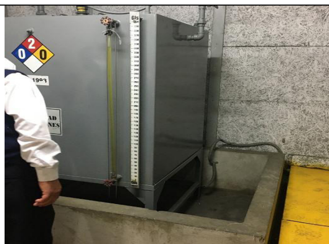
Tanque de combustible para el grupo electrógeno con muro contenedor de derrames
