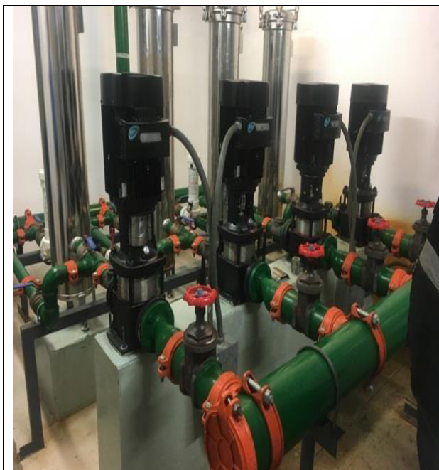
Bombas para agua potable
