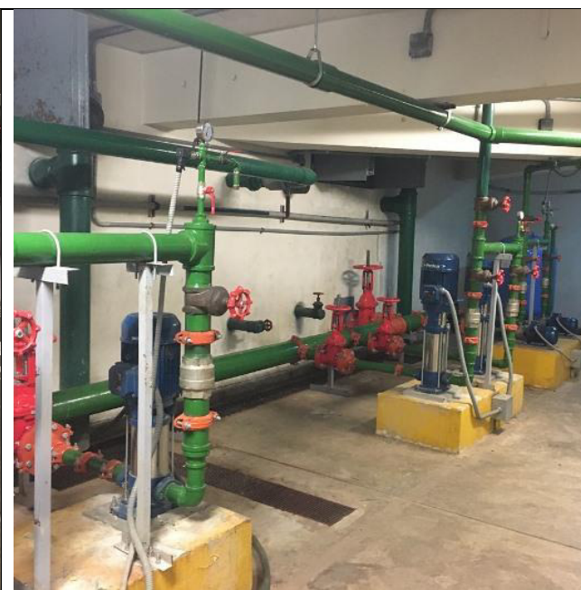
Bombas de presión constante del sistema de agua potable
