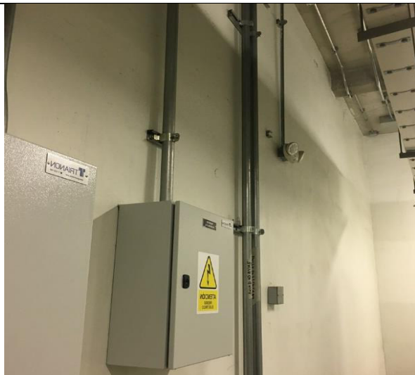
Los sistemas eléctricos están empotrados y entubados y también en bandejas de metal
