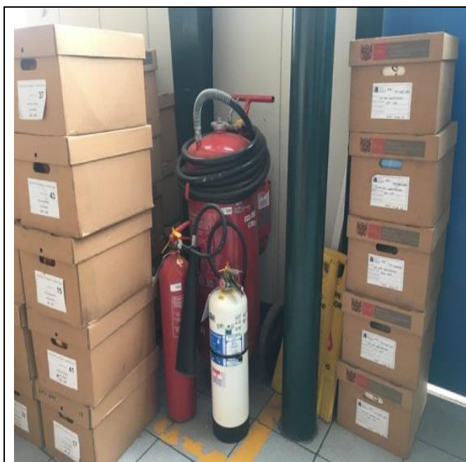
Extintores portátiles y rodantes
