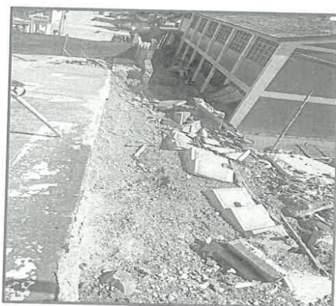
Vista de las graderías colapsadas
