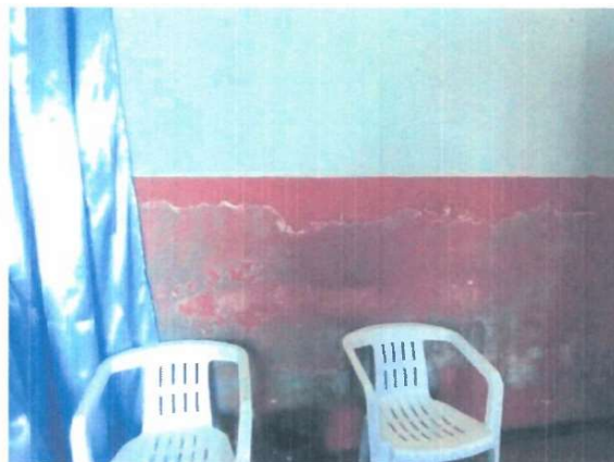
DESPRENDIMIENTO DE TARRAJEO Y PINTURA EN MUROS, NECESITA DE SELLADOR E IMPERMEABILIZACION EN MUROS
