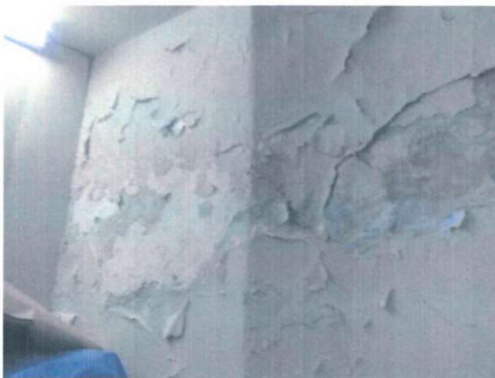
DESPRENDIMIENTO DE TARRAJEO Y PINTURA EN MUROS, NECESITA DE SELLADOR E IMPERMEABILIZACION EN MUROS
