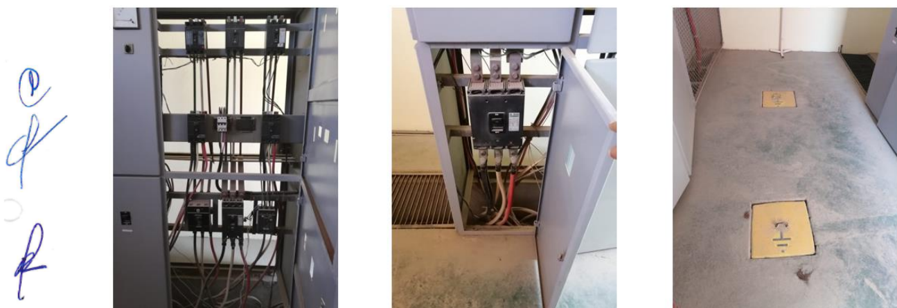
DE IZQUIERDA A DERECHA: DETALLE DEL TABLERO DE DISTRIBUCIÓN, POZOS A TIERRA.
