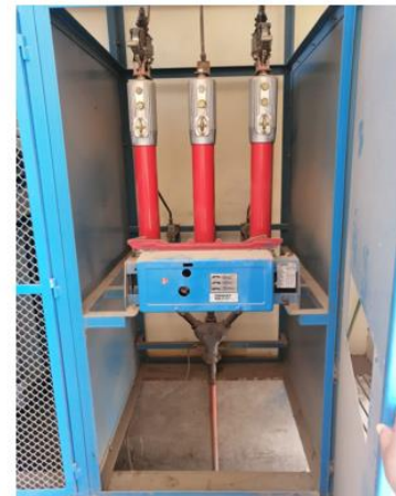
DE IZQUIERDA A DERECHA: TRANSFORMADOR 4 (200KW), SECCIONADOR TRIPOLAR.
