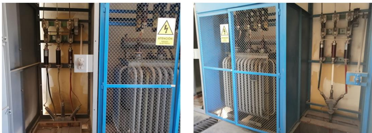
DE IZQUIERDA A DERECHA: SECCIONADOR TRIPOLAR, TRANSFORMADOR 3 (300KW), SECCIONADOR TRIPOLAR.
