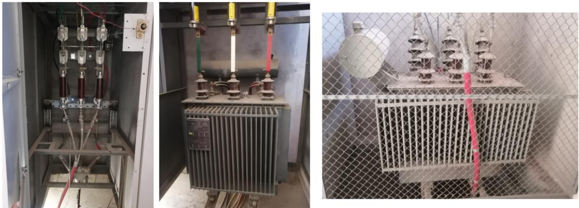
DE IZQUIERDA A DERECHA: SECCIONADOR TRIPOLAR, TRANSFORMADOR 2 (160KW), TRANSFORMADOR 1 (320KW)
