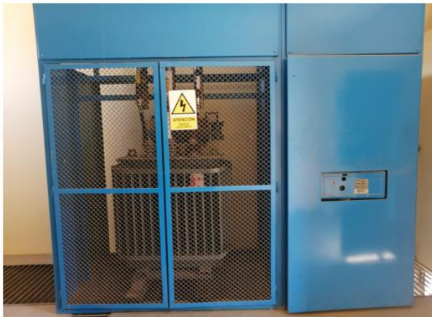
DE IZQUIERDA A DERECHA: TRANSFORMADOR 4 (200KW), SECCIONADOR TRIPOLAR.
