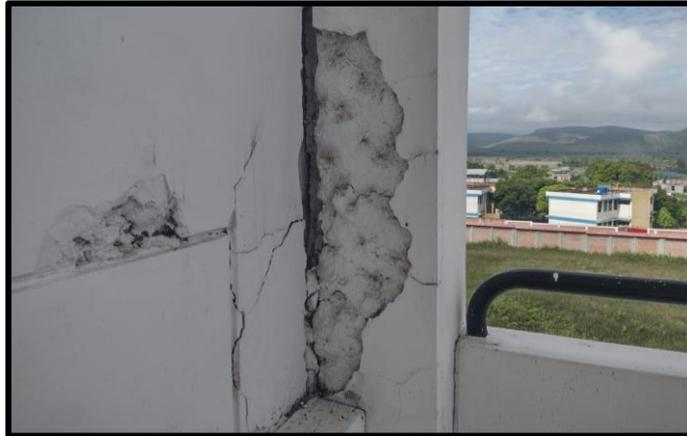
*Ilustración 2: Se visualiza el desprendimiento del concreto en un elemento estructura quedando expuesto el acero. Debido a las filtraciones de agua pluvial que existían anteriormente.*
