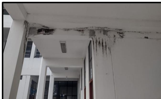
*Ilustración 3: Presencia me moho en elementos estructurales y muro.*
