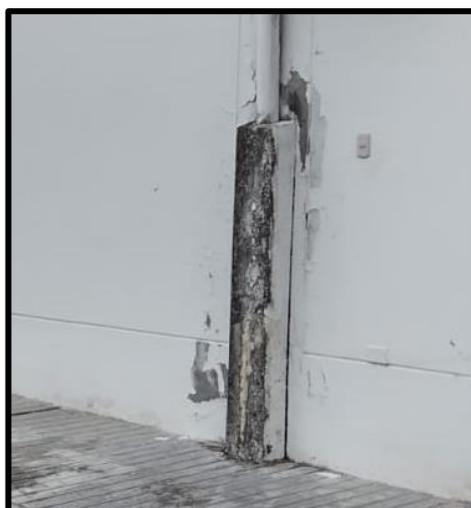
*Ilustración 6: Se visualiza el desprendimiento de concreto, perdida de color en la pintura y presencia de moho en el tabique con bajada de montaje.*
