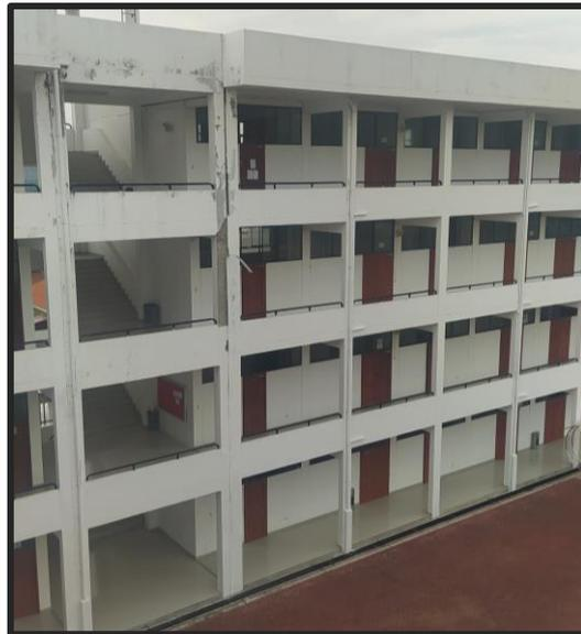
*Ilustración 5: Se visualiza es desprendimiento de los tapajuntas exteriores. Además, perdida de color de la pintura y del tarrajeo.*
