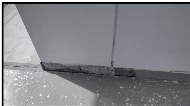
*Ilustración 4: Se visualiza el desprendimiento de contrazocalos, debido a la presencia de la humedad.*
