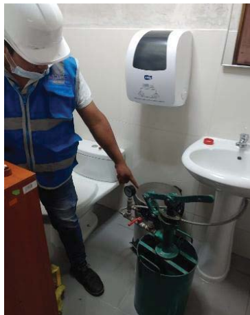
Se realiza la conexión de la manguera del balde hidráulico con la tubería de la red del baño
