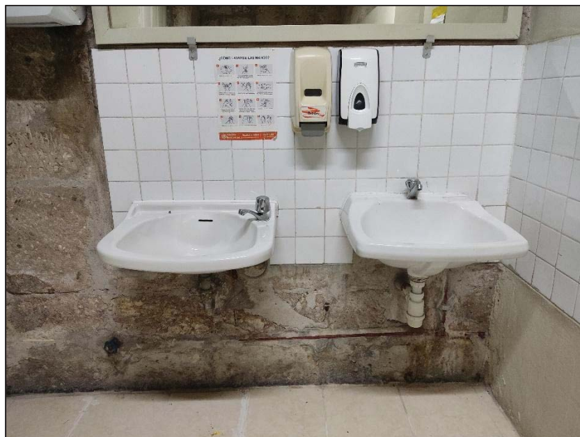
BLOQUE 6: Batería de baño para personal del banco, tuberías de instalaciones sanitarias expuestas, lavamanos inhabilitado, des uniformidad de los acabados arquitectónicos.
