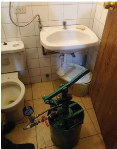
Prueba Hidráulica realizada en el Bloque 3, destinado al destacamento
