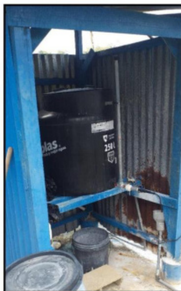
Imagen: Sistema de Cloración artesanal (Reservorio 1)
