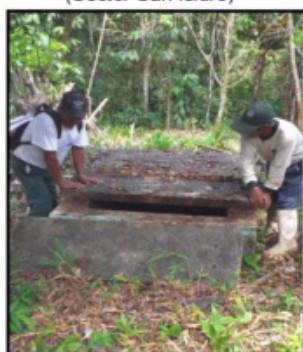
Imagen: Caja de distribución de caudales. (Sector San Isidro)
