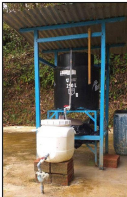
Imagen: Sistema de Cloración Artesanal (Reservorio 3)
