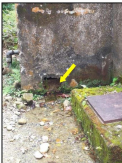
Imagen: Orificio en la estructura
