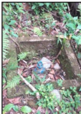
Imagen: Válvula de purga en Línea de Conducción.
