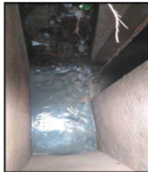
Imagen: Interior de Cámara de rejillas, con falta de mantenimiento.
