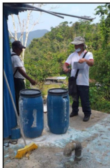
Imagen: Sistema de Cloración artesanal (Reservorio 1)
