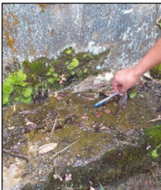
Imagen: Fisura y filtración de agua en muro (Reservorio 1).
