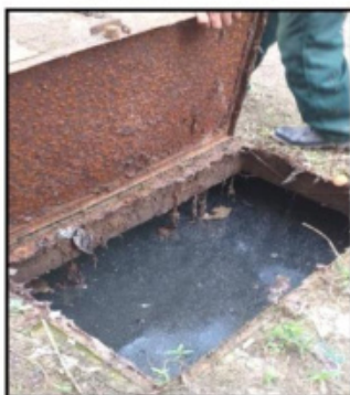
Imagen: Tanque séptico colmatado por falta de mantenimiento. (Sector San Isidro)
