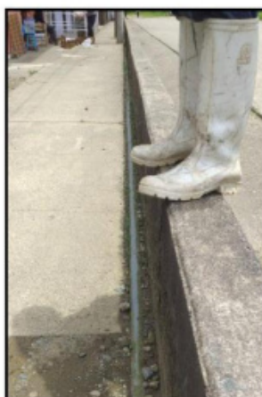
Imagen: Tubería de agua expuesta.
