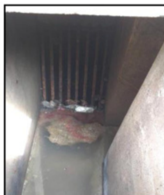
Imagen: Interior de Cámara de rejas, sin mantenimiento. (Sector San Isidro)
