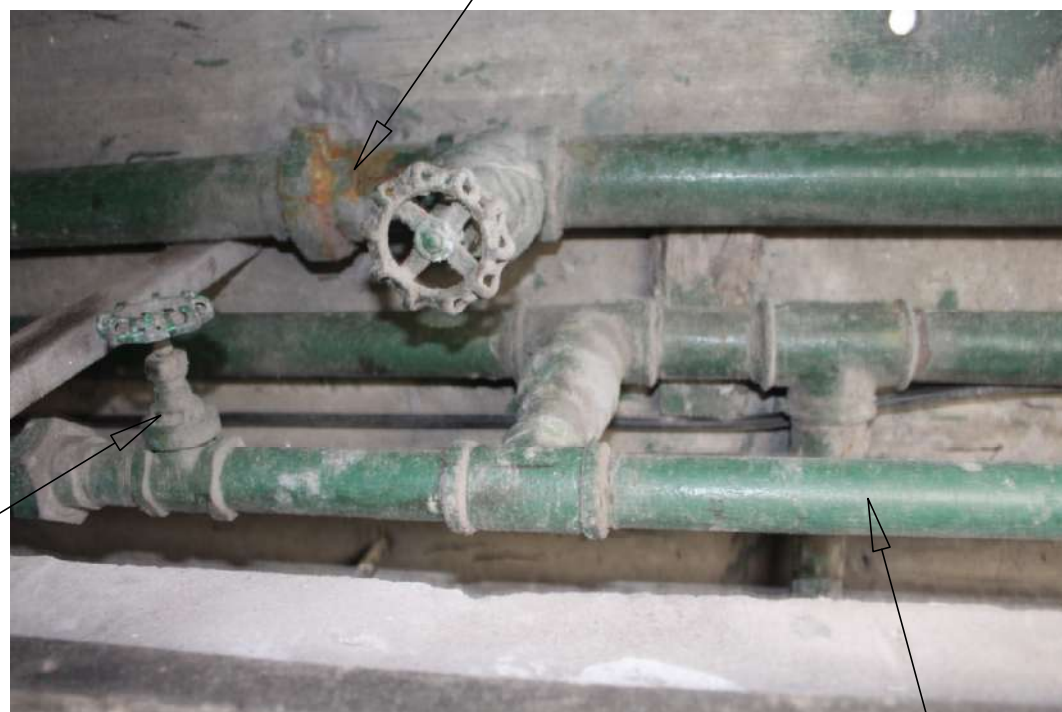
TRAMO EN FIERRO GALVANIZADO CON PRESENCIA DE CORROSION
