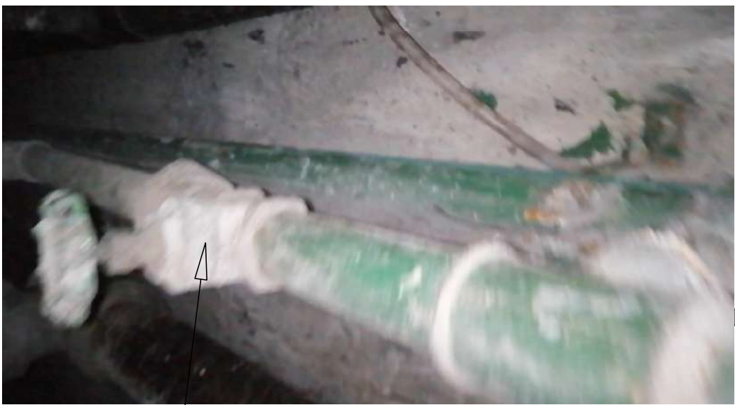
VALVULA DE CONTROL EN MAL ESTADO
