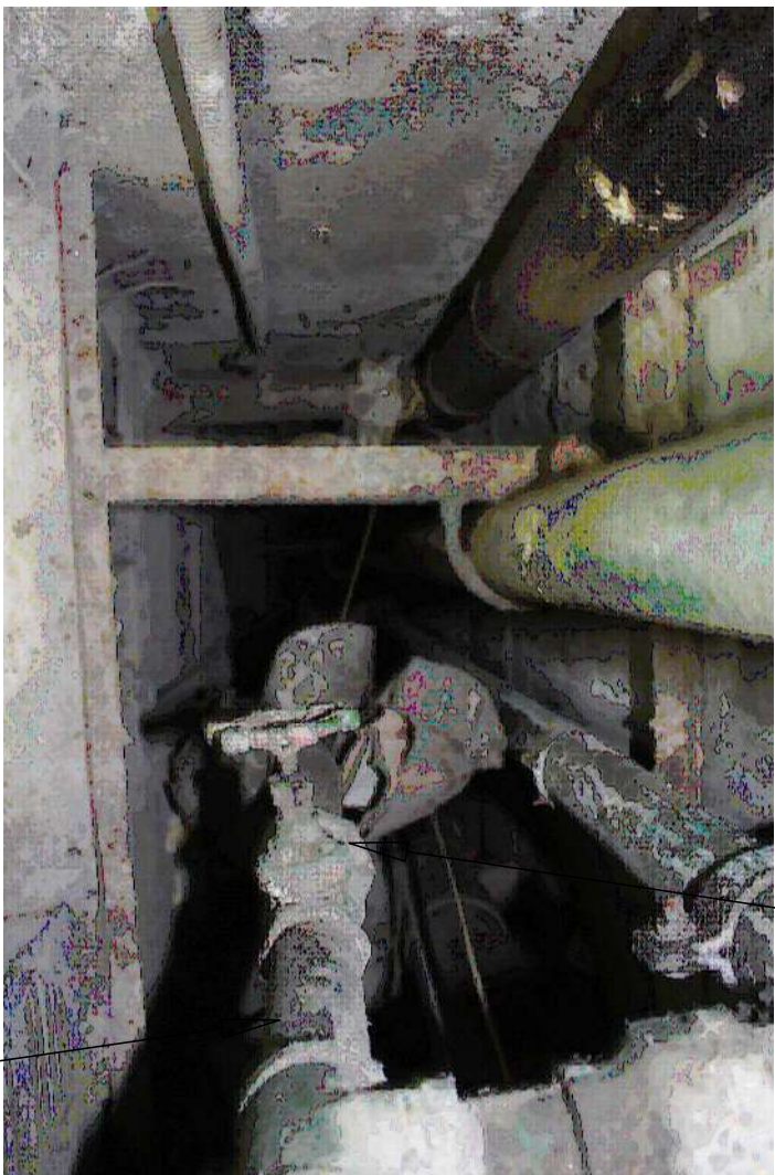
VALVULA DE CONTROL EN MAL ESTADO
