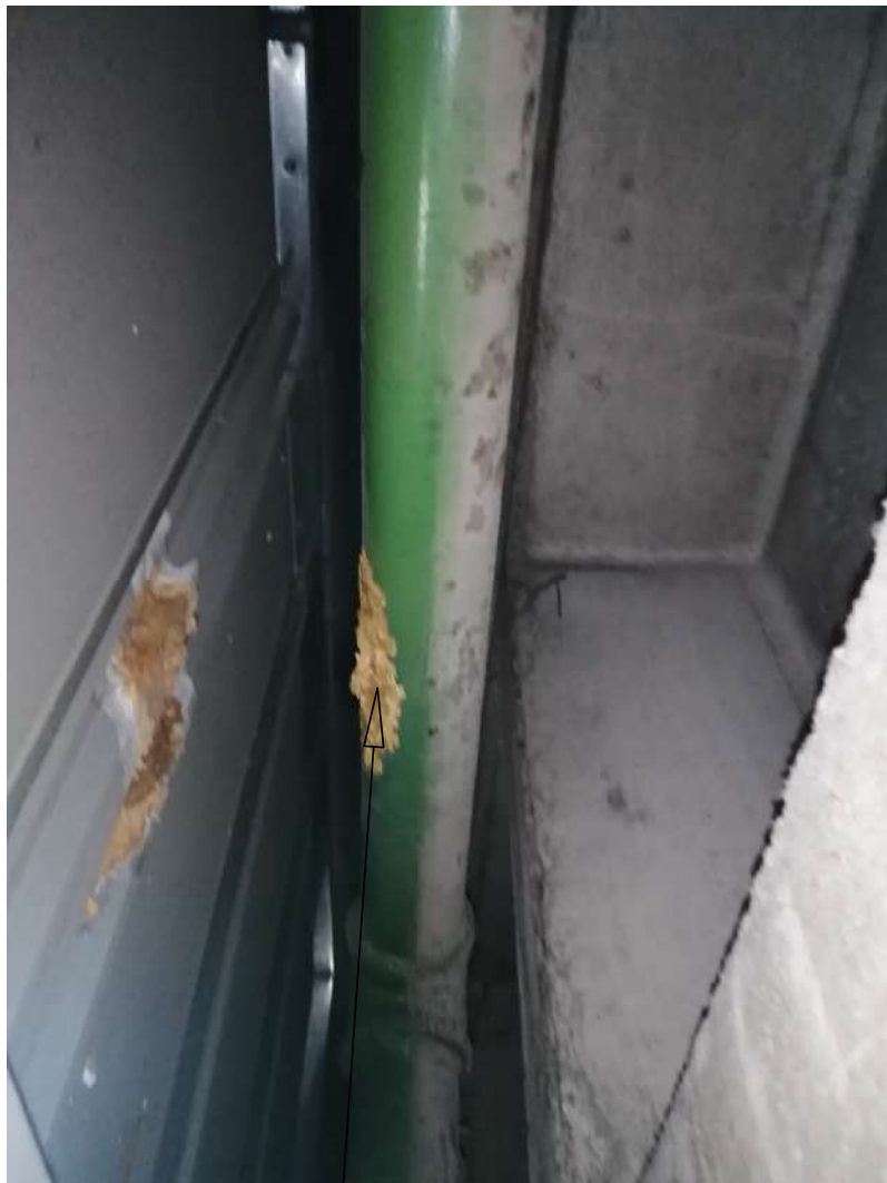
TRAMO EN FIERRO GALVANIZADO, CON PRESENCIA DE CORROSION
