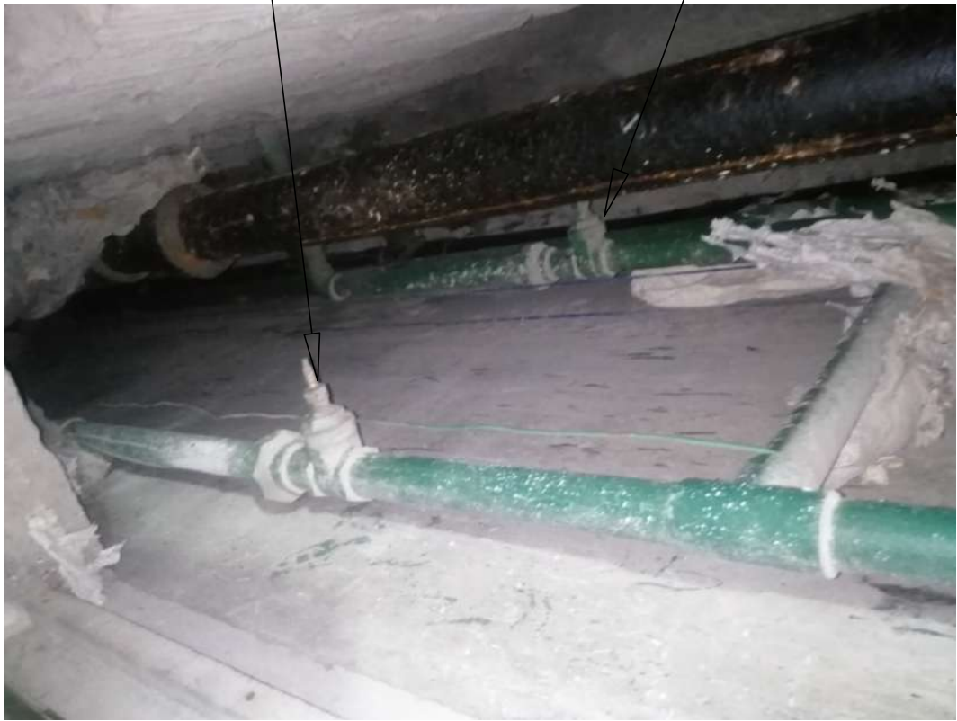
VALVULA DE CONTROL EN MAL ESTADO
