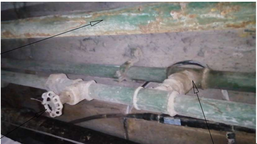
VALVULA DE CONTROL EN MAL ESTADO TRAMO EN FIERRO GALVANIZADO, CON PRESENCIA DE CORROSION
