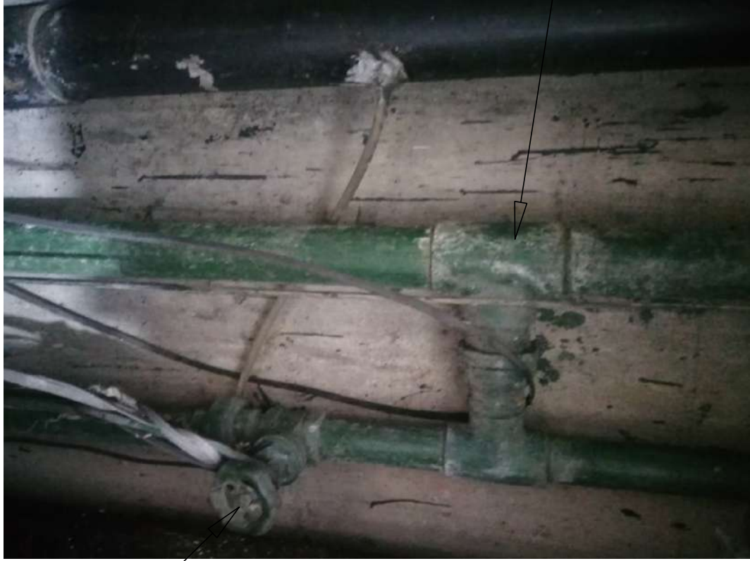
VALVULA DE CONTROL EN MAL ESTADO
