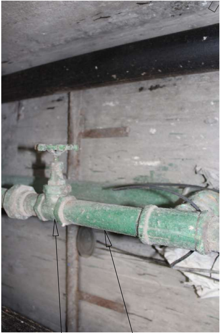
TRAMO EN FIERRO GALVANIZADO VALVULA DE CONTROL EN MAL ESTADO
