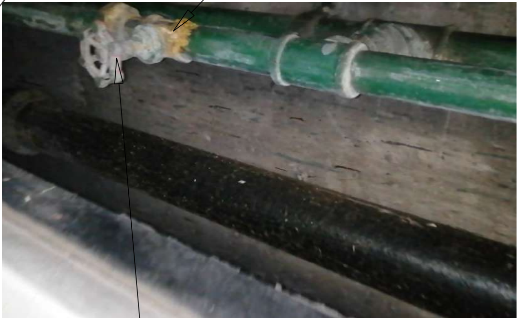
VALVULA DE CONTROL EN MAL ESTADO
