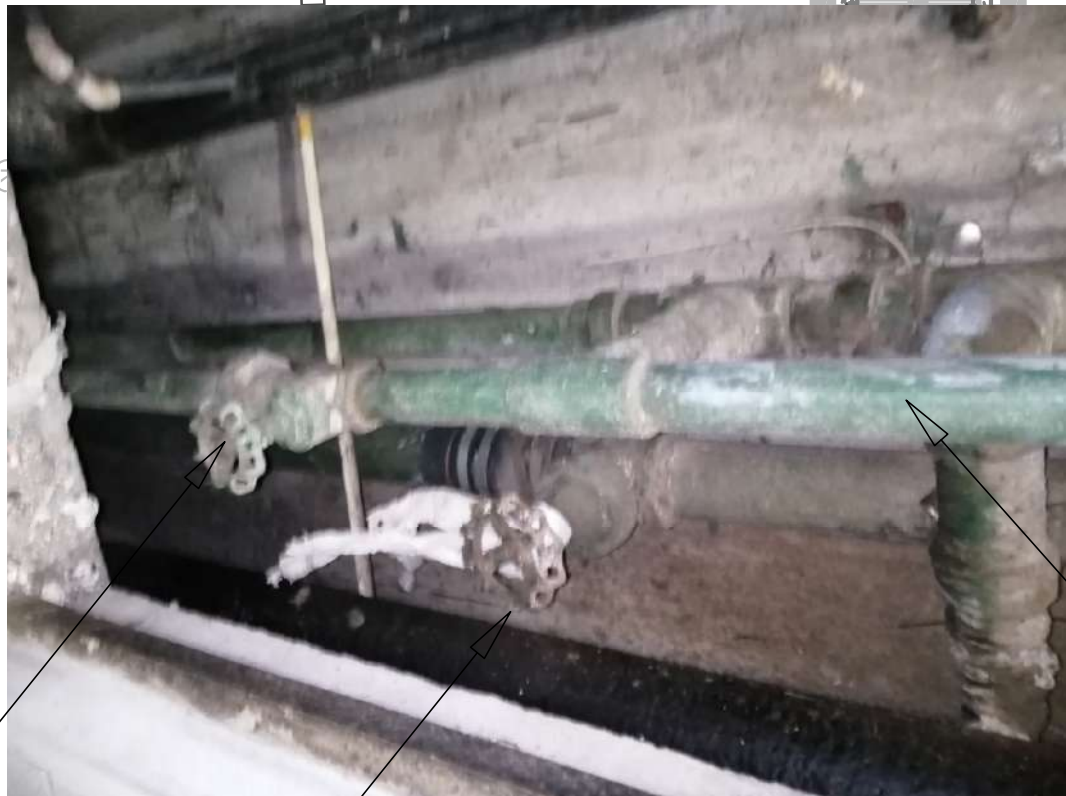
VALVULA DE CONTROL EN MAL ESTADO
