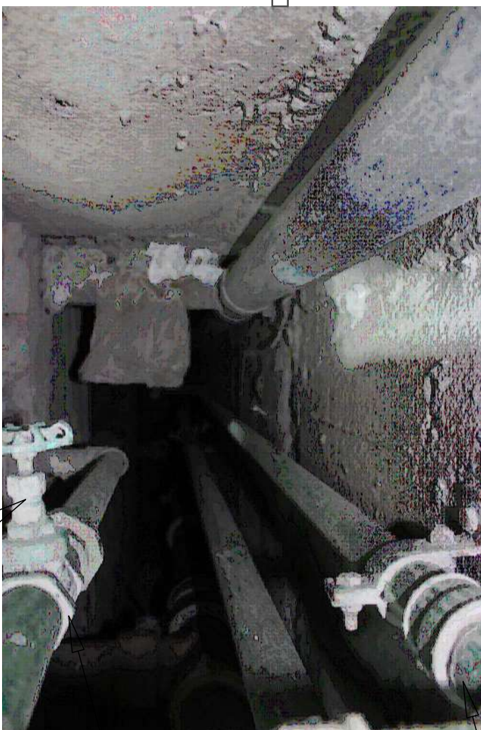
VALVULA DE CONTROL EN MAL ESTADO
