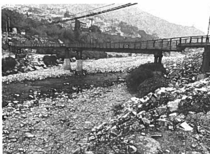
Vista del puente Perez de Cuellar en pesimas condiciones, sus pilares no estan protegidos y existe
