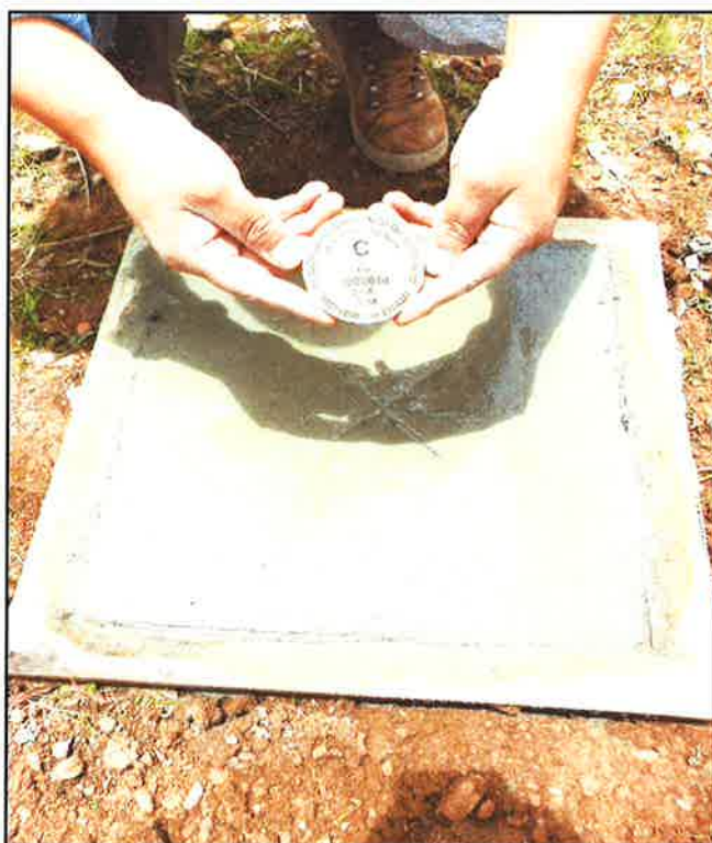
Fotografía N° 10: Vaciado y acabado del punto con las medidas correspondientes, para la colocación de la placa de bronce.
