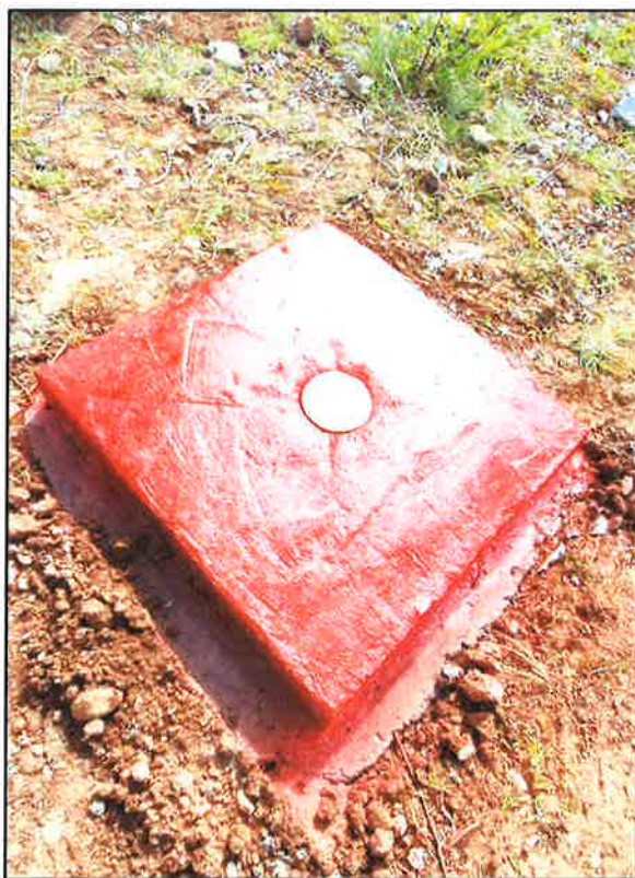
Fotografía N° 16: Vista panorámica del punto geodésico 1002044 con su acabado final.
