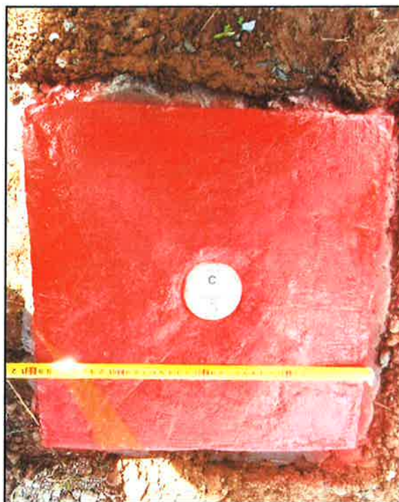
Fotografía N° 14: Pintado y verificación de dimensiones del punto geodésico 1002044.
