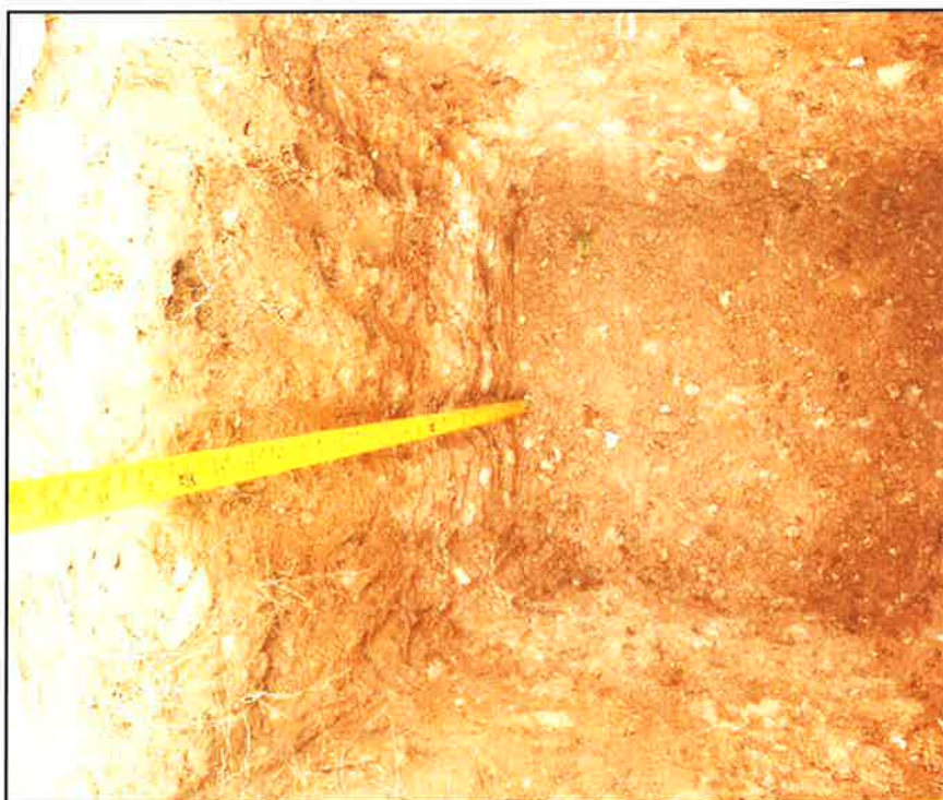
Fotografía N° 08: Verificación de la profundidad de 60 cm, para la monumentación del punto Geodésico.
