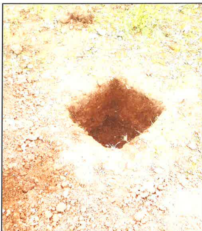
Fotografía N° 07: Vista de la excavación manual, para la monumentación del Punto Geodésico.
