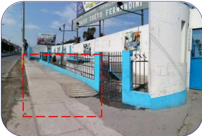
Fotografía N°02.- Vista de desnivel y rampa temporal en ingreso principal, se requiere rampa de acceso según normativa.
