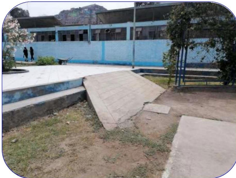
Fotografía N°04.- Vista de desnivel y rampa temporal en zona de cancha de futbol, se requiere rampa de acceso según normativa.
