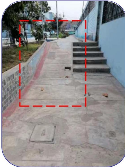
Fotografía N°03.- Vista de desnivel y rampa temporal en pasadizo, se requiere rampa de acceso según normativa.
