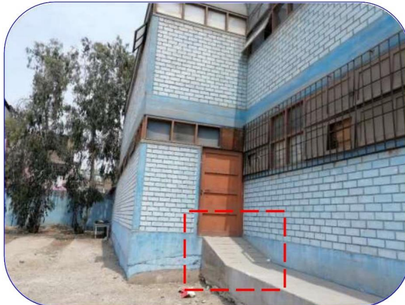
Fotografía N°06.- Vista de desnivel y rampa temporal en zona de auditorio, se requiere rampa de acceso según normativa.
